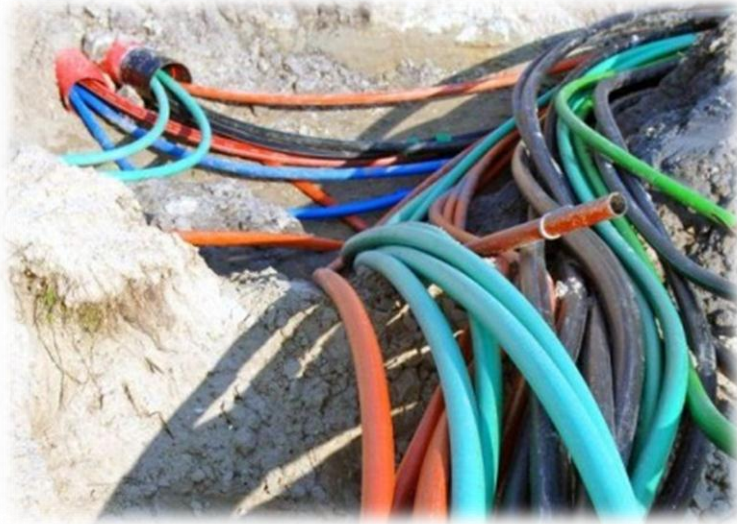
Figuur 4: Kabels en leidingen.
