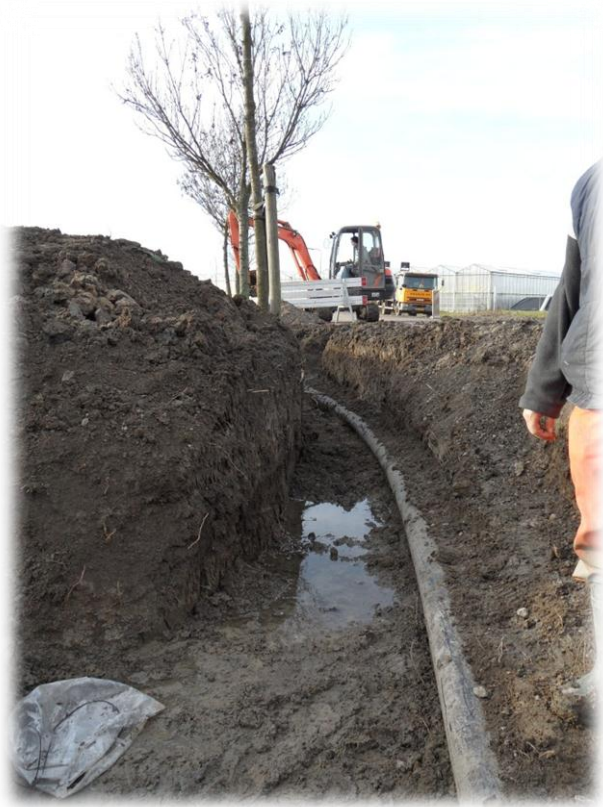
Figuur 6: Aanleg van persleiding.
