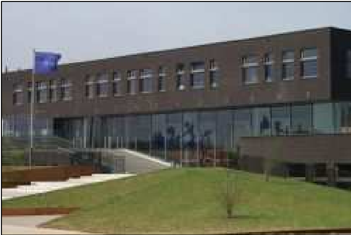
Voorbeelden van een schoolgebouwen met een herkenbaar plint
