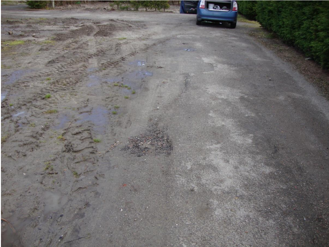
Figuur 2-3 Asfalt uit 1998
