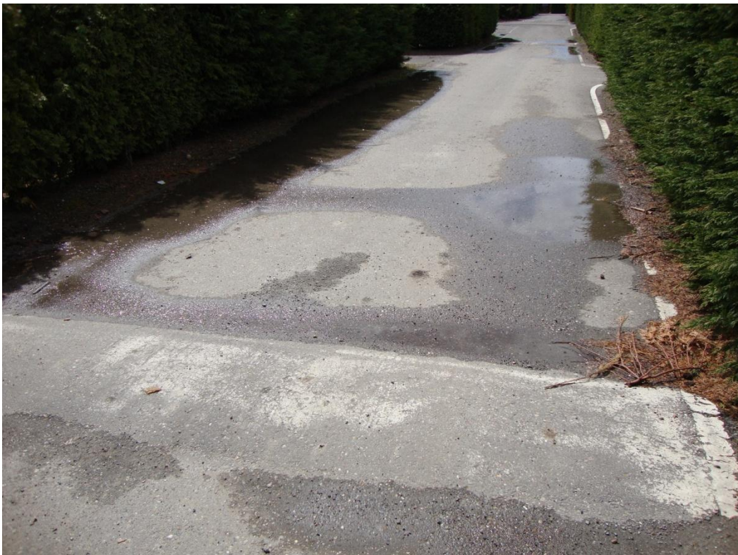
Figuur 2-4 Asfalt uit 2003
