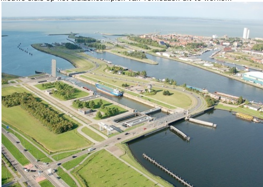
Figuur 1-1 Het sluizencomplex Terneuzen
