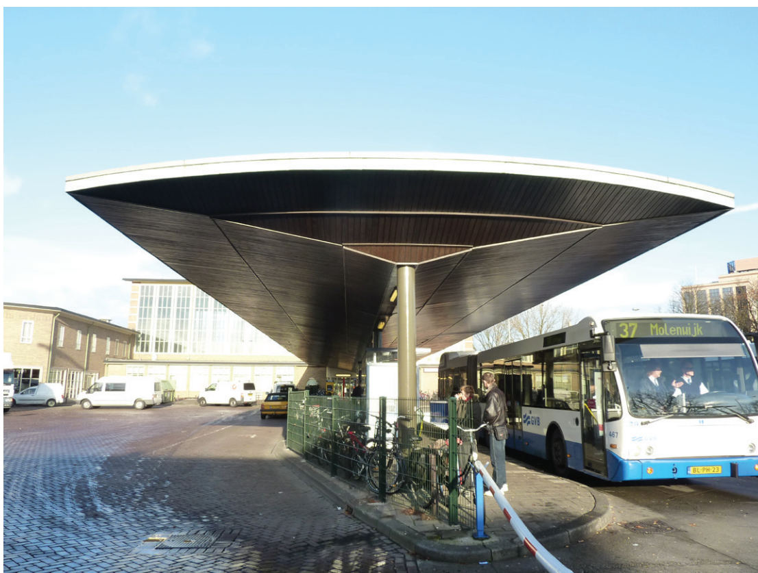
Huidige situatie luifel van de zuidelijke entree van het station.
