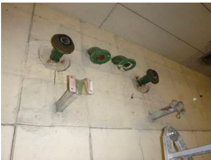
foto: geen asbesthoudende flensverbindingen
