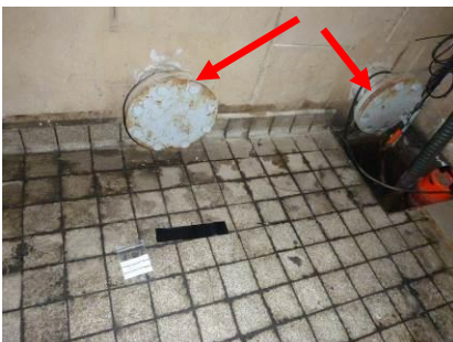
foto: geen asbesthoudende flensverbindingen
