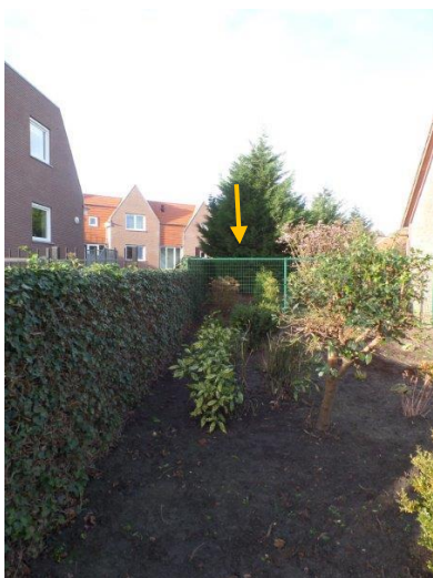
foto 1: begin punt opvangdrainage vanaf hekwerk (noordwestelijke richting)
