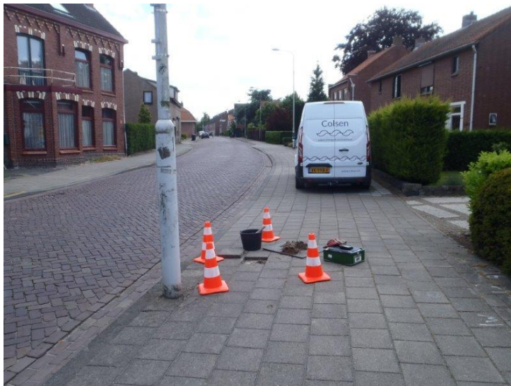
foto 11 Zoutestraat, boring 402 (oostelijke richting)
