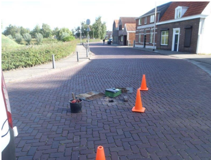
foto 2 boring 101 (noordelijke richting)
