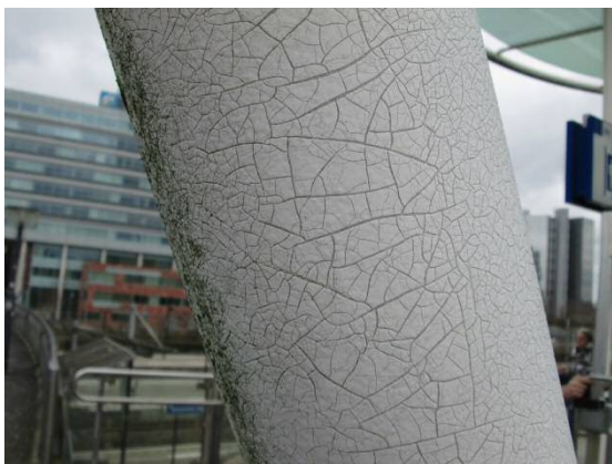
5. Sterk gecraqueleerd systeem kolommen e.d. passerelle.
