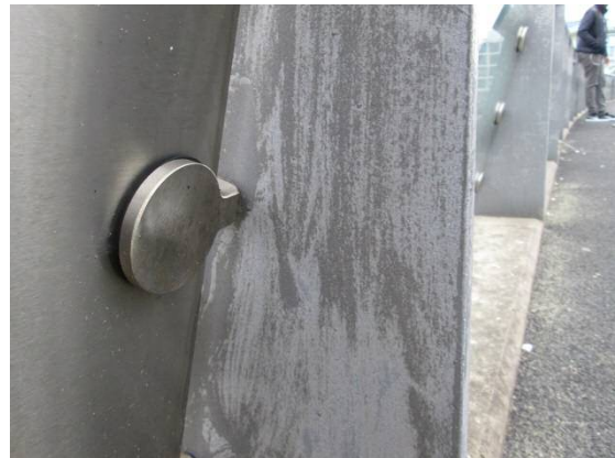
4. Onthechting blanke afwerklaag op balusters passerelle.
