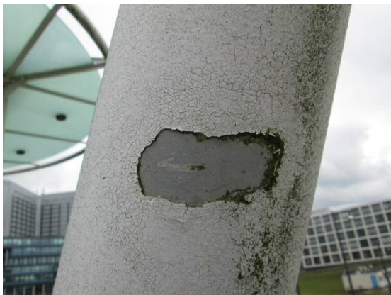
7. Onthechting verfsysteem passerelle.
