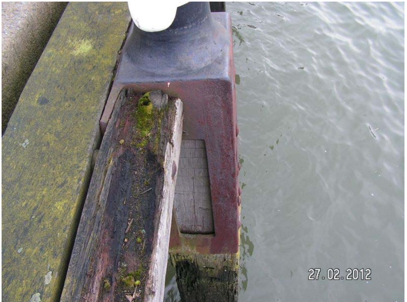
Foto 1 detail houten paal met paalmuts
