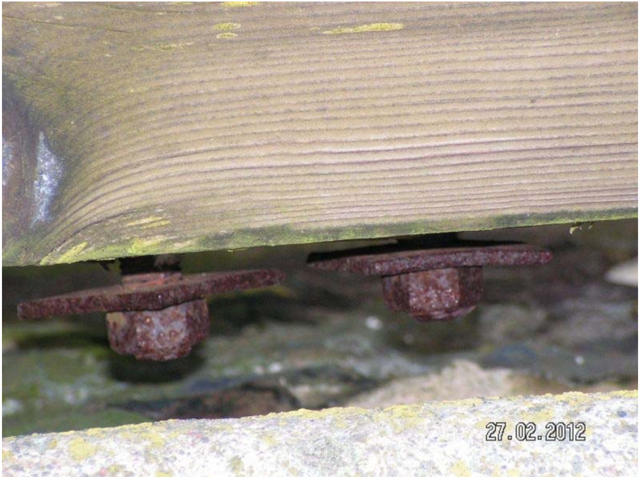
Foto 10 losse bouten aan de kaderanzijde
