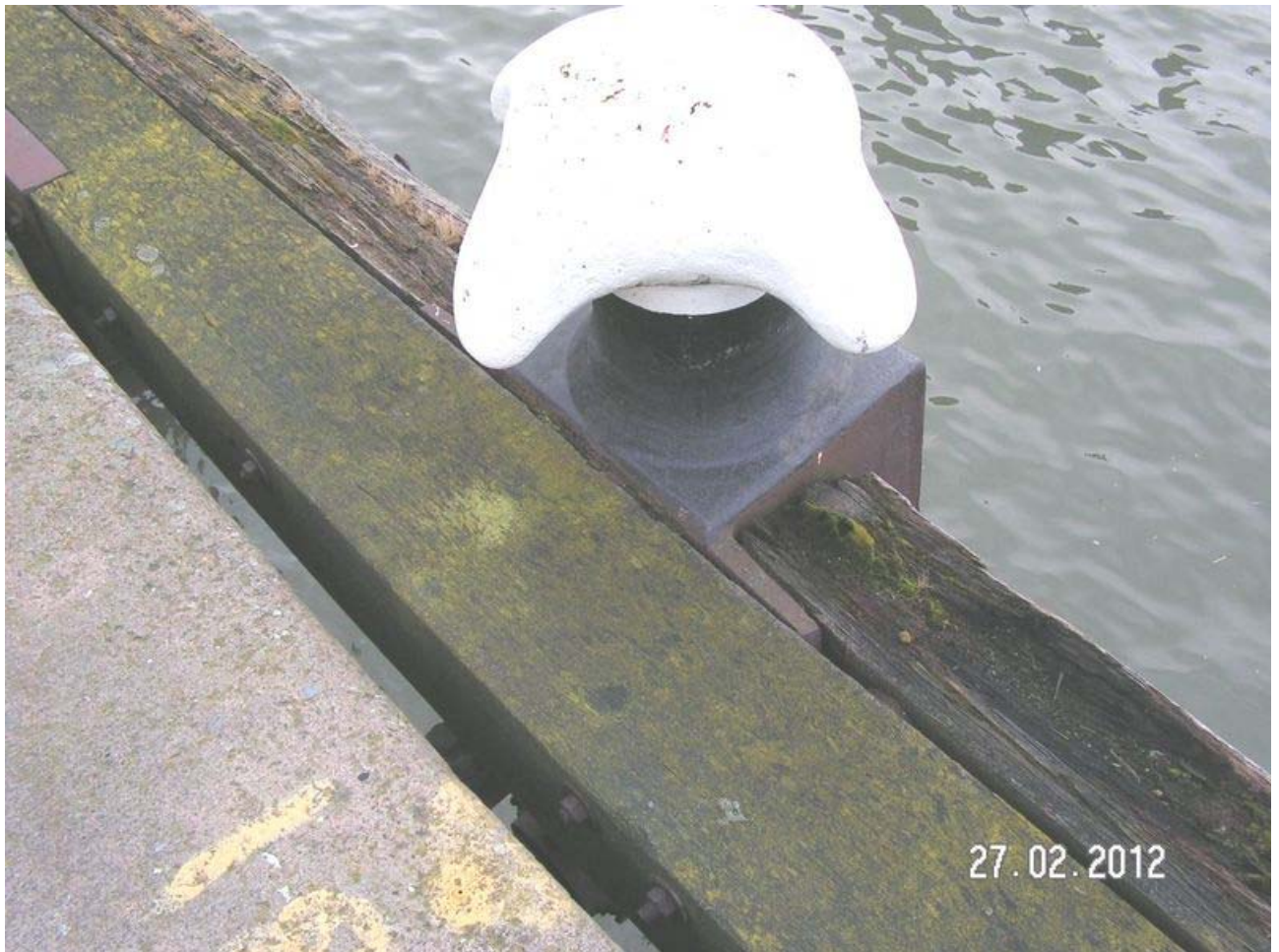
Foto 2 bevestiging gordingen aan de houten paal
