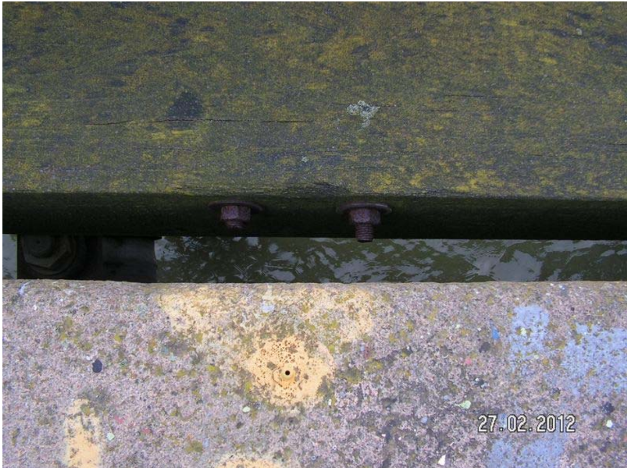
Foto 8 detail bouten aan de kadezijde
