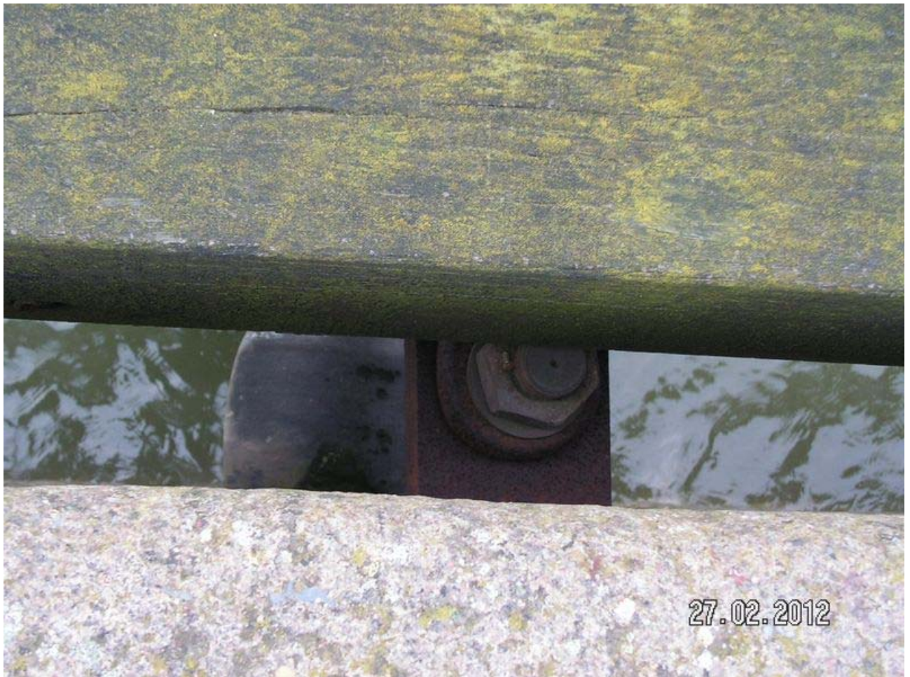
Foto 9 detail bevestiging koningspaal aan het anker wat door de kade steekt
