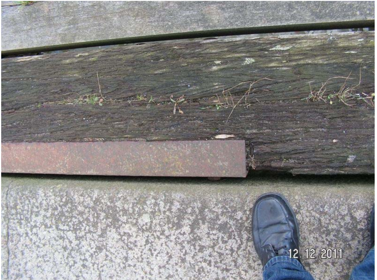
Foto 13 verbinding middels een stalen profiel
