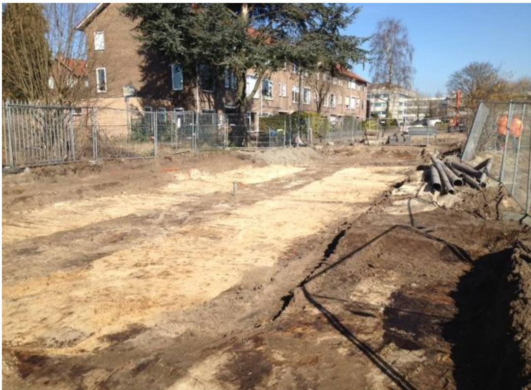
Overzichtfoto van een gedeelte van de ontgraven A. Fokkerweg tot aan de schone ondergrond.
