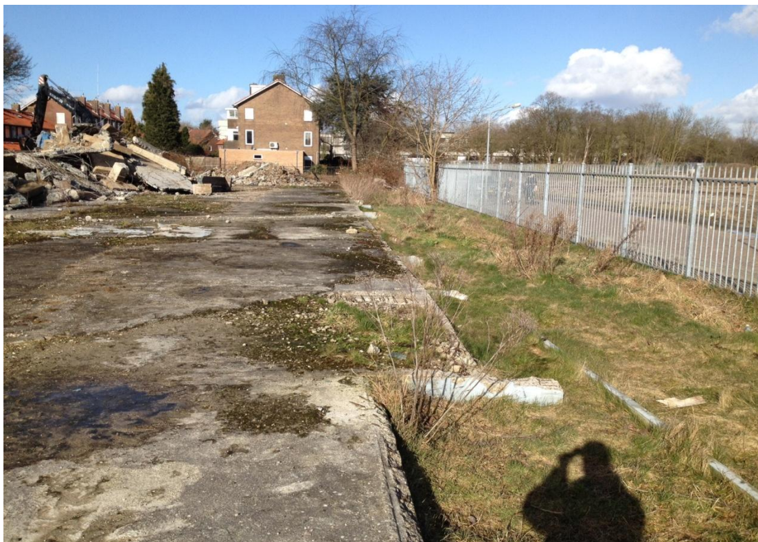
Slopen van de oude fundering van de voormalige Kapperschool.
