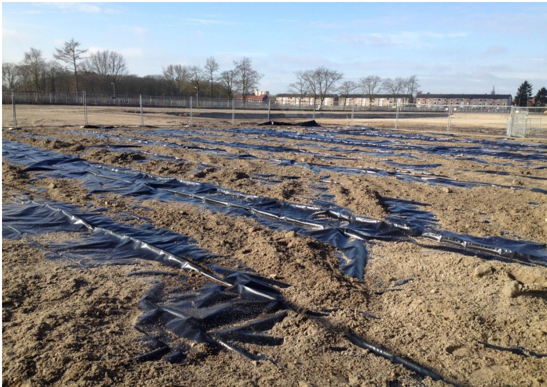
Aangelegd tijdelijk foliedepot voor opslag van stortmateriaal.
