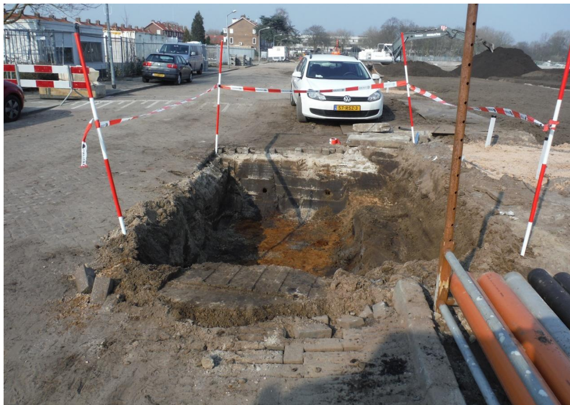
Overzichtfoto van de ontgraving ter plaatse van boring 203 in de A. Fokkerweg.
