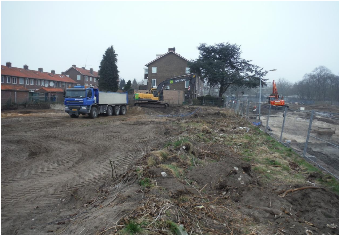
Ontgraven verontreinigde grond met stortmateriaal op de locatie voormalige Kapperschool in fase 2. De laag stortmateriaal lag rondom het gebouw.
