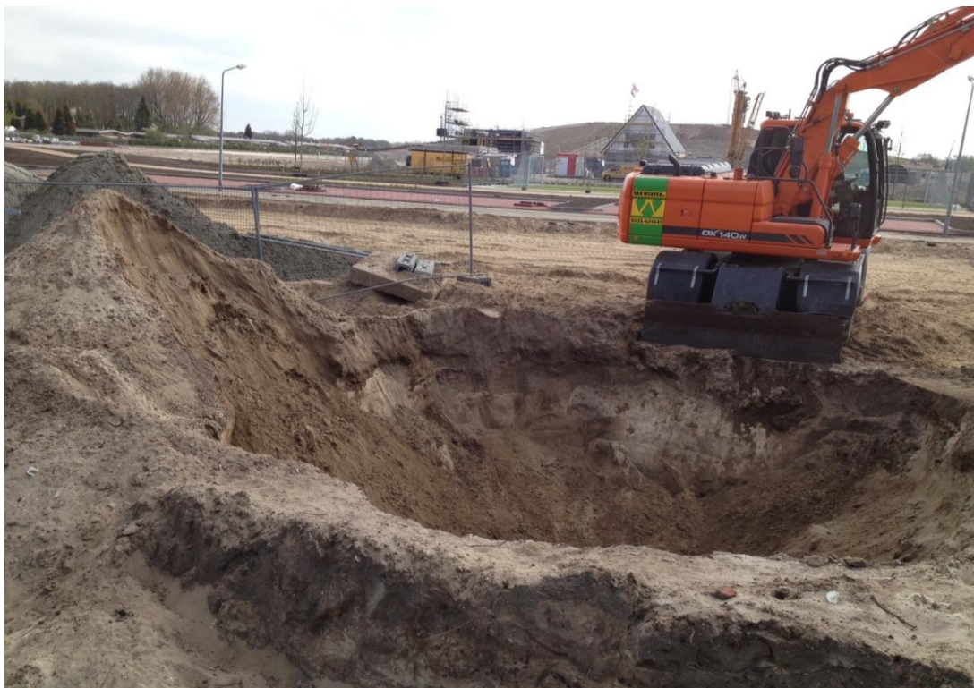
Ontgraven verontreinigd tankgat van de 5 m 3 olietank en de verontreinigde grond afvoeren naar Theo Pouw. De zintuiglijk schone bovengrond is aan weerszijde van het gat in depot gezet.
