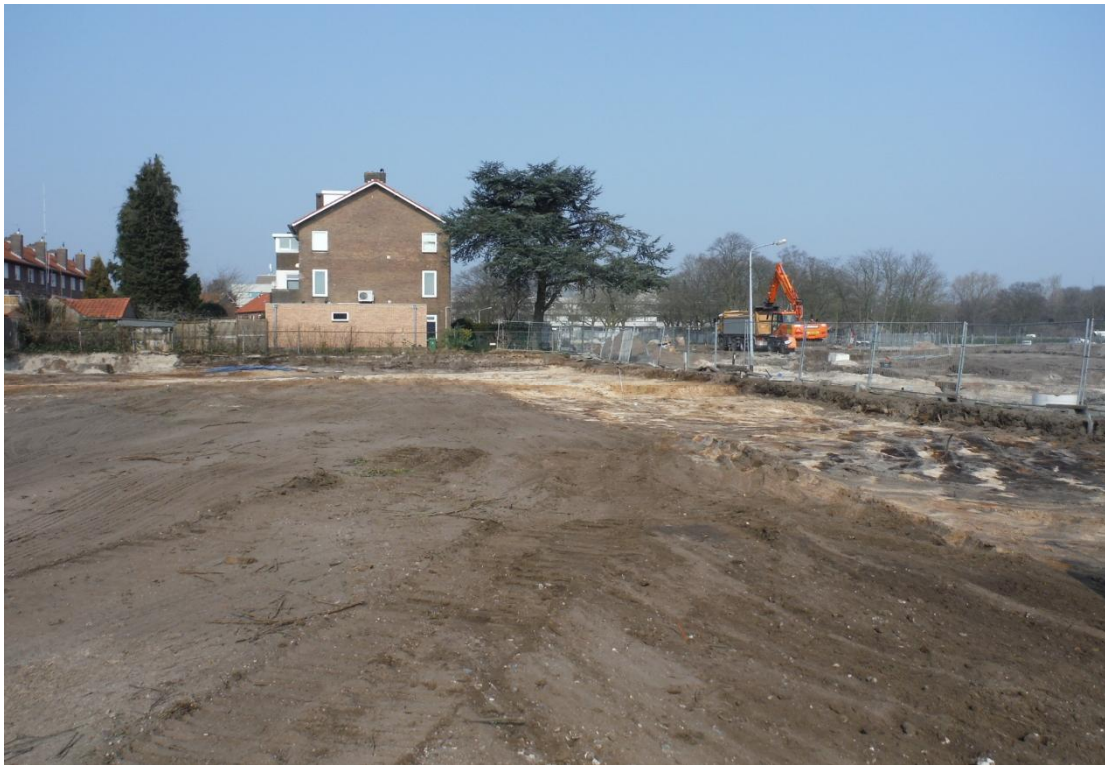
Overzichtfoto van de ontgraving van fase 2.
