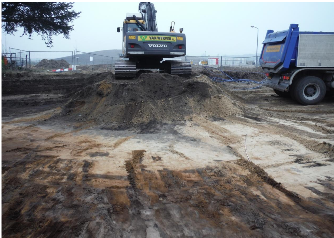
Ontgraven verontreinigde grond tot op de zintuiglijk schone ondergrond in fase 2. Afvoeren verontreinigde grond naar het foliedepot.
