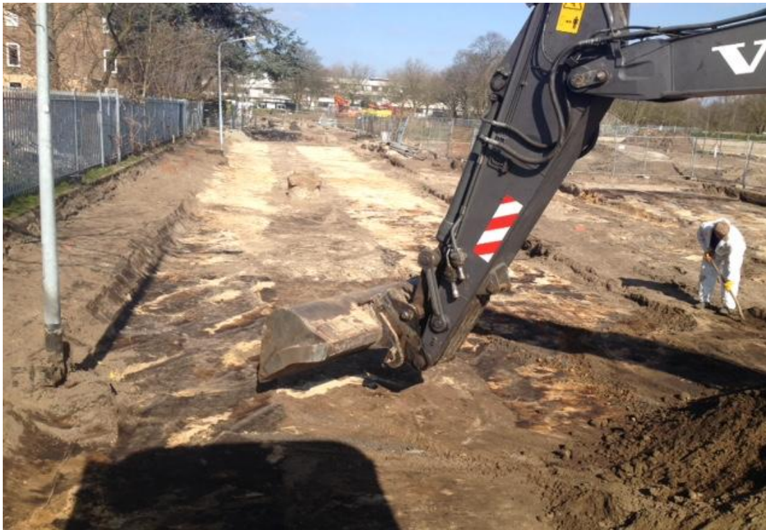
Overzichtsfoto van de gehele ontgraving van fase 1 in de Antony Fokkerweg. Links de ontgraving in de stoep tot op de kabels en leidingen.
