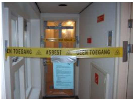
foto 03: toegang vanuit de gang
