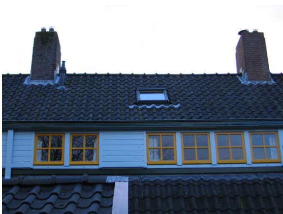
Dakraam achterzijde eenlaagse bebouwing Trendsetter Beijerinckstraat 4
