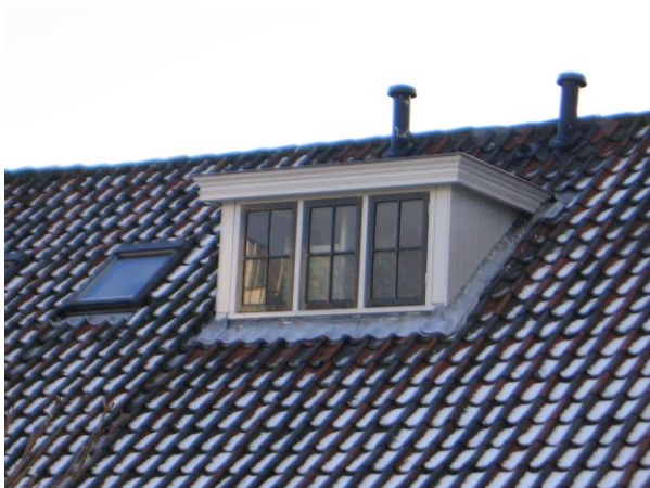
Dakkapel achterzijde Trendsetter Frederik Matthesstraat 13-15
