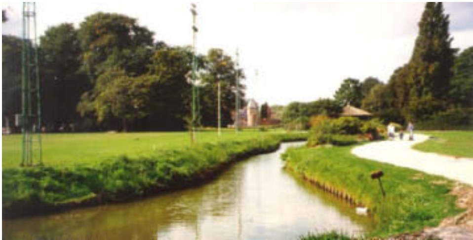
Combinatie van sport, water en recreatiedoeleinden in de stad (voorbeeld Waterpark, Antwerpen)
