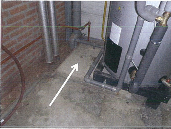
Foto 8: Gebouw R11: ruimtes achter vaste wand-, plafond- en vloerdelen geen onderzoek uitgevoerd.
