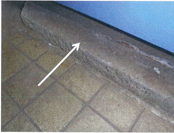
Foto 1: Gebouw HJ en HI: ruimtes achter vaste wand-, plafond- en vloerdelen geen onderzoek uitgevoerd.
