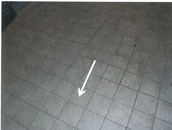
Foto 6: Gebouw R11: ruimtes achter vaste wand-, plafond- en vloerdelen geen onderzoek uitgevoerd.
