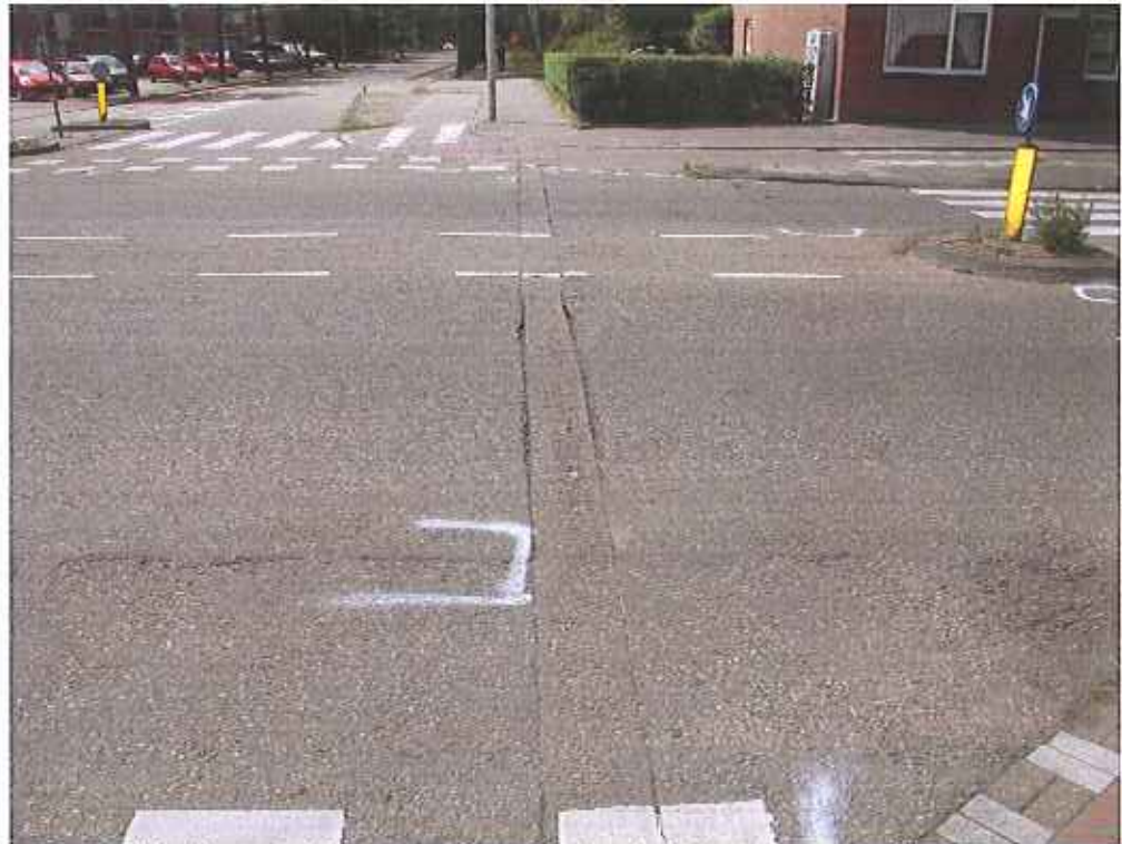
Foto 6 Kruising met Werengouw, reparatie sleuf diensten en bedrijven
