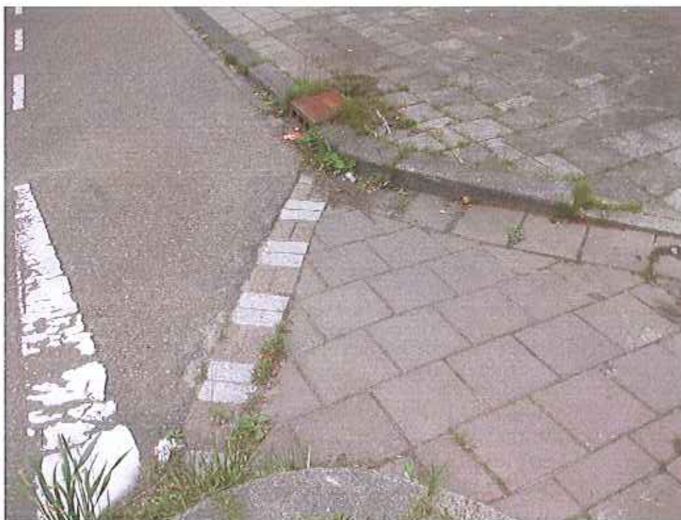
Foto 4 Overgang asfalt - fietspad
