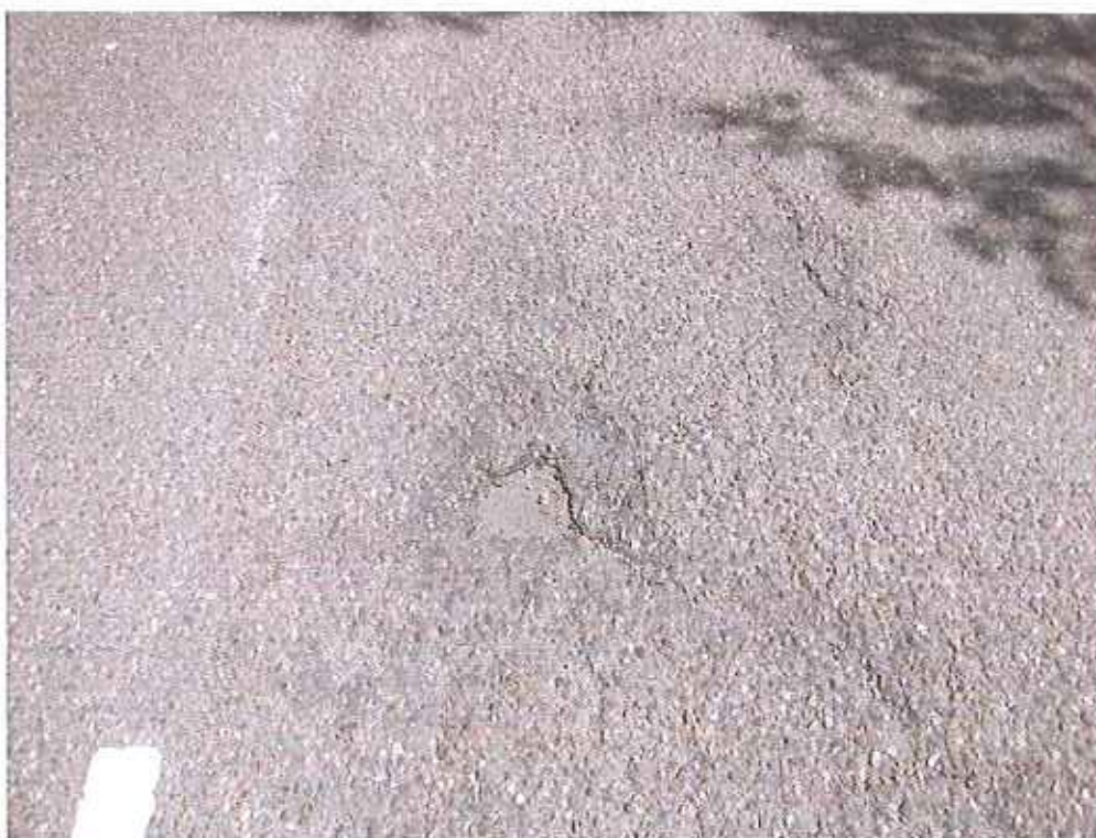
Foto 9 Gat, ernstige rafeling en ernstige scheurvorming.
