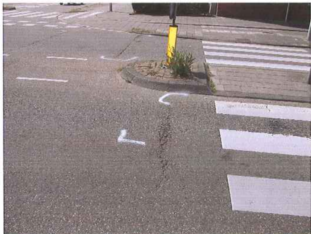
Foto 7 Kruising met Werengouw, ernstige scheurvorming.
