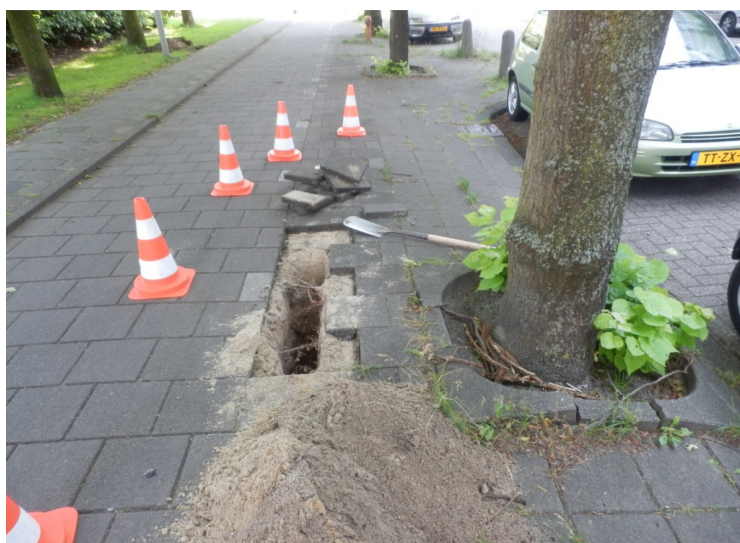
Foto 7, de sleuf voor het riool komt op de rand van het fietspad
