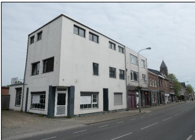
Figuur 3. Voorzijde bebouwing binnen het plangebied.
