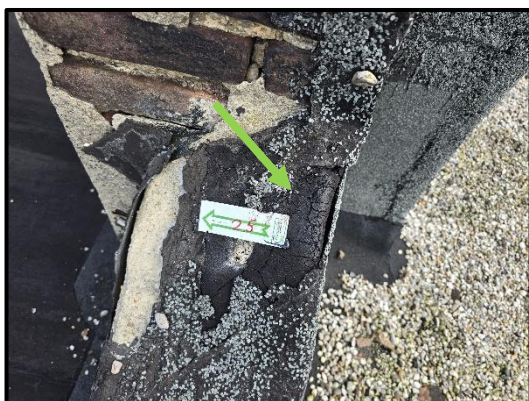
M2.5 – bitumen dakbedekking schoorsteen niet asbesthoudend.
