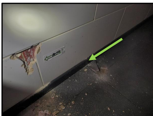
M50 – tegellijm is niet asbesthoudend.
