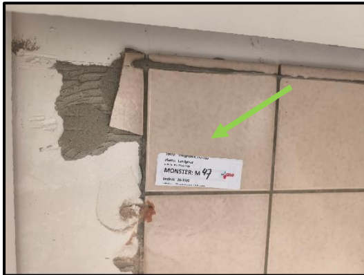
M47 – tegellijm is niet asbesthoudend.
