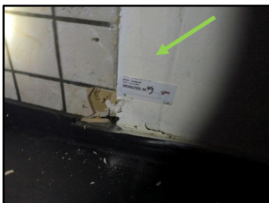
M49 – tegellijm is niet asbesthoudend.
