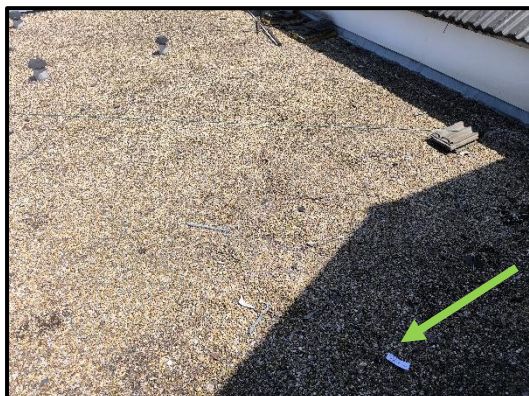
M43 – bitumen dakbedekking is niet asbesthoudend.
