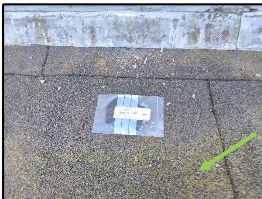
M45 – bitumen dakbedekking is niet asbesthoudend.
