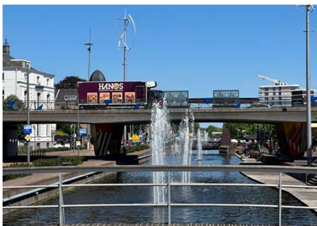
De Kasteel-Traversal is een viaduct ten hoogte van het kanaal
