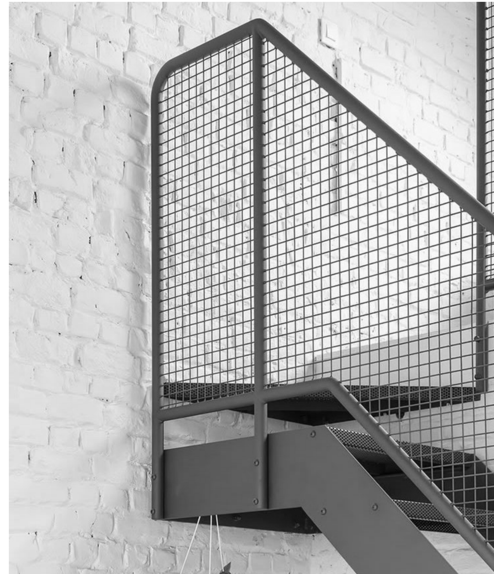
Referentie | trap gaas Referentie voor bevestiging van gaas aan trapleuning.
