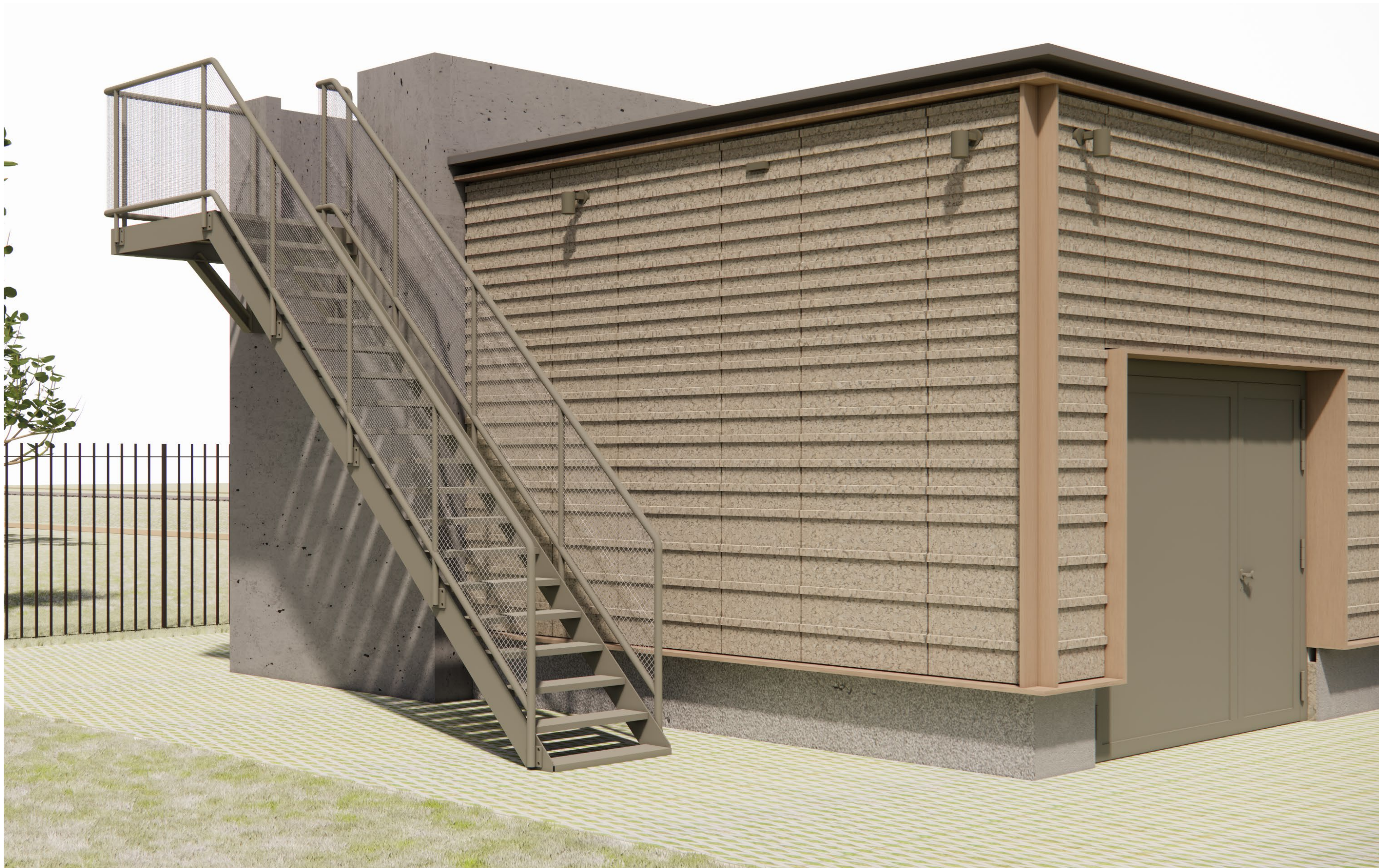
Impressie | trap Verzinkt stalen trap met gaas als leuning.
