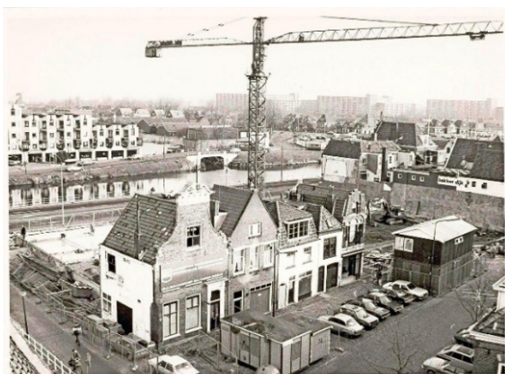
Figuur 26 Bouwplaats Karperton 1984
