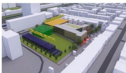
Fase 3 Nieuwbouw onderwijsgebouw vleugel west en sportgebouw
