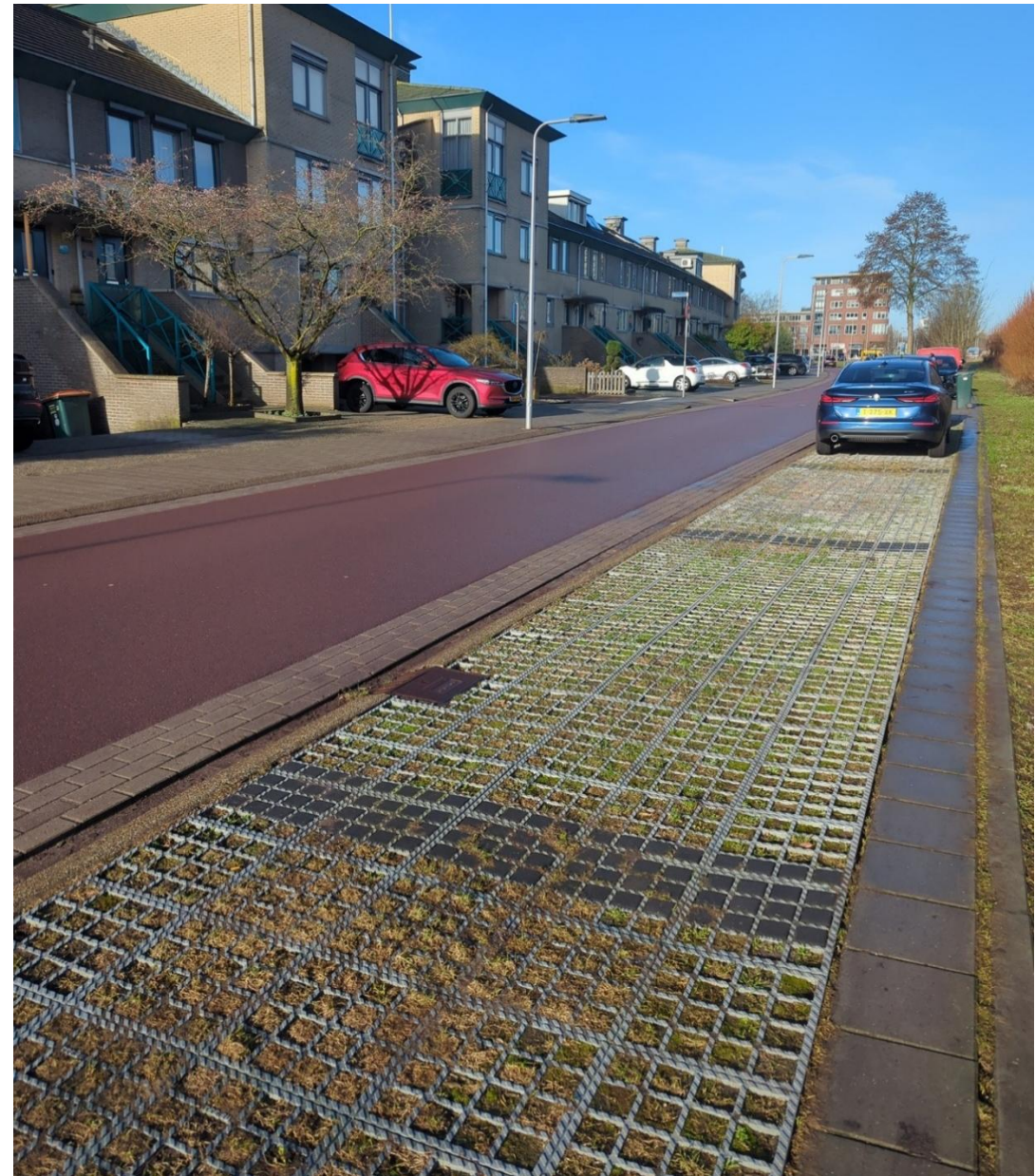
Reconstructie Verbindingsweg / Treviso
