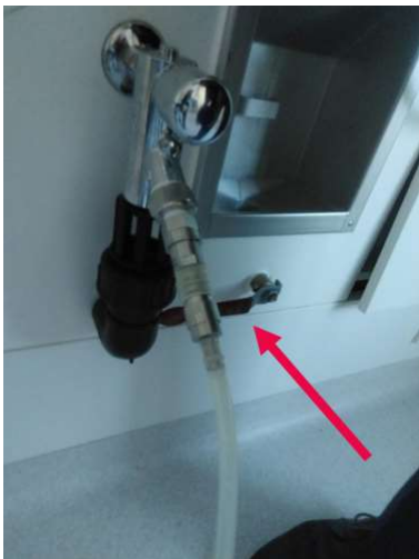
FOTO BIJ A525-52J: Foto 05 Opendraaien Hendel Dialyse Afvoerput
