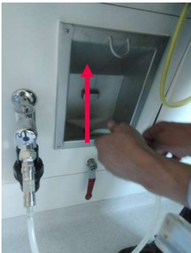
FOTO BIJ A525-52J: Foto 09 Uittrekken Doorspoelslang
