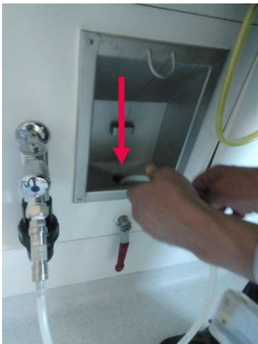
FOTO BIJ A525-52J: Foto 06 Plaatsen Doorspoelslang
