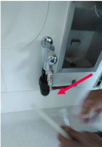
FOTO BIJ A525-52J: Foto 11 Afkoppelen Koppelstuk
