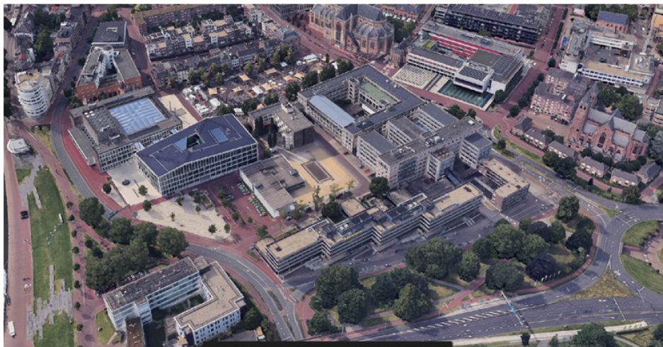
Luchtfoto bestaande situatie
