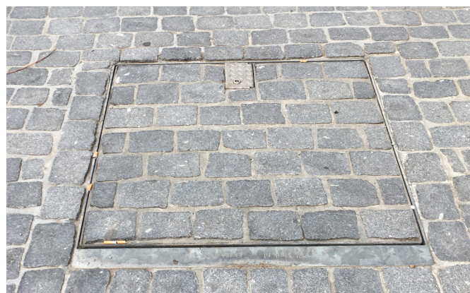
referentie afwerking van een putkast
