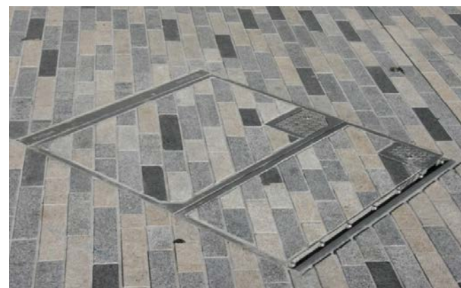
referentie afwerking van een putkast
