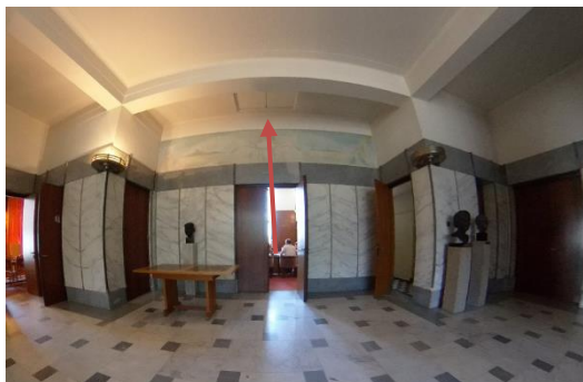
Hijsluik in plafond hal verdieping
