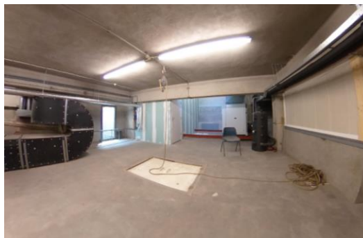
Hijsluik op zolder
