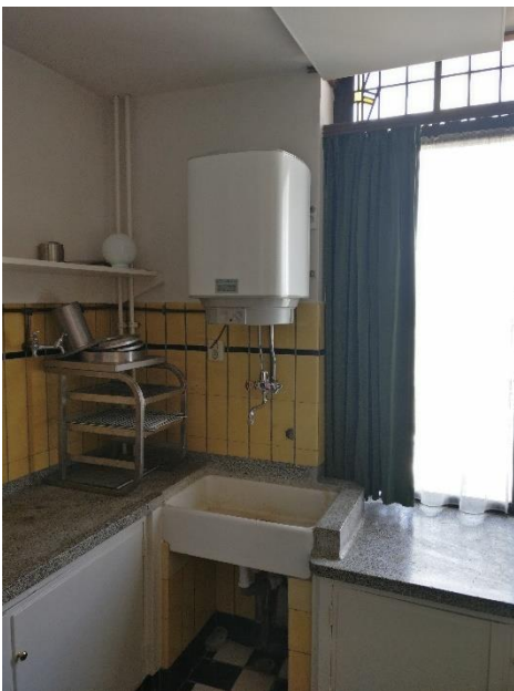
Voormalige keuken op verdieping (ruimte 2.6)
