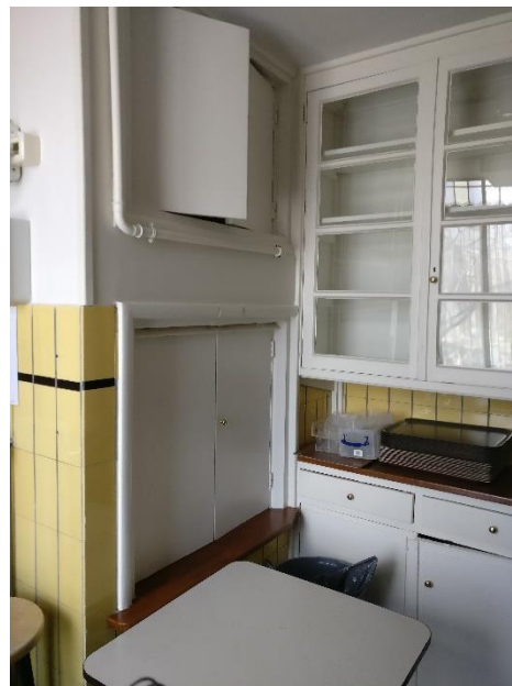
Inbouwkasten en spijslift in voormalige keuken (ruimte 2.6)
