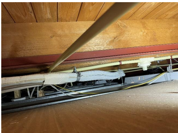
Afbeelding 4.9: dak is opgebouwd uit een houten balklaag met houten dakplaattelementen.
