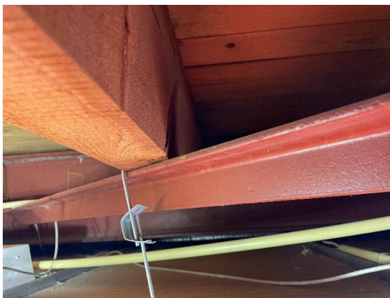
Afbeelding 4.10: balklaag met stalen windverbanden.
