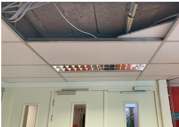
Afbeelding 4.7: overzicht foto MUWI-vloer met scheur in het vulelement.
