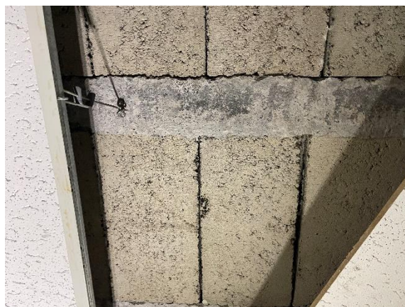
Afbeelding 4.4: overzichtsfoto MUWI-vloer ter plaatse van het trappenhuis.
