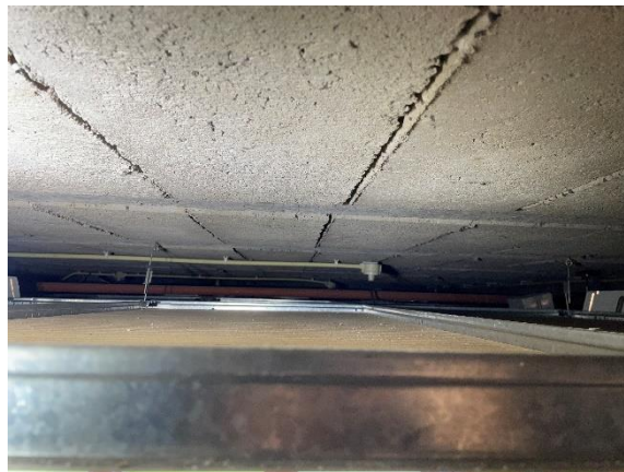
Afbeelding 4.2: overzichtsfoto boven verlaagd plafond ter plaatse van het methodieklokaal.
