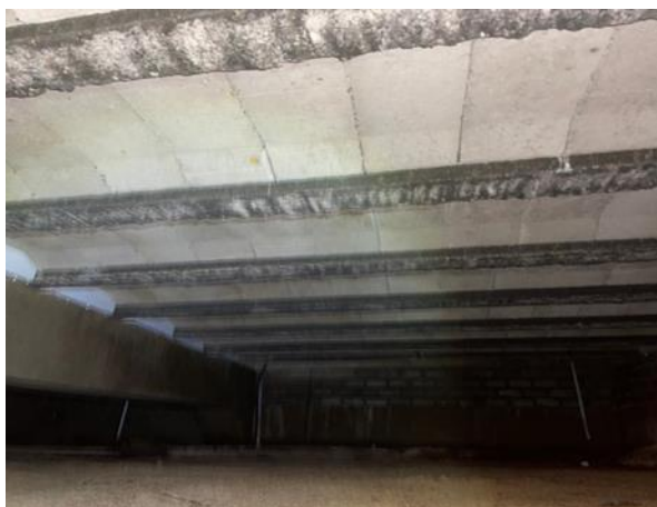
Afbeelding 4.3: kruipruimte droog en goed begaanbaar.
