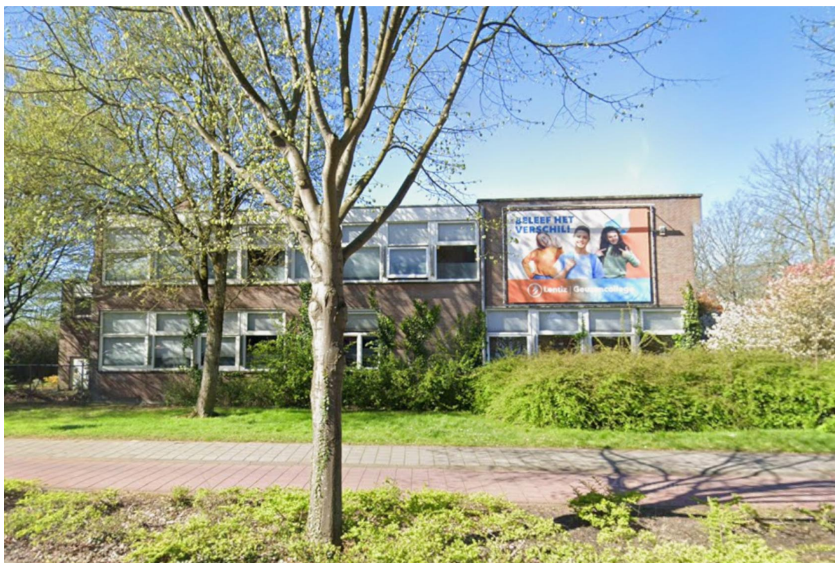
Figuur 1-1 Bestaand Geuzencollege, locatie Holy in Vlaardingen
