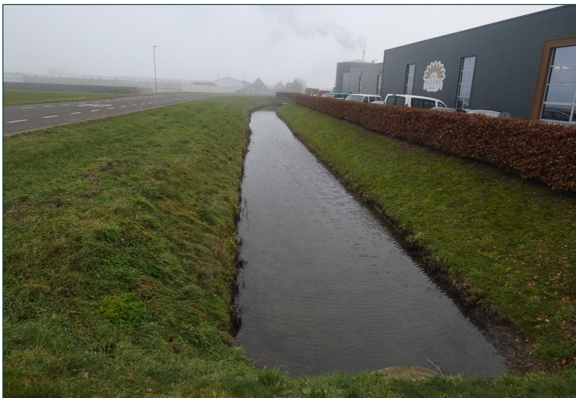
Figuur 2 Ten behoeve van de aanleg van het fietspad worden enkele sloten gedempt.
