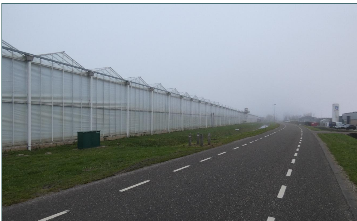
Figuur 4 In de nabijheid van de planlocatie bevinden zich diverse glastuinbouwbedrijven.
