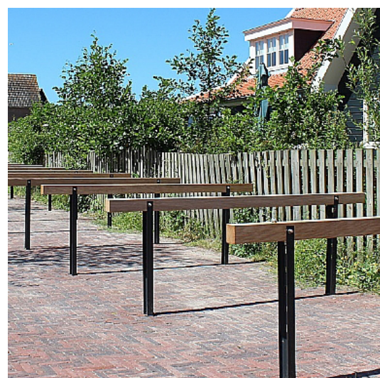
fietsleunhek, gepoedercoat staal kleur RAL 7021, type Scala, afm 900x850; leverancier: Velopa o.g. fundering met betonvoet in volle grond, op parkeerdek met voetplaat op funderingsplaat
