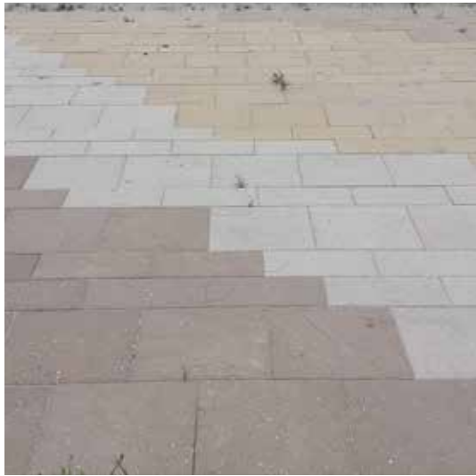
pleinverharding, tegels type GeoArdesia Mare Sabbia lineair wildverband gemixt toplaag: geborsteld en coaten met Protection Plusfactor30; uitvoering: velling 2x2 mm - 8cm dik!
