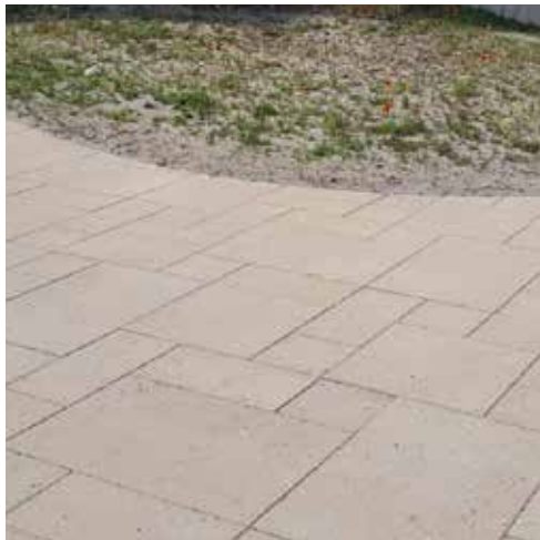
wandelpadverharding bij entrees appartementen wild- verband; tegels type Geosenza Mare Sabbia, bestrat- ingsrichting en type wildverband zie plankkaart kleur: 966, zand-schelp; toplaag: geborsteld en coaten met Protection Plusfactor30; uitvoering: velling 2x2 mm; leverancier: MBI o.g. -zie principedetail
