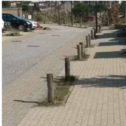
geleidepaal, geschilde kastanjepeer, diameter 140-180 mm, h.o.h. afst. 5-6m m.u.v. bochten, hoogte 0,50 m boven maaiveld, inpassing zie principedetail; leverancier: van Vliet Kastanjehout o.g.
