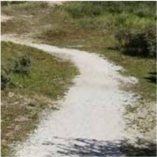
recreatieve paadjes duinlandschap: gewassen schelpen, gebroken- fractie 3-15 dikte=100mm GEEN KANTOPSLUITING
