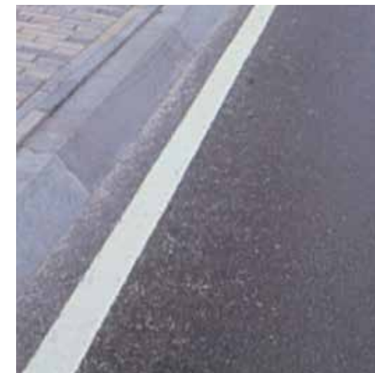
trap treden, inritelementen en waar nodig kan- topsluitingen uitgevoerd als prefab betonelementen, standaard kleur grijs
