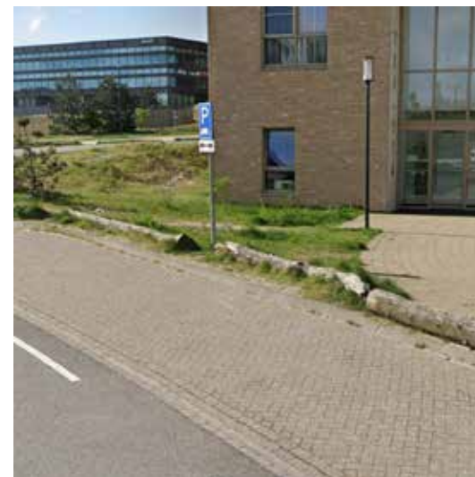
verharding laad en losplek, bss keiformaat met vel- lingkant type 'GC wadden', kleur: wadden-donkergrijs 960; keperverband, leverancier: MBI o.g.
