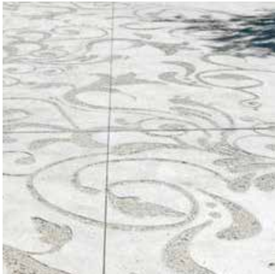
strandpad (voetpad); 2-4m breed, gesloten in situ betonverharding, opbouw in bestek leverancier: Hagen Beton BV of gelijkwaardig receptnummer: 318309; cementsoort en klasse: Cem III/A 42,5 N; toeslagmateriaal: Betonzand 0-8, Grind 4-32, Grind 4-16; hulpstoffen: GLENIUM SKY 648, MasterAir 110, MasterSet R130 GEEN KANTOPSLUITING NOG IN ONDERZOEK: patronen op wandelpaden met pigmentering: Figuratie aanbrengen na het storten van het beton. Mal laten maken met de gewenste figuratie
