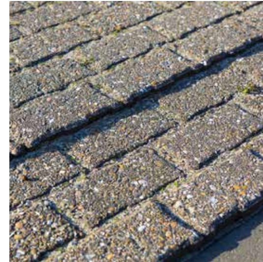
verharding rabatstrook rijbaan duin- en boslandschap bss drainsteen/porodrain keifmaat met vellingkant type 'wadden', kleur: wadden-donkergrijs 960; leverancier: MBI o.g. halfsteensverband in lengterichting straat
