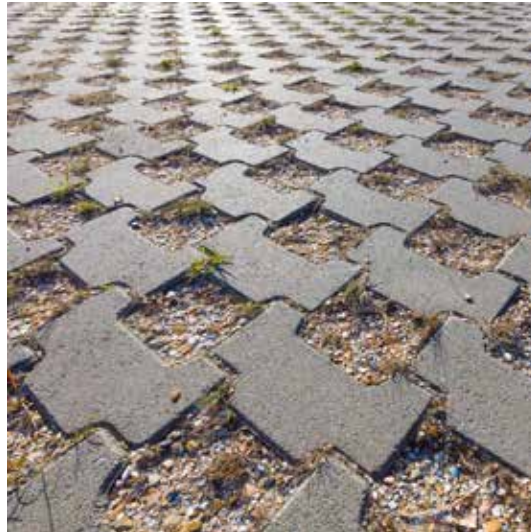
graskeien woonstraten duinlandschap, kleur antraciet, type graskei afm 21,5x111,5x10cm, 20% open verband, gaten afvullen met gewassen schelpen
