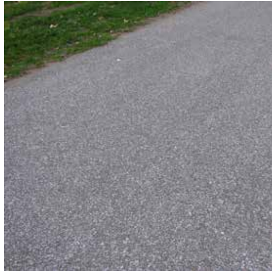
schelpenasfalt rijbaan woonstraten Zuiderduin en Stranddorp, kleur: donkere bituum deklaag 3cm met 60% schelpen en 40% lichte steenslag, opbouw asfalt in bestek NIET MEER LEVERBAAR VERVANGER (2026): asfalt met deklaag van div. fracties steenslag type Muiderzandweg
