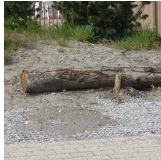
bermbescherming, onbehandelde en ontschorste boomstam, diameter: minimaal 0,30 m, lengte divers (gemiddeld 4m) waar nodig vastzetten met paaltjes tegen weggrollen of verplaatsen door derden.
