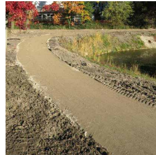
Muiderzandpad, gemengd fiets-voetpad: gebonden halfverharding type Koersmix
