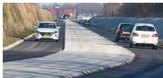
middenbermen graskruiden en helmgras middeneilanden bij kruispunten, gestort beton: middeneiland met gestorte lijnvormige betonband van betonspecie; aanbrengen middels slipformpaver, 110/300mm op maaiveld; beton nabehandelen met curing compound; verharding eiland met in situ beton, kleur: wadden-grijs/zandkleur zoals rammelstrook op foto hiernaast
