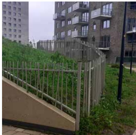
fysieke afscheiding t.b.v. ontoegankelijk duinhelling/dak met waarschuwborden, spijnehekwerk type Mykadoo h=1000mm, staanders h.o.h. 2360mm, gepoedercoat RAL 7034 leverancier elreka hekwerken o.g.
