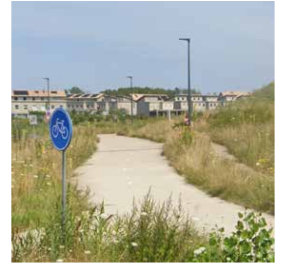
fietspadverharding, beton met asmarkering van thermoplast leverancier: Hagen Beton BV of gelijkwaardig receptnummer: 318309; cementsoort en klasse: Cem III/A 42,5 N; toeslagmateriaal: Betonzand 0-8, Grind 4-32, Grind 4-16; hulpstoffen: GLENIUM SKY 648, MasterAir 110, MasterSet R130 GEEN KANTOPSLUITING
