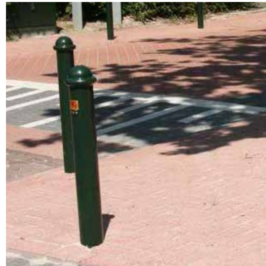
uitneembare afzetpaal type Bowler met 3-kant sleutel, RAL 7021, leverancier Falco o.g. of: vaste afzetpaal type Bowler, RAL 7021, leverancier Falco o.g. RAL 9004 op het duinplein afzetpalen alleen indien nodig toepassen
