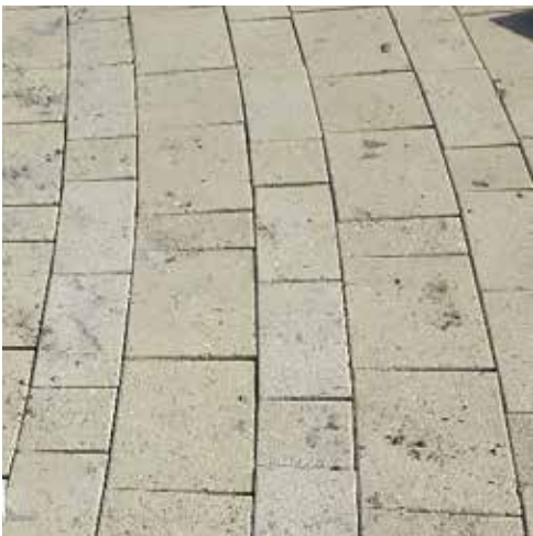
wandelpadverharding wandelpaden wildverband in stroken; tegels type Geosenza Mare Sabbia, bestrat- ingsrichting en type wildverband zie plankkaart kleur: 966, zand-schelp; toplaag: geborsteld en coaten met Protection Plusfactor30; uitvoering: velling 2x2 mm; leverancier: MBI o.g. -zie principedetail
