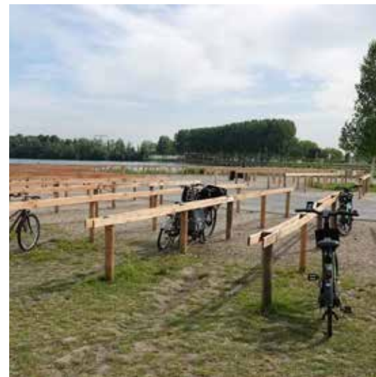
fietsaanleunbeugel stranden, type Napoli, lev. Jaap de Vries producties o.g. 4m lang, 90cm minimale h.o.h. afstand bij beperkte gronddekking op dijk, bevestiging staanders fietsleunhek op voetplaat
