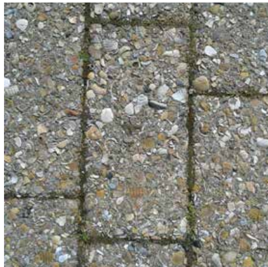
verharding voetgangersstrook en opritten bss keifmaat zonder vellingkant type 'wadden', kleur: 955; leverancier: MBI o.g. strokenverband
