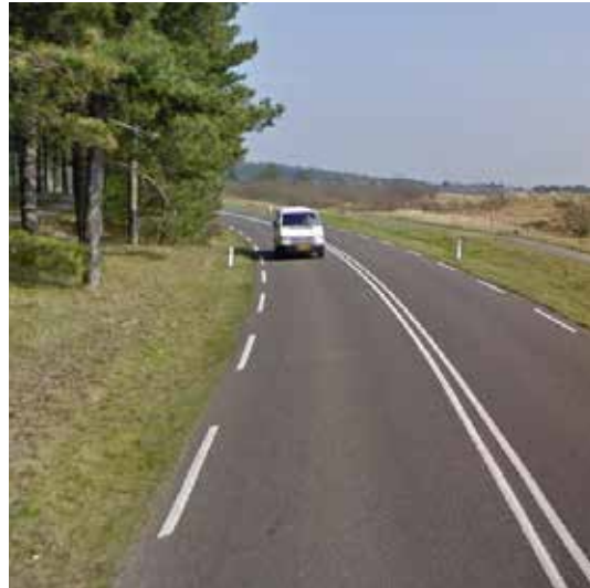
asfalt rijbaan, kleur: zwartgrijs deklaag 4cm
