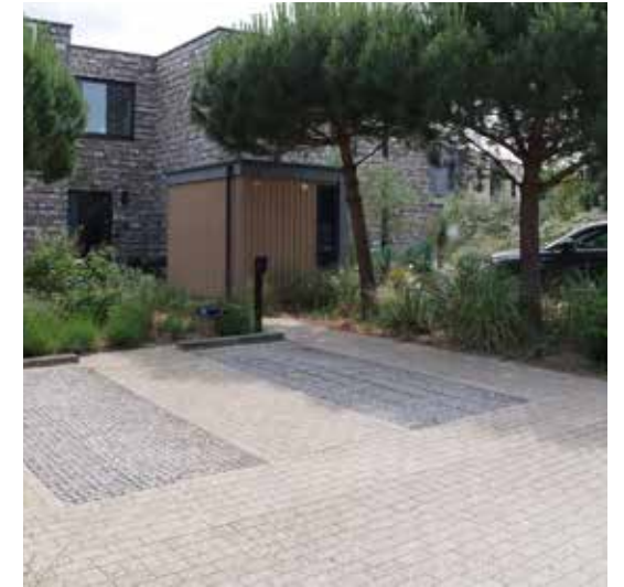
parkeervak, grastegel Greenston 250x250x80mm, kleur: standaard grijs; leverancier: Klostermann o.g. afvullen met gewassen schelpen omkadering parkeervak/ loopstrook bss keifmaat zonder vellingkant type 'wadden', kleur: wadden-grijs 955; leverancier: MBI o.g.
