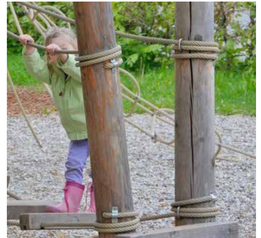
C. bevestiging speeltouw d.m.v. slingeren rond palen (minimaal gebruik stalen elementen)
