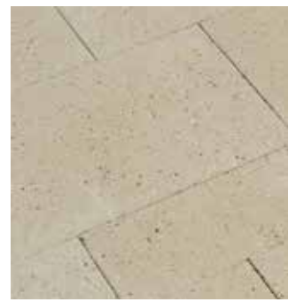
Wandelpadverharding rond appartementen
