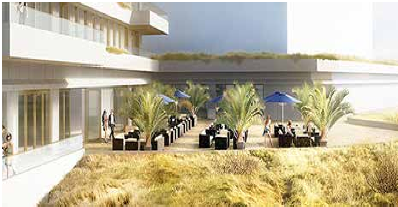
Openbaar terras aan gebouw
