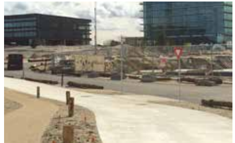
Rijbaan auto los van fietspad
