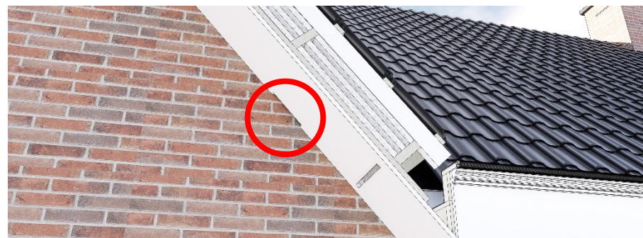
Figuur 21 Bij verblijfplaatsen in de dakrand is het extra belangrijk om kastconstipatie te voorkomen. De spleet haaks op de muur is voor de afvoer van de ontlasting. De spleet langs de muur (in rode cirkel) is de entree voor vleermuizen.
