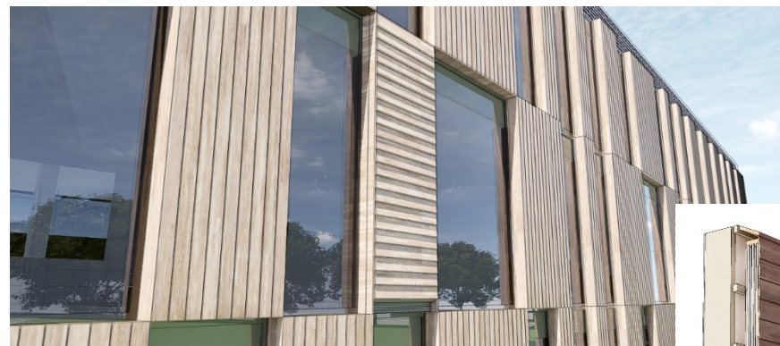
Figuur 18 Ook bij moderne gevels kunnen royale vleermuisvoorzieningen worden aangebracht. Rechts een vergroting van de vleermuisvoorziening in de gevelbetimmering.
