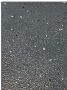
PU-gietvloeren kombuis/laundry PU-gietvloeren wc/douche
