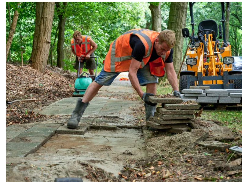
30x30 stoeptegels zijn een goed voorbeeld van een circulair bouw materiaal.
