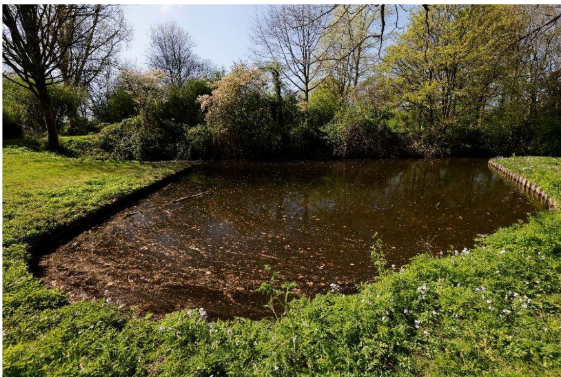
Afbeelding 5.10: Watergang in Park Kokkebogaard met beschoeiing aan alle oevers. Door de aanwezigheid van de beschoeiing is het lastig voor amfibieën om het water in en met name uit te komen; daarnaast ontbreekt er een flauwe oeverzone met onderwater- en oevervegetatie.
