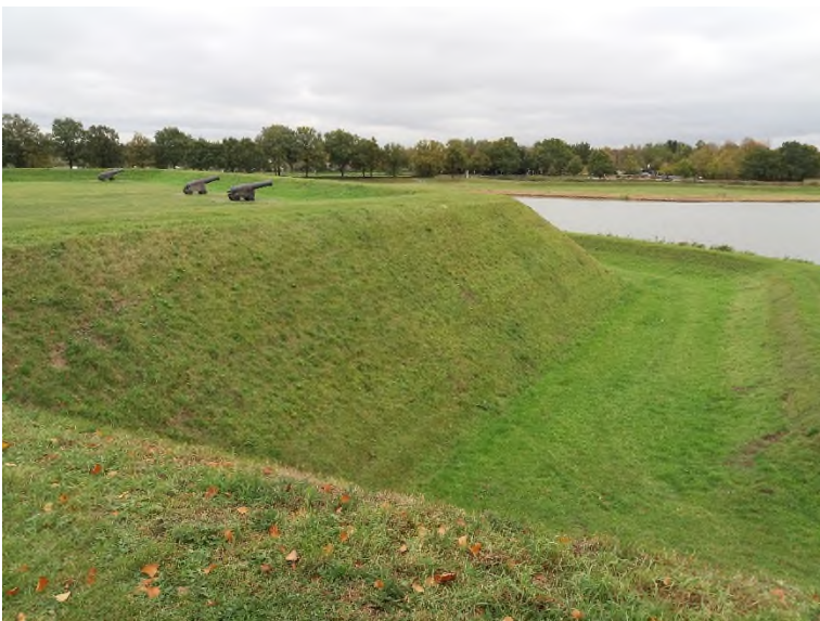
Figuur 3 - Bovenkant vestingwal
