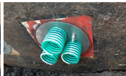
Optie: slangen in 150mm doorvoerplug
