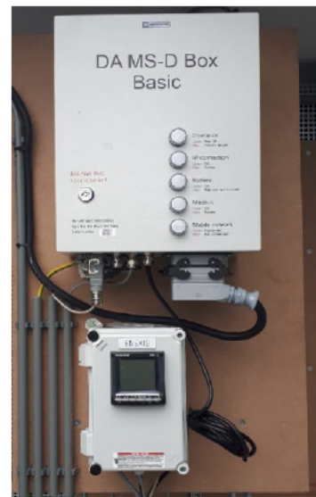
Afbeelding 15: DA-box met DIRIS-meter op montagepaneel
