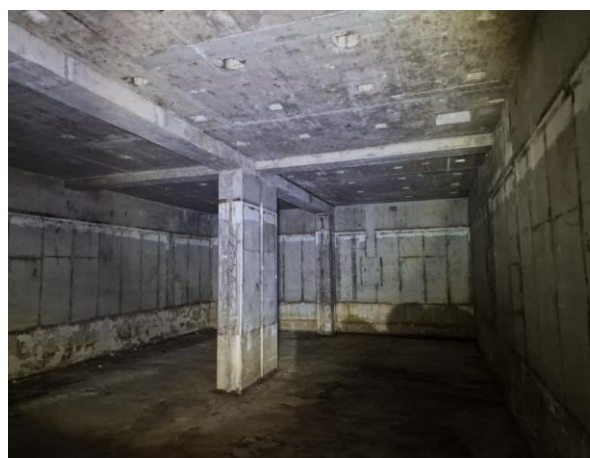
Figuur 2.6: Foto binnenzijde vanaf keldervloer
