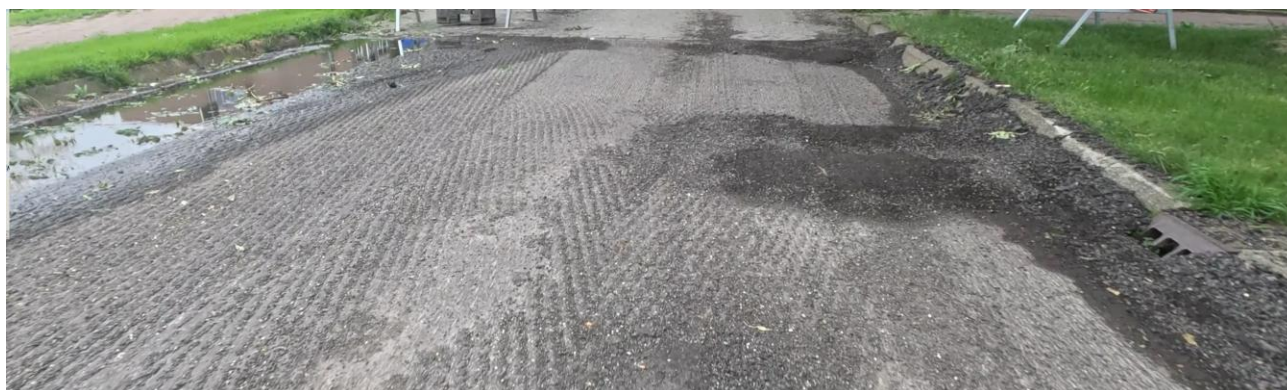
Figuur 11 Gefreesde deklaag (sub) vak Malachiet – Tweede Zijweg
