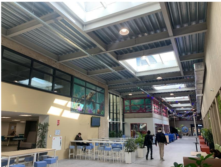
Overkappingsconstructie tussen de gebouwen
