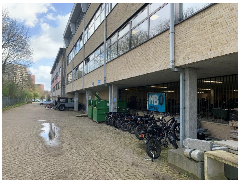
Achterzijde nr. 25 met open gevel tpv scooterstalling
