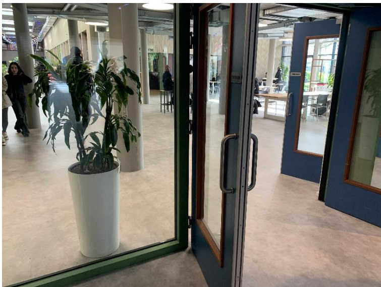
Interne brandscheidingen in de centrale ruimte
