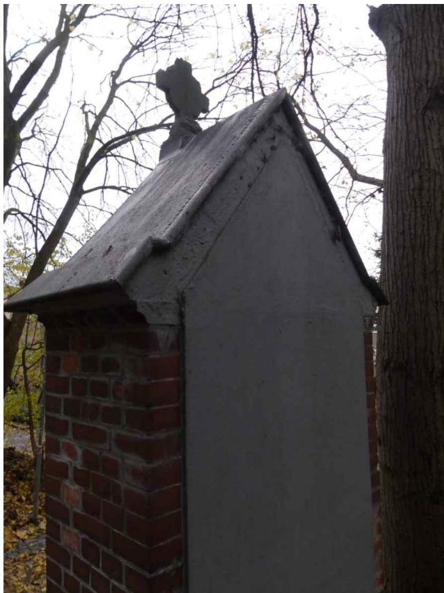
Afb. II.§33.01, strak gemonteerd en gesoldeerd zinken dakje, geen mogelijkheid tot uitzetten of krimpen tgv temperatuur-werking
