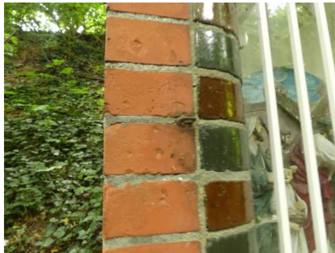
Afb. V.522.04, oud ijzer in de voegen (oude bevestiging vroegere gaashekwerk)
