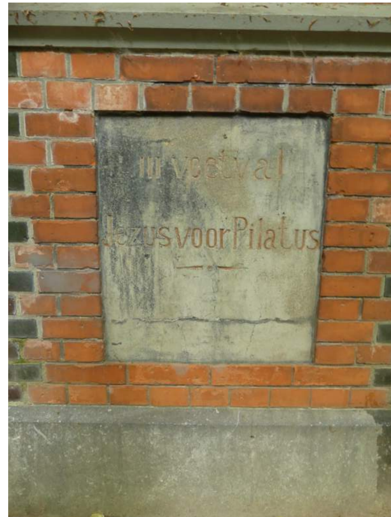
Afb. III.§35.01, gescheurde gevelsteen
