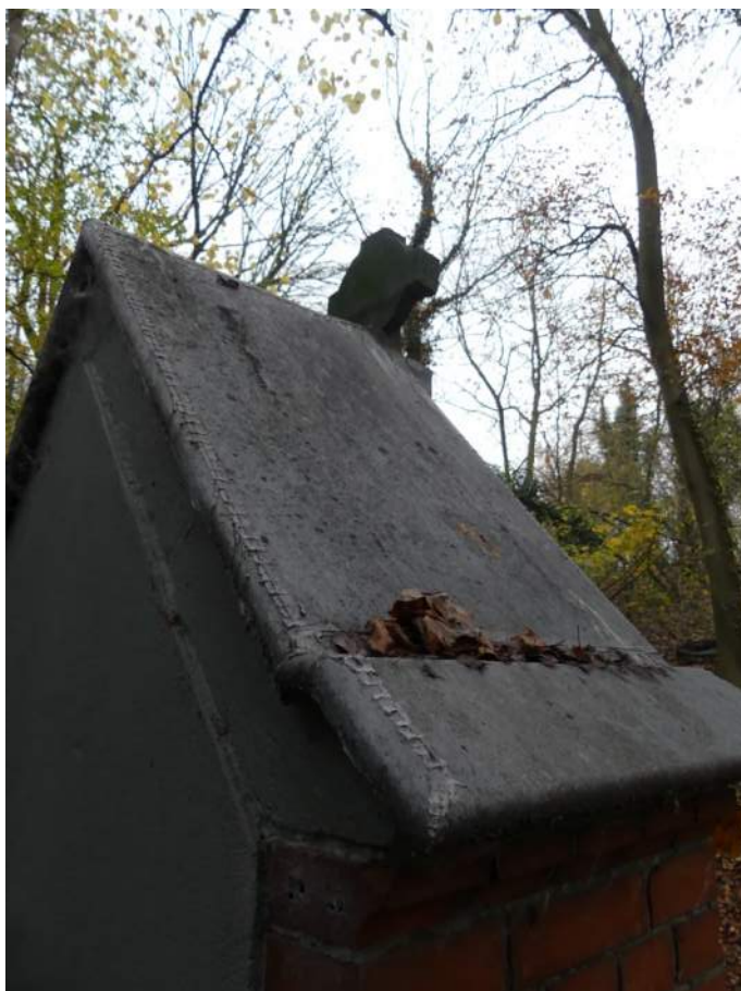
Afb. III.§33.01, strak gemonteerd en gesoldeerd zinken dakje, geen mogelijkheid tot uitzetten of krimpen tgv temperatuur-werking
