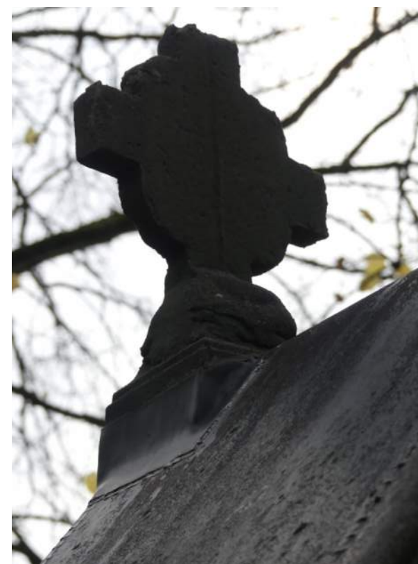
Afb. II.§35.04, beschadigd kruis op dakje
