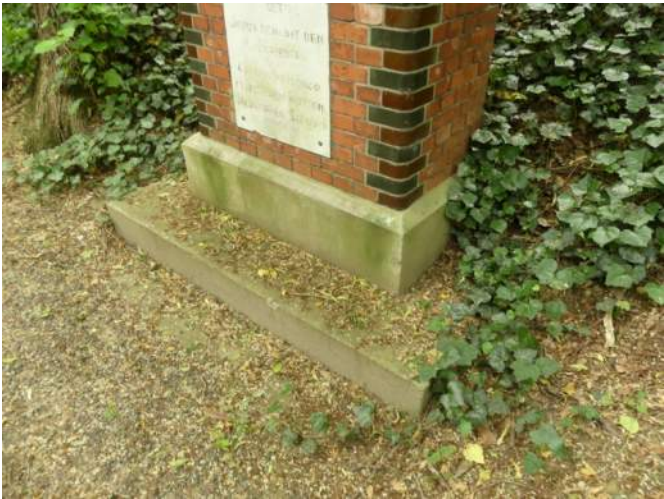
Afb. V.512.01, grondprofiel en begroeiing dekken delen basement af
