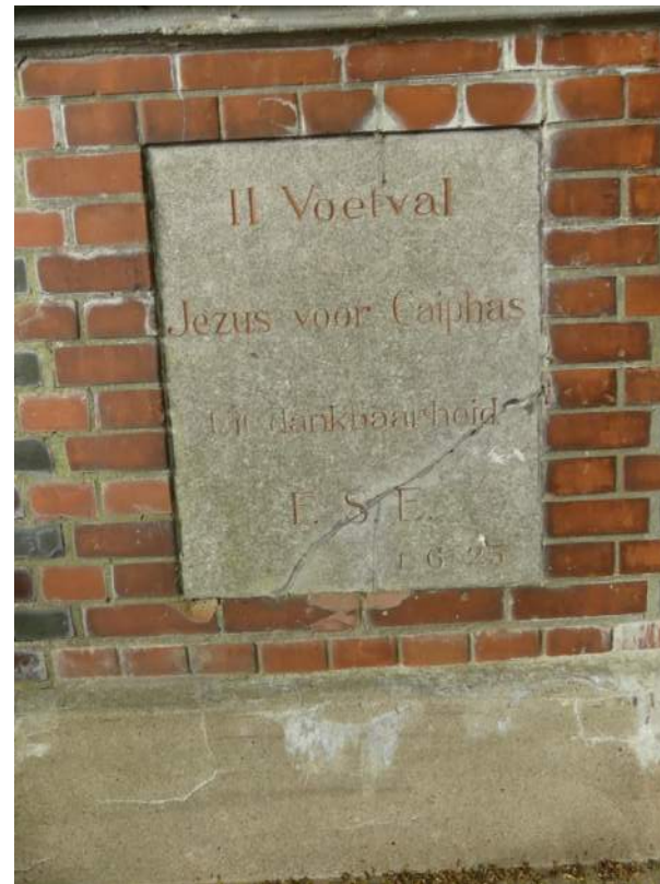
Afb. II.§35.01, gescheurde gevelsteen
