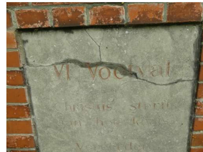
Afb. VI.§35.02, detail scheuren
