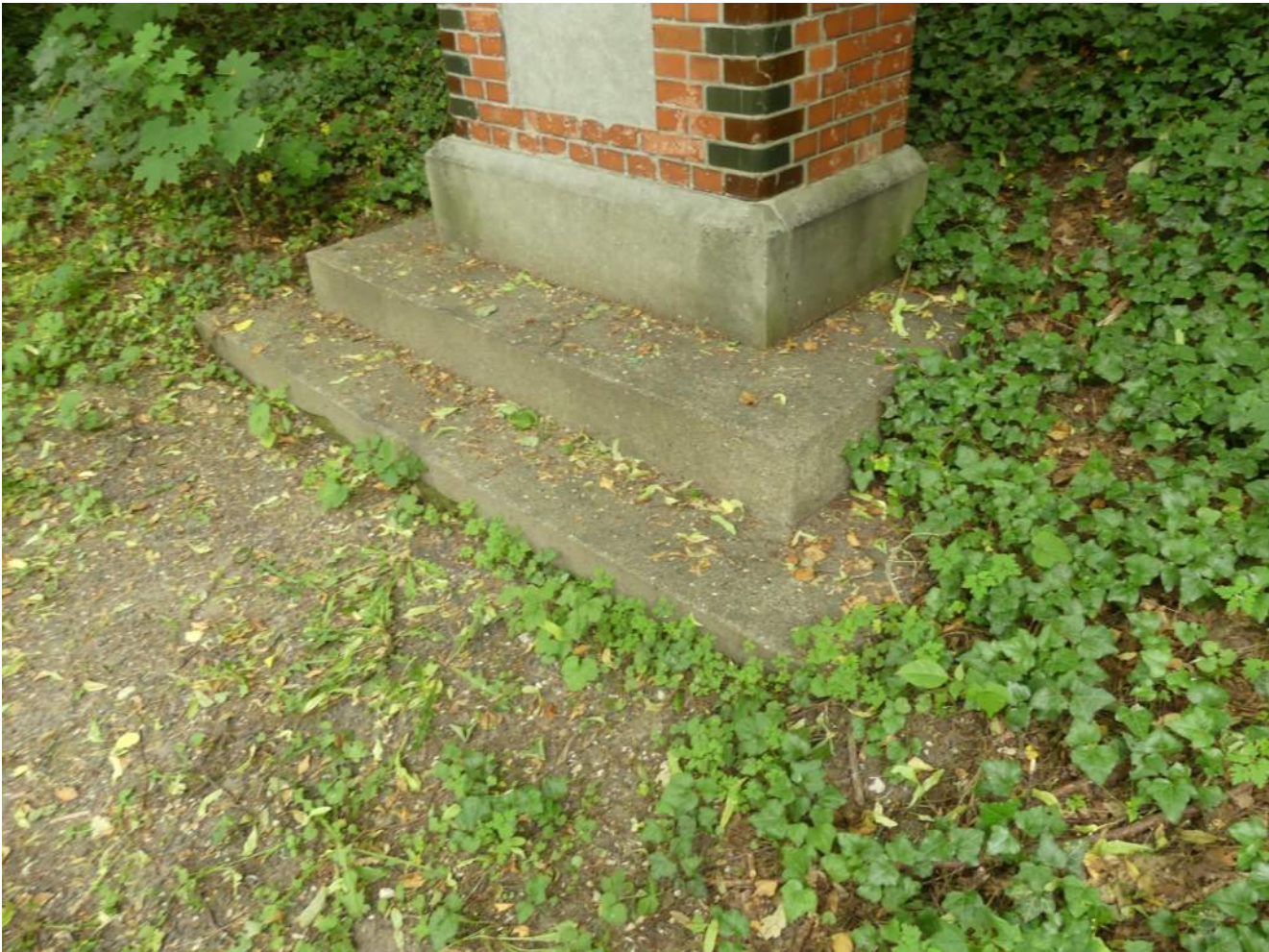
Afb. VI.512.01, grondprofiel en begroeiing dekken deel basement af
