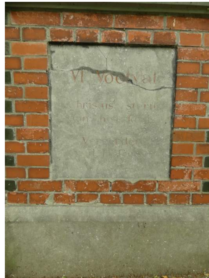
Afb. VI.§35.01, gescheurde gevelsteen
