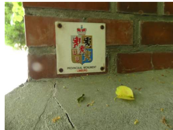
Afb. II.§21.03, scheuren in betonnen waterlijst
