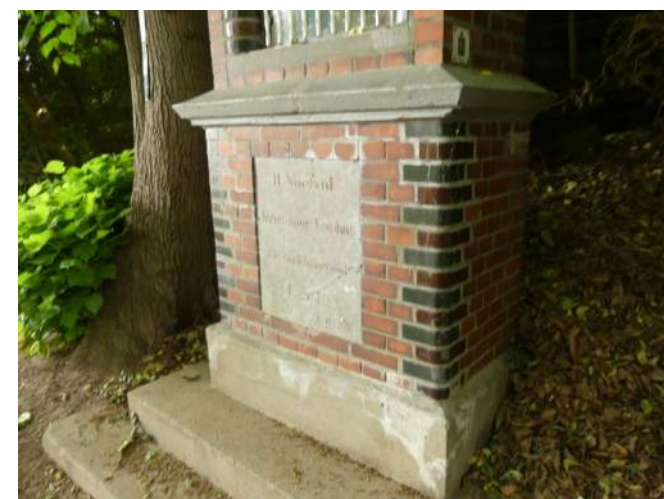
Afb. II.§22.01, veel uitbloei rondom profielstenen en boven gevelsteen
