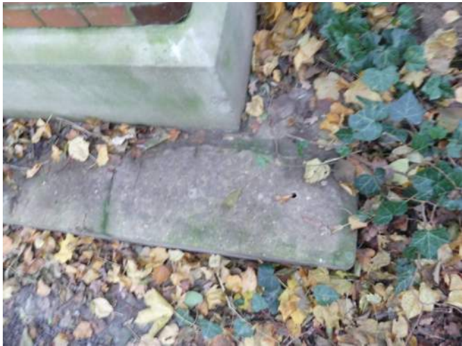
Afb. V.521.02, scheurvorming in onderste basement
