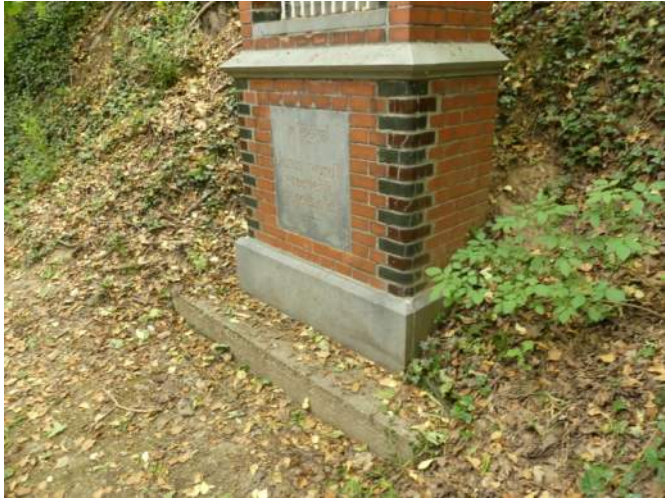
Afb. IV.512.02, grondprofiel dekt delen basement af
