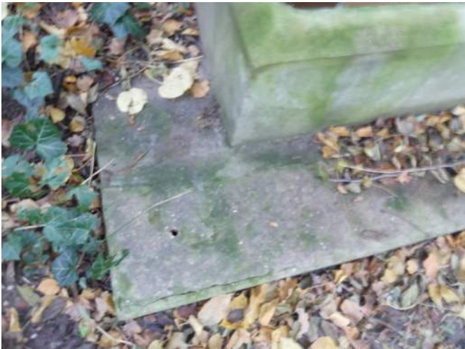
Afb. V.521.01, algaanslag en -groei op basement
