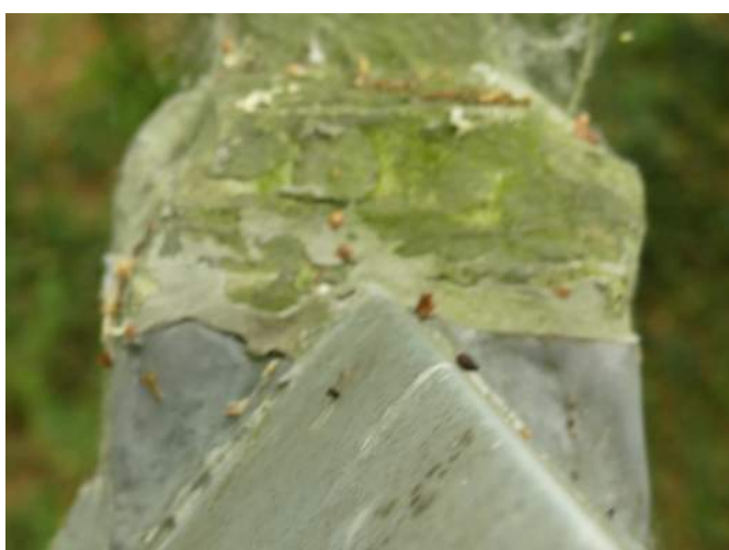
Afb. IV.§33.02, twijfelachtige dichting opstaande rand zinken dakje
