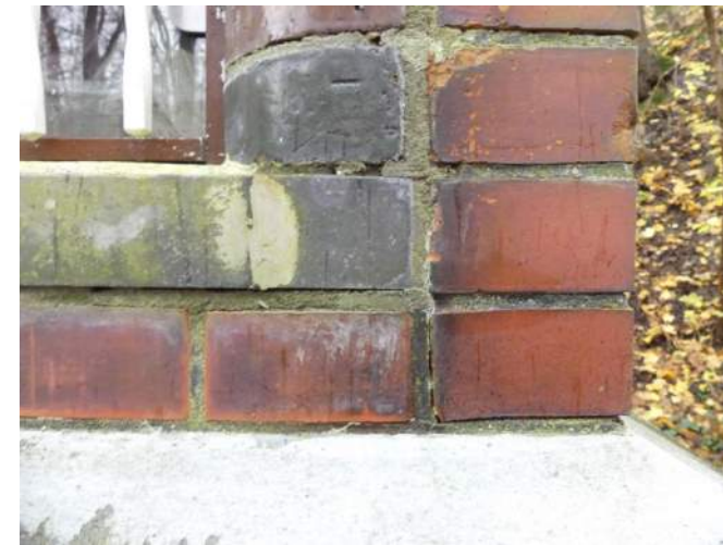
Afb. I.§22.07, beschadigde profiel- en verblendstenen, slordig hersteld en uitgespoeld voegwerk
