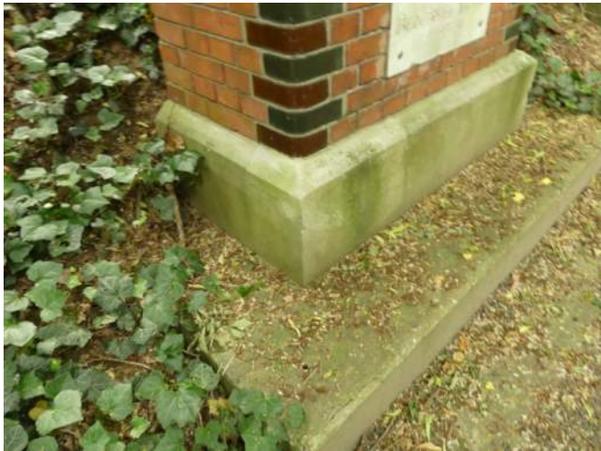
Afb. V.512.02, grondprofiel en begroeiing dekken delen basement af
