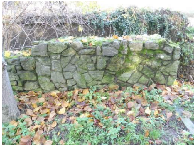
Afb. 07.35.08, ontbrekend blok natuursteen
