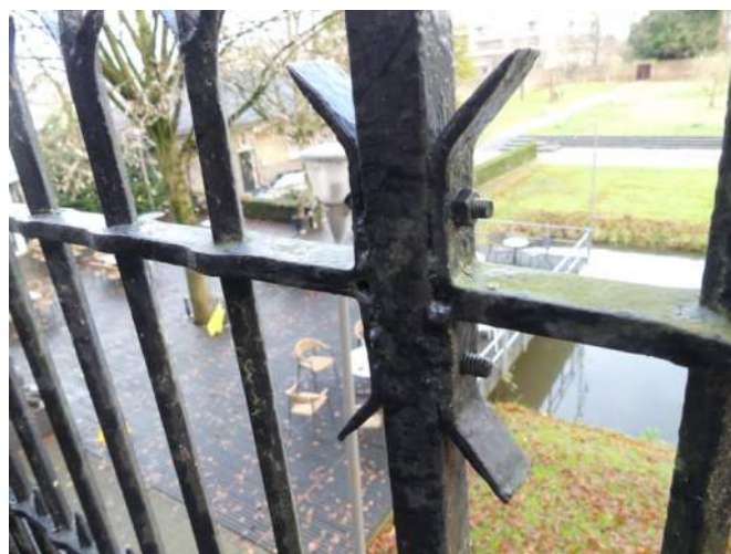
Afb. 04.43.20, met zeskantbouten en -moeren en lasnaad aan baluster bevestigde hekwerken
