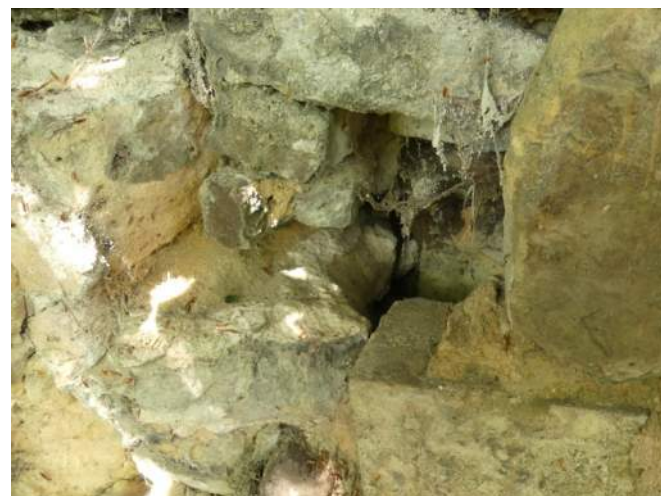
Afb. 11.35.04, onsamenvhangende aansluiting
