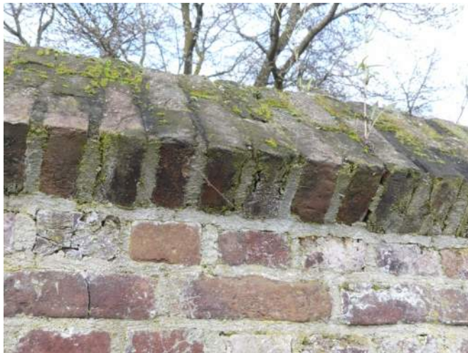
Afb. 04.22.27, uitgespoeld en begroeid voegwerk op en onder ezelsrug
