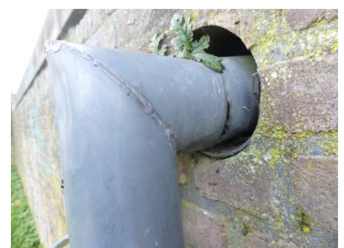
Afb. 05.30.02, losgetrokken bocht; met te weinig overlap uitgevoerd
