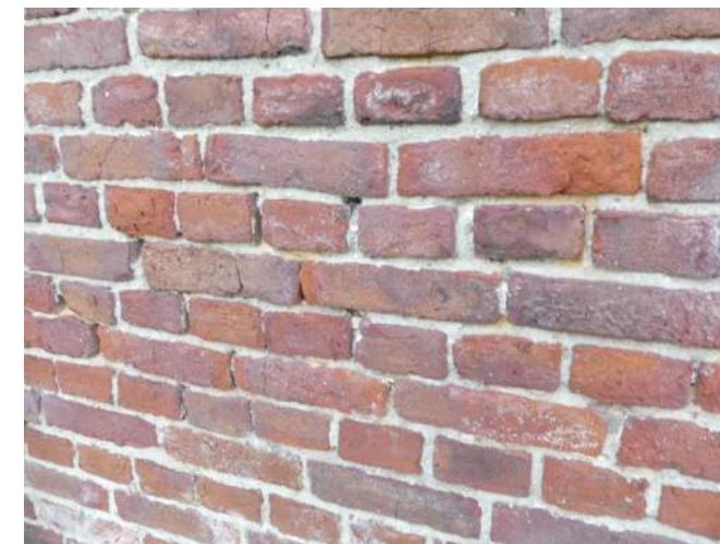
Afb. 04.22.44, weggespoeld en uitgevallen voegwerk, vermoedelijk reparaties, let op kleur legmortel
