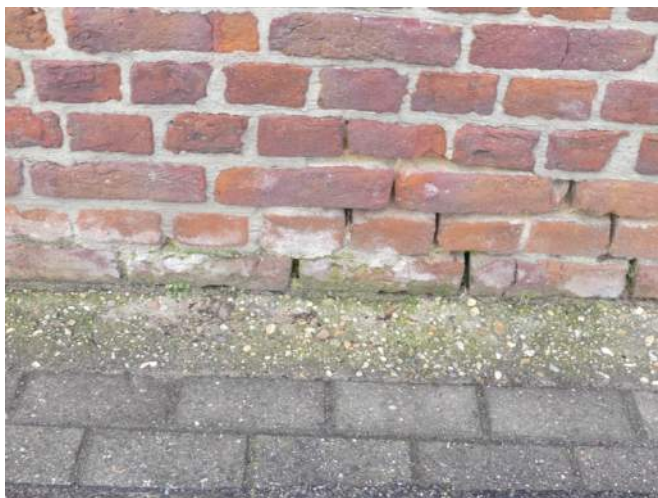
Afb. 04.22.29, uitgespoeld herstelvoegwerk plintzone; let op: kleur (originele!) legmortel
