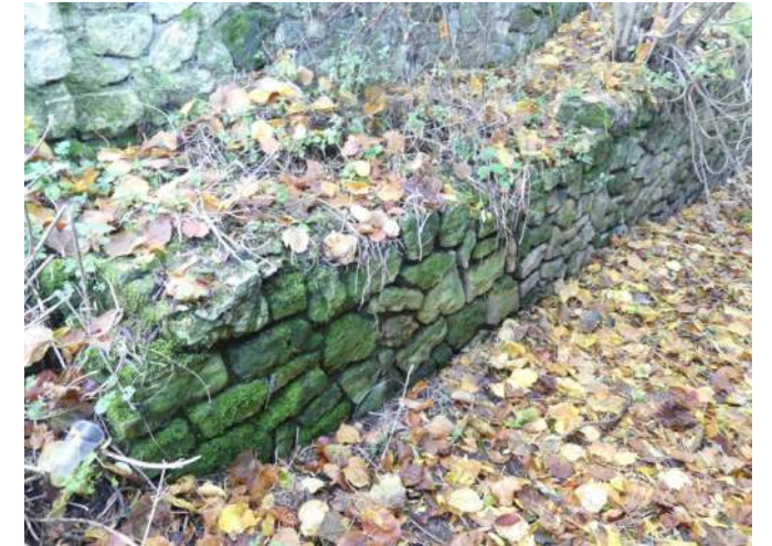
Afb. 07.35.13, uitgesleten voegwerk en alg- en mosgroei
