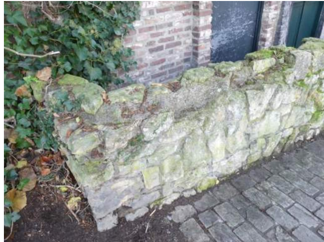
Afb. 07.35.10, ontbrekend blok natuursteen en begroeiing
