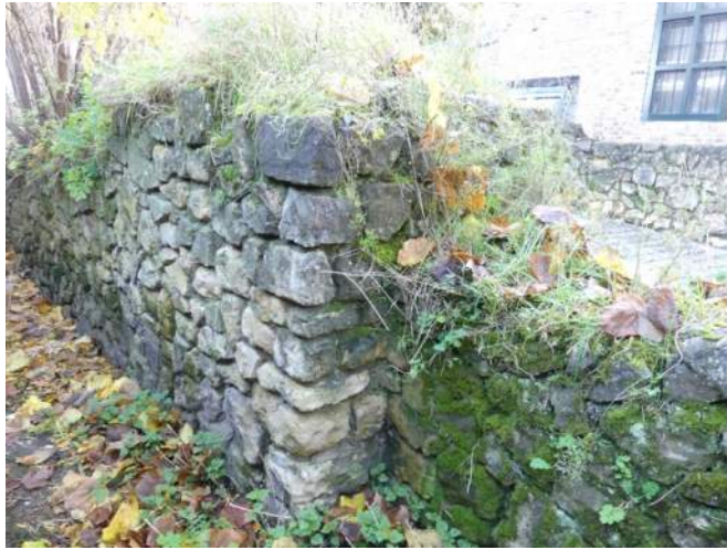
Afb. 07.35.18, uitgesleten en weggevallen voegwerk, alg- en mosgroei en begroeiing
