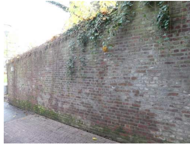
Afb. 05.22.59, begroeide muur en alg- en mosgroei in de plintzone
