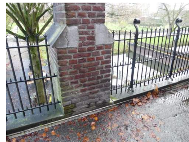
Afb. 04.35.16, gescheurd afzaatblok in penant
