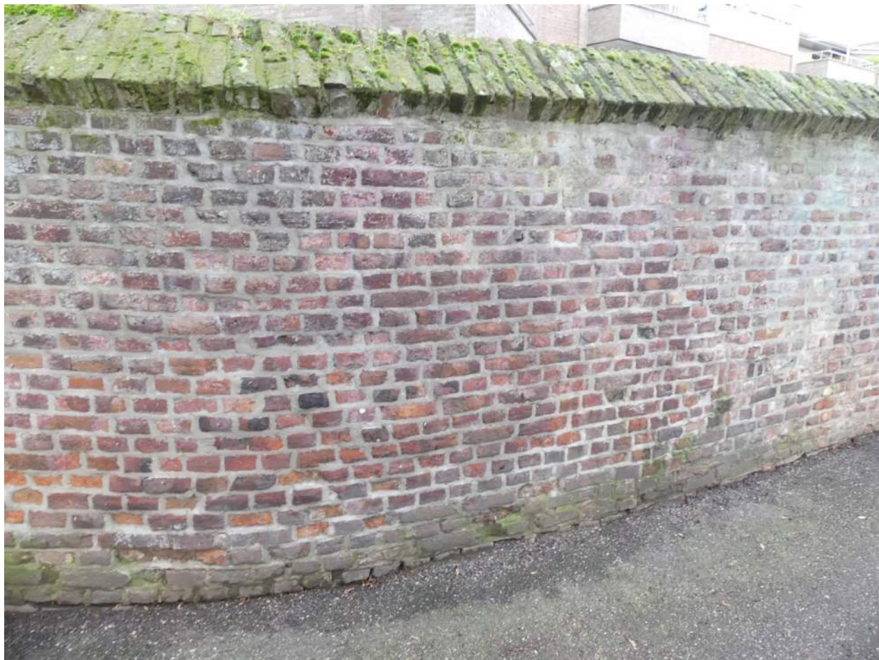
Afb. 10.00.05, overzicht walmuur ter hoogte van de nieuwbouw
