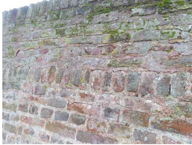
Afb. 03.22.02, losgescheurd metselwerk
