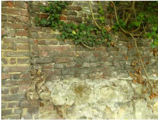
Afb. 11.22.25, door de muur heengroeïende klimplanten
