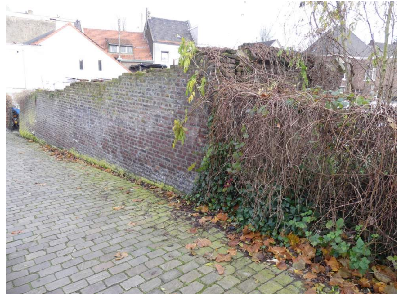
Afb. 09.00.02, aanzicht van walmuur aan de buitenzijde van de Agnetenwal, richting Putstraat. NB: haaks volume met ezelsrug onder forse begroeiing
