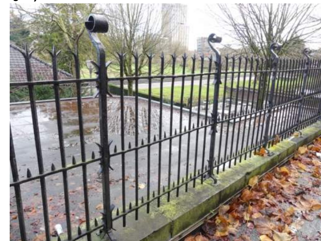
Afb. 04.43.01, overzicht smeedijzeren hekwerk
