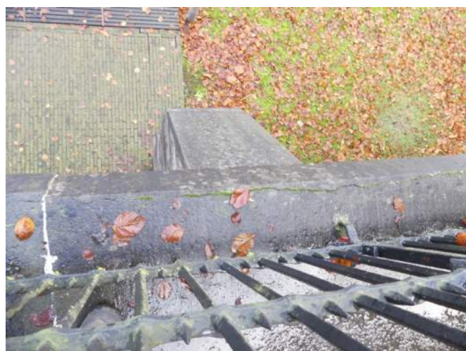
Afb. 04.35.08, losgebarsten neus aan de afdek (staand leger??)
