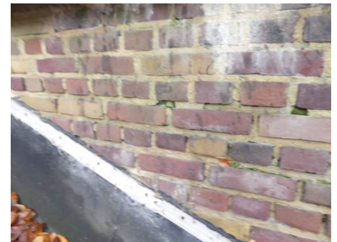
Afb. 04.22.36, weer uitgevallen (hersteld) voegwerk uit wangen opgaand werk, door eerder te ondiep uithalen en (mogelijk) onvoldoende aankauwen
