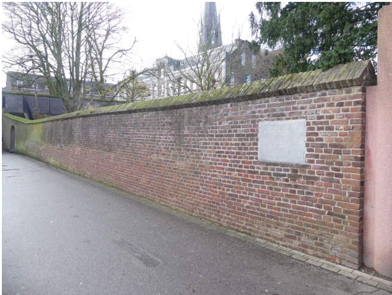
Afb. 04.00.18, overzicht (deel) buitenzijde van de oostelijke muur Ursulinentuin met aansluiting Dominicanenwal
