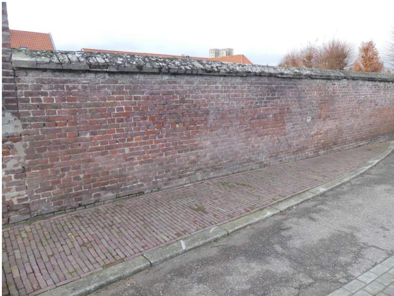
Afb. 08.00.07, overzicht van de walmuur na de knik in de wal; het trottoir loopt -richting knik- tegen de walmuur aan
