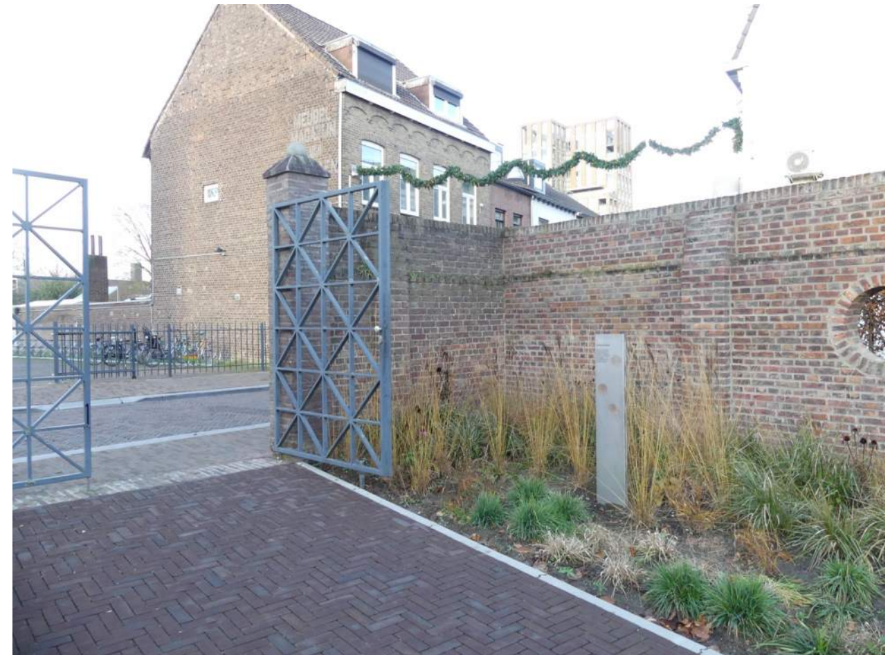
Afb. 06.00.09, overzicht binnenzijde rechterdeel voorste muur met moderne poortpenant en aangezette muur
