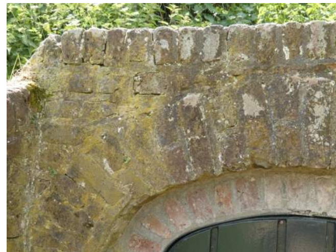
Afb. 05.22.05, scheurtjes in het metselwerk
