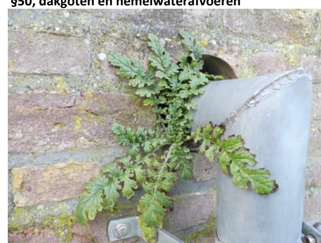
Afb. 04.50.01, begroeiing bij doorvoer hwa
