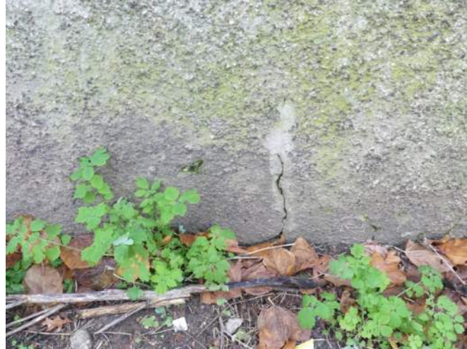
Afb. 06.40.02, gescheurd pleisterwerk
