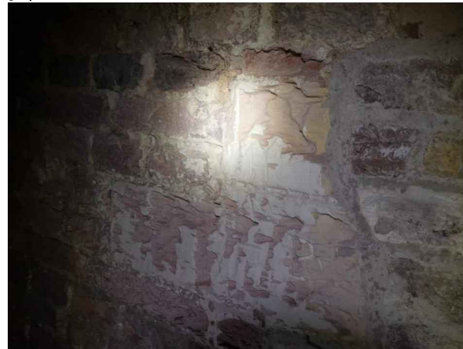
Afb. 12.35.01, afschilferend natuursteen blok
