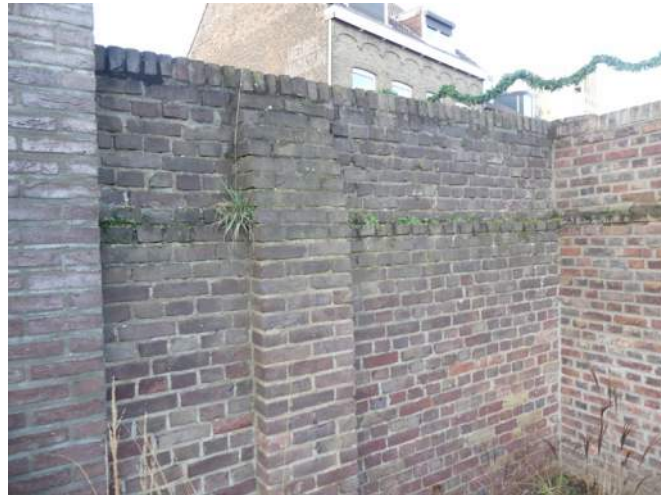
Afb. 05.22.26, lichte alg- en mosgroei op verspringing in de muur met beginnende vegetatie
