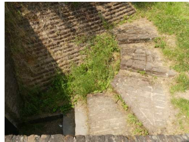
Afb. 12.22.27, begroeiing naast, op, tussen en over metselwerk traptreden
