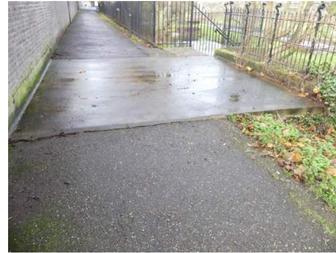
Afb. 05.21.01, overzicht bovenzijde betondek onderdoorgang
