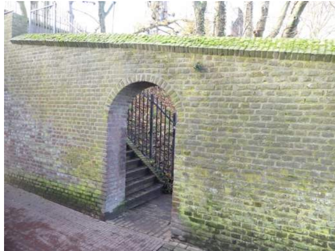
Afb. 05.22.53, met alg en mos begroeide ezelsrug en plintzone
