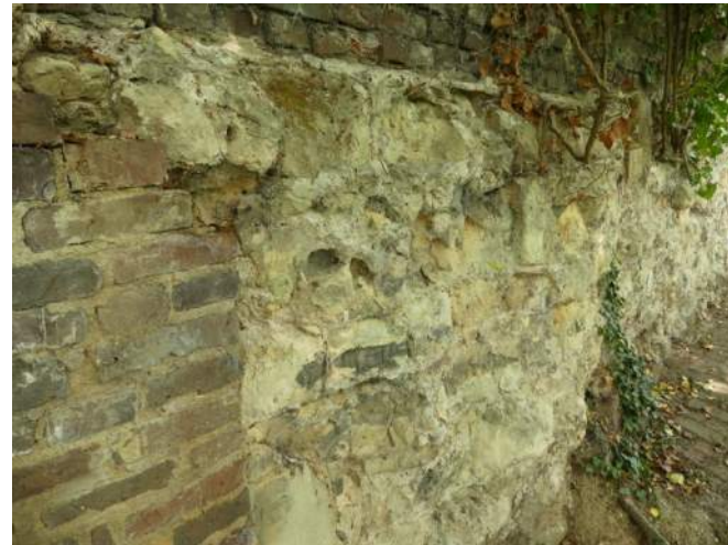
Afb. 11.35.02, gedegrademd paramentwerk, van nagenoeg alle blokken is de buitenste laag afgesleten/geboerd
