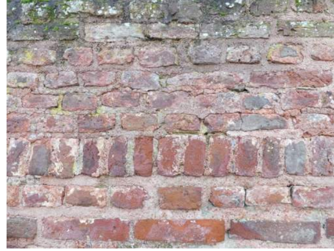
Afb. 03.22.13, cracquelé voegwerk
