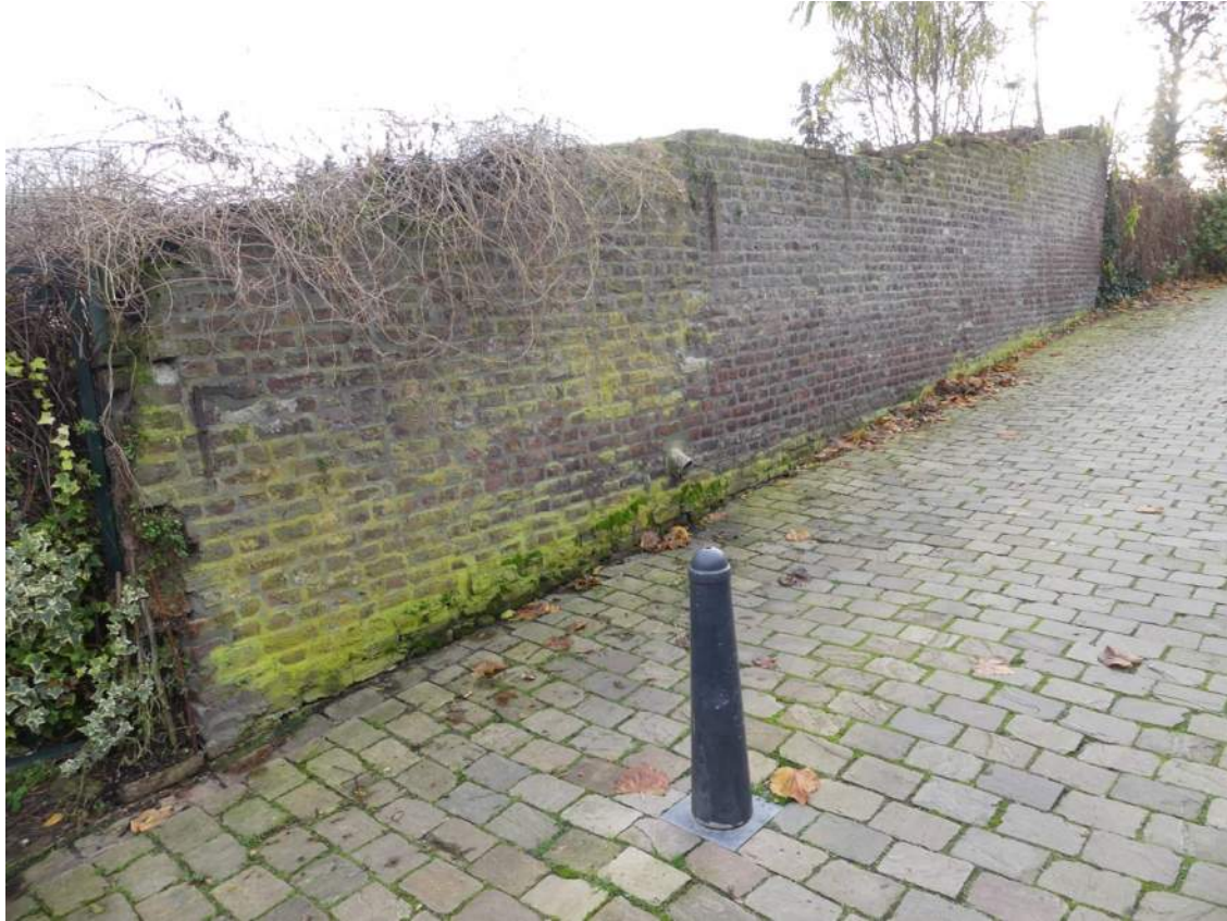
Afb. 09.00.01, aanzicht van Wal 09 aan de linker(buiten)zijde van de Agnetenwal
