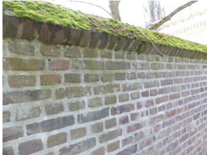
Afb. 05.22.52, volledig met alg en mos begroeide ezelsrug muur
