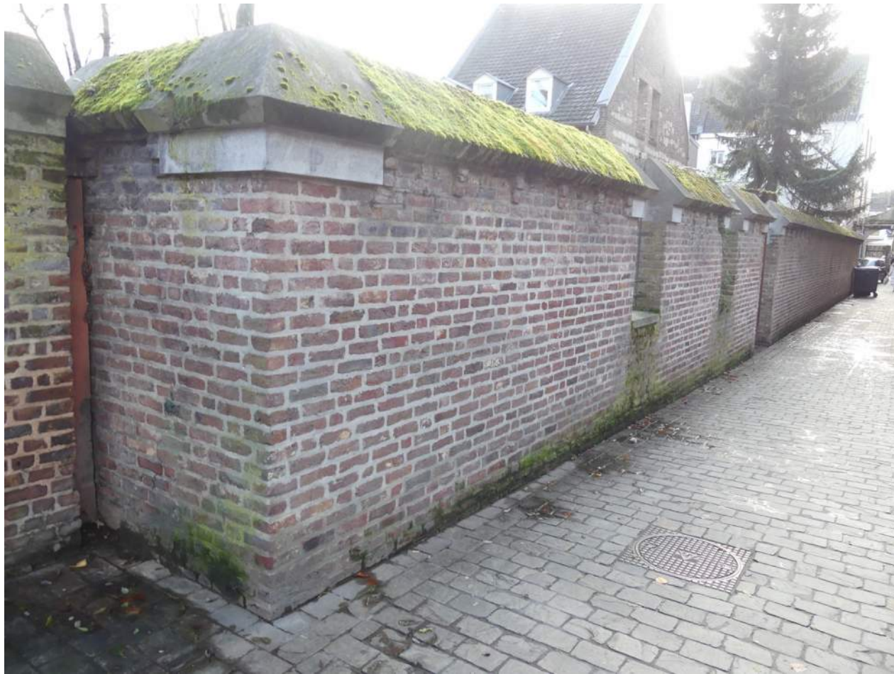
Afb. 05.00.15, overzicht rechter muurdeel langs Jardin d'Isabelle, richting bebouwingsblok aan de Markt
