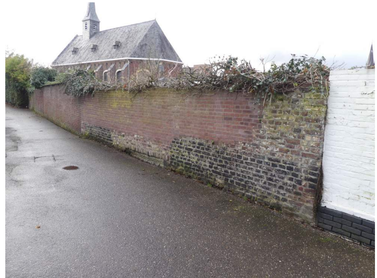
Afb. 09.00.03, overzicht van de walmuur aan stadse zijde van de wal
