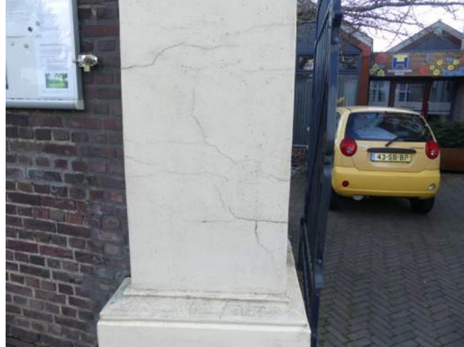
Afb. 06.40.01, craquelé in pleisterwerk linkerpoortpenant
