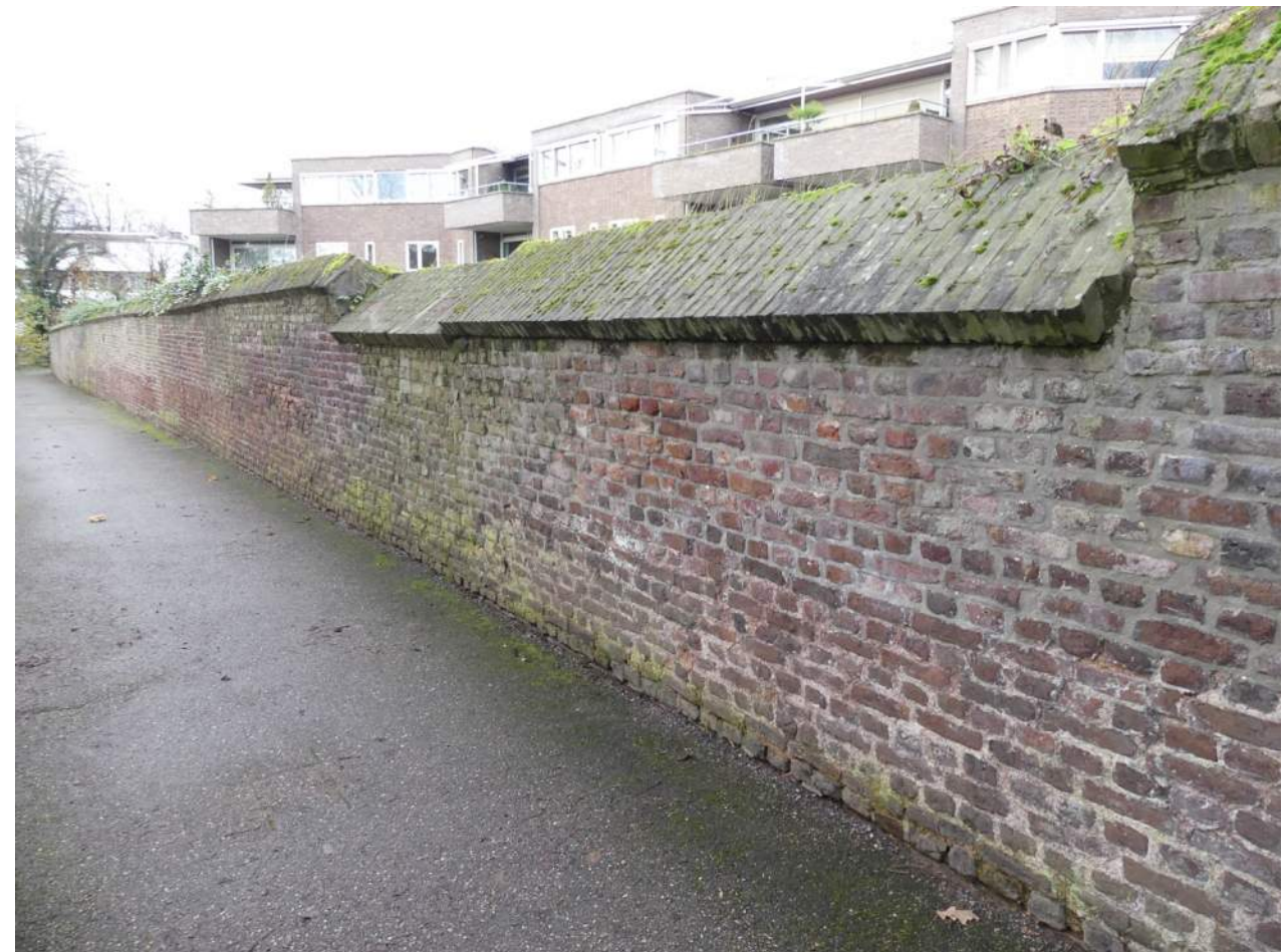
Afb. 10.00.03, overzicht in hoogte verspringende delen van de walmuur
