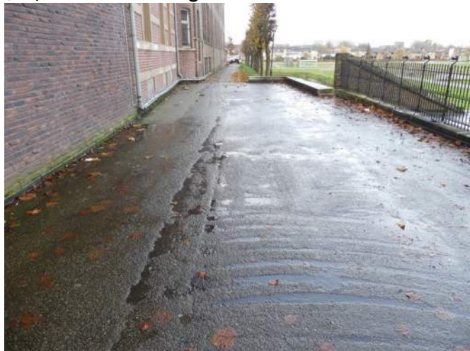
Afb. 04.15.01, geasfalteerd wandelpad boven op wal, hierdoor waterbelasting aan zijde klooster en aan walmuurzijde
