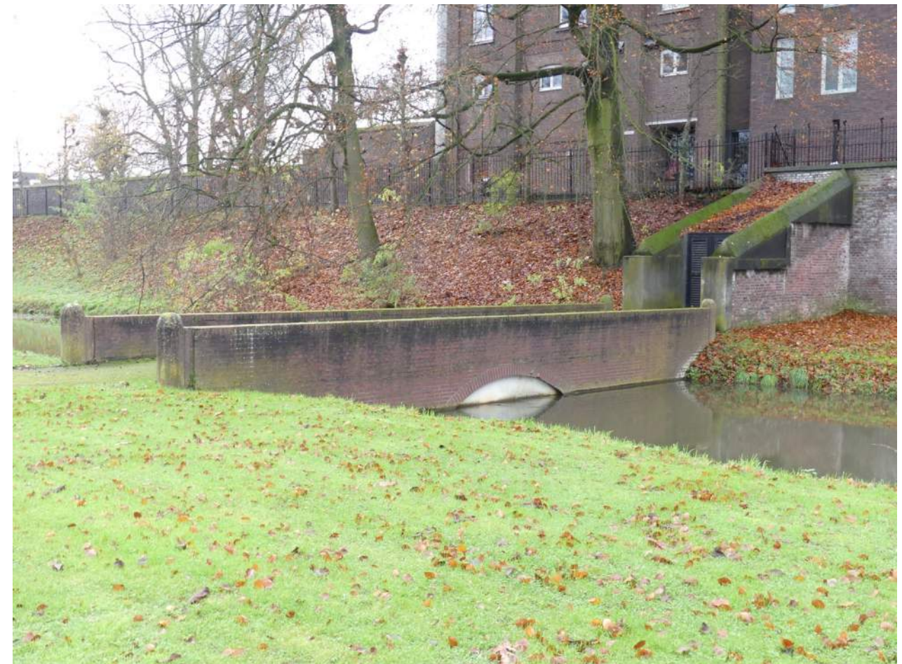
Afb. 04.00.05, overzicht brug met doorgang en grondkerend deel
