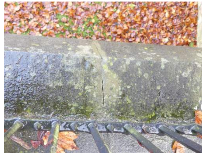
Afb. 04.35.25, losgebarsten mortelvoeg
