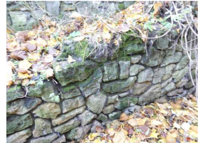
Afb. 07.35.15, uitgesleten voegwerk, forse alg- en mosgroei, vegetatie en begroeiing
