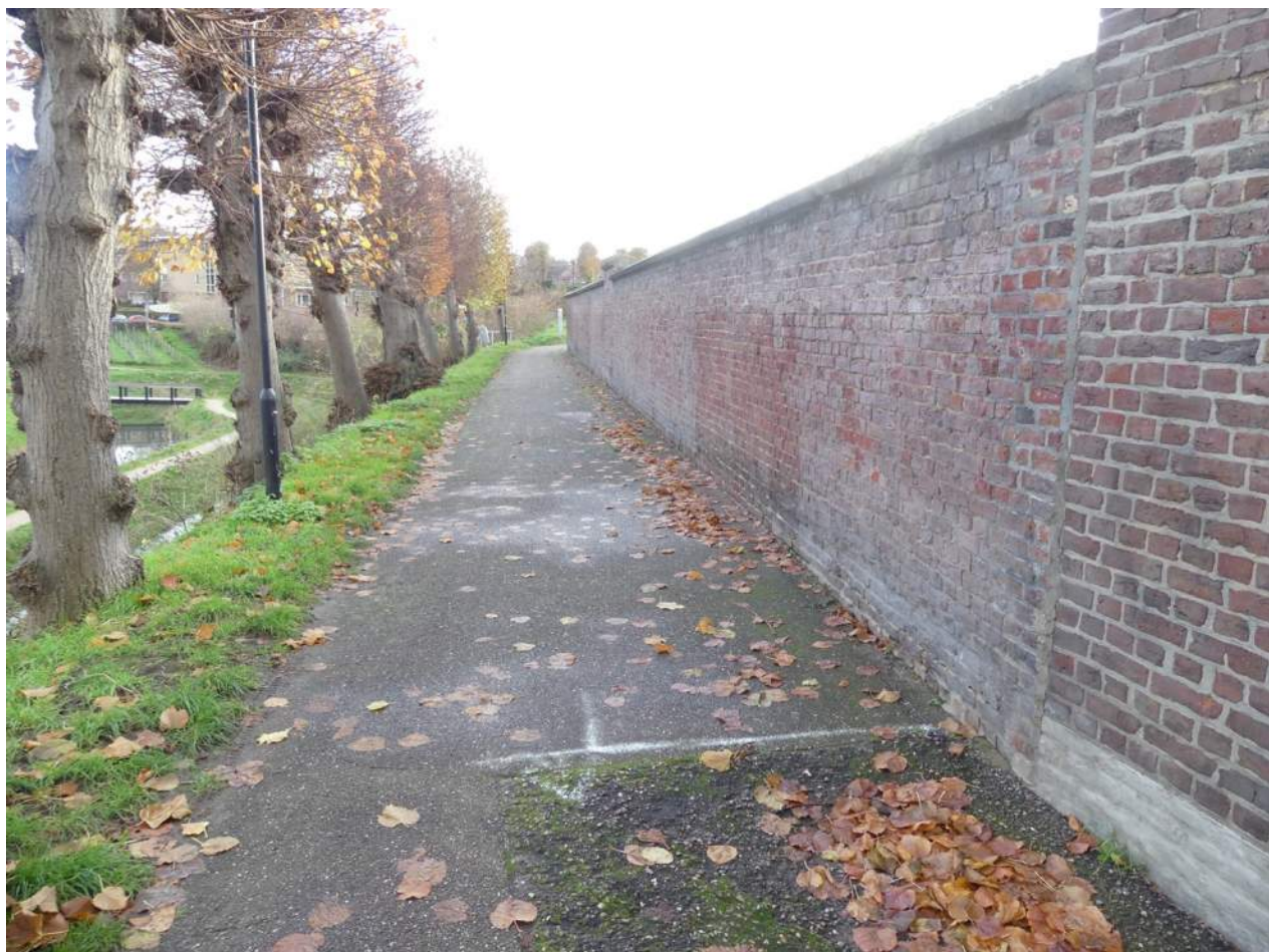
Afb. 08.00.03, overzicht van de muur op de Sanderboutwal
