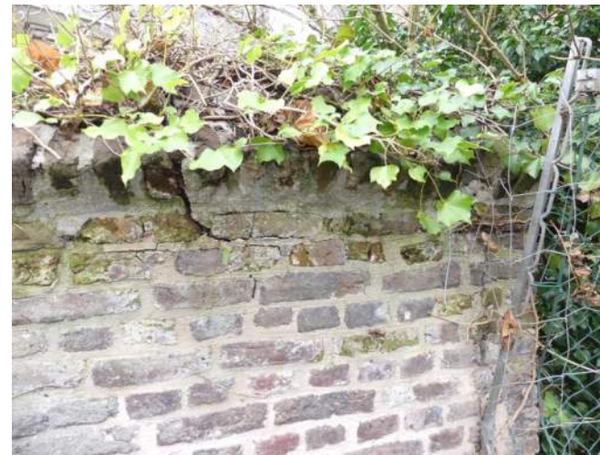
Afb. 10.22.09, losgescheurd voegwerk
