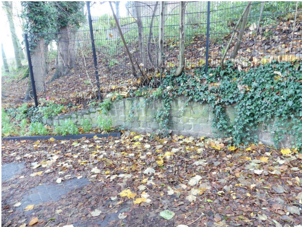
Afb. 01.00.04, overzicht (restanten van de) stadsmuur aan de Begijnenhofwal
