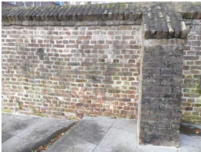
Afb. 05.22.63, vervuilde uitbloei en reinigingssporen oude graffiti
