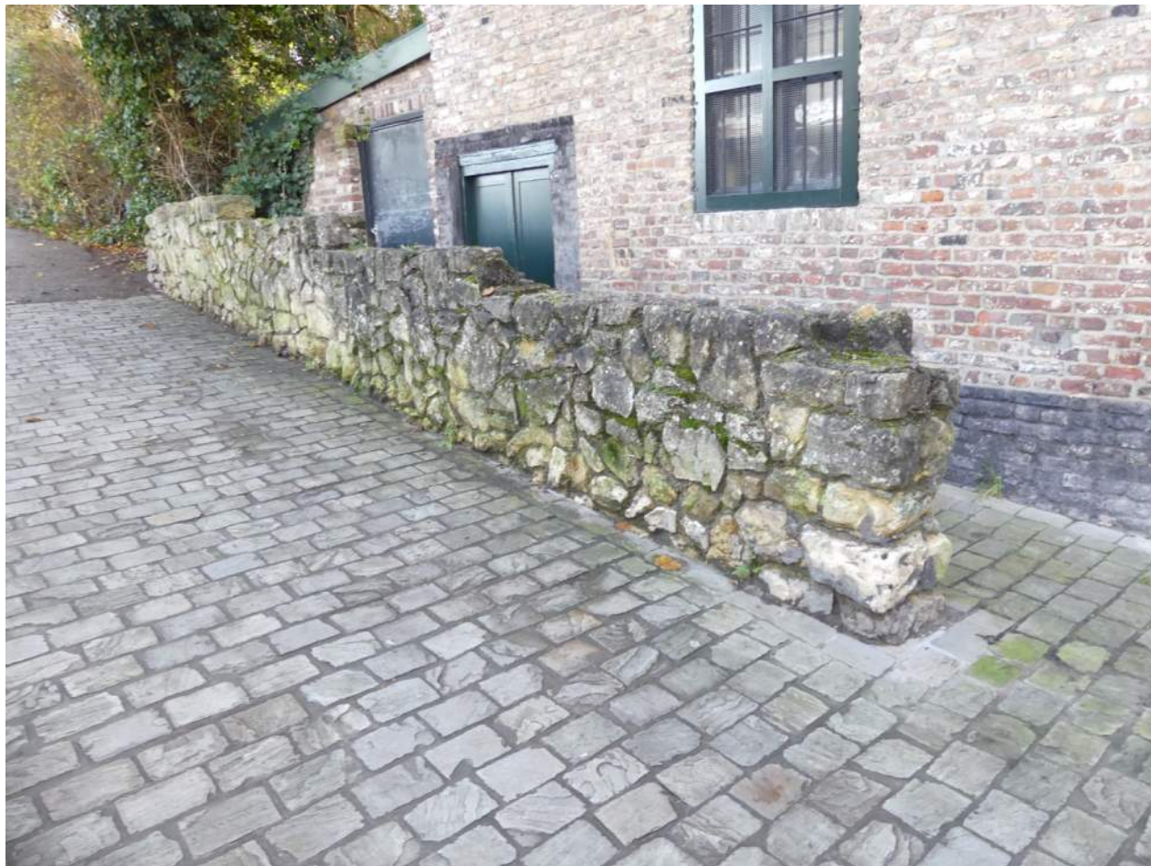
Afb. 07.00.04, overzicht rechterwalmuur Wal 07, richting Sanderboutwal
