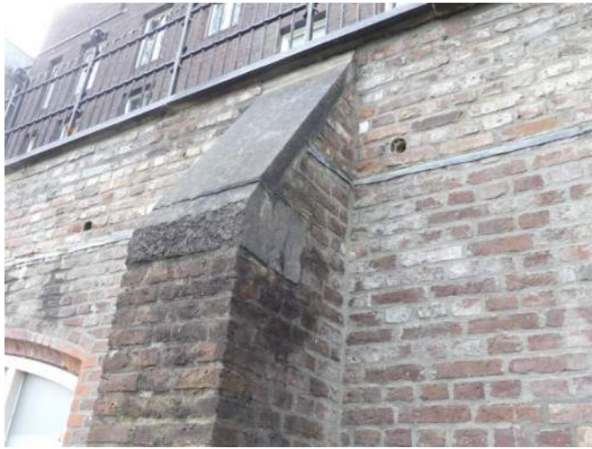
Afb. 04.35.17, afgehaakte neus afzaatblok penant
