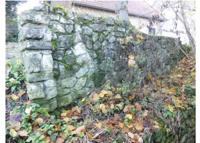
Afb. 07.35.02, ontbrekende blokken natuursteen en forse begroeiing
