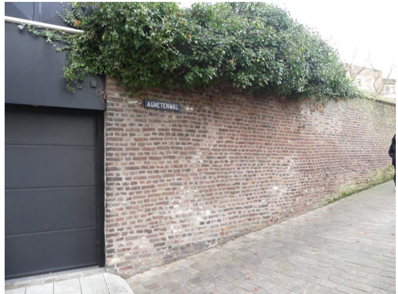
Afb. 10.00.07, overzicht laatste deel walmuur richting Agnetenwal
