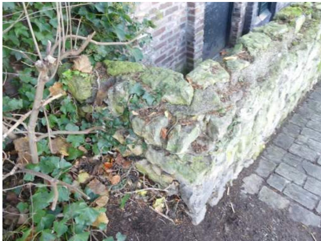
Afb. 07.35.09, ontbrekend blok natuursteen
