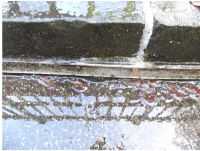
Afb. 04.35.30, ook aansluiting met klemstrip is zeer slecht uitgevoerd: er blijft water achter de klemstrip staan met kans op lekkage
