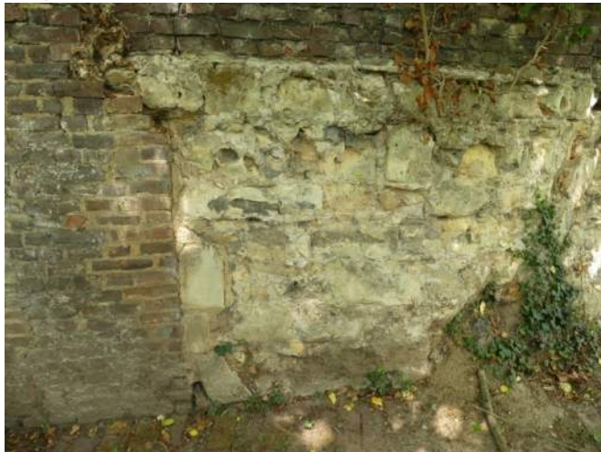
Afb. 11.35.01, aansluiting natuursteen paramentwerk in metselwerk
