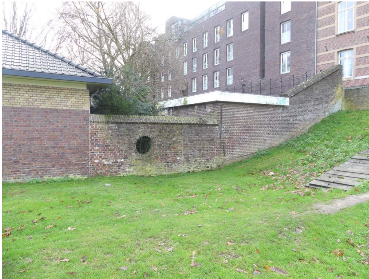
Afb. 04.00.12, overzicht aansluiting westelijke muur Ursulinentuin op Dominicanenwal met bouwwerken
