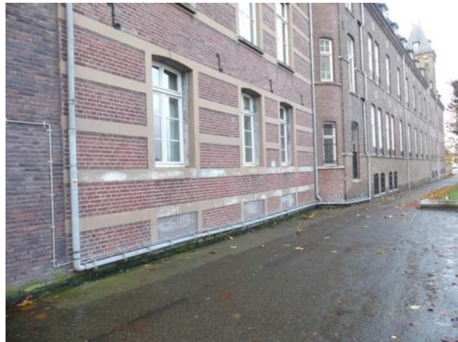
Afb. 04.15.02, geasfalteerd wandelpad op bovenzijde wal, waterbelasting aan zijde klooster en aan walmuurzijde
