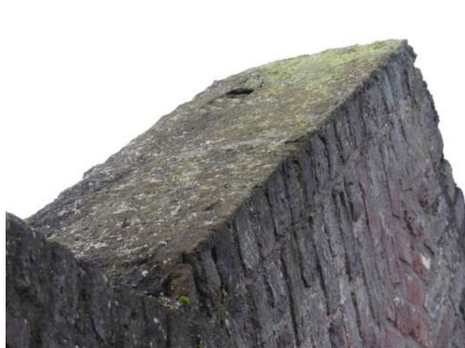
Afb. 03.22.06, beschadigd pleisterwerk
