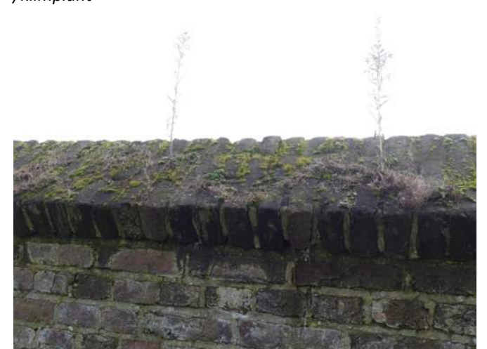
Afb. 04.22.56, onkruid op met alg- en mosgroei vervuilde ezelsrug
