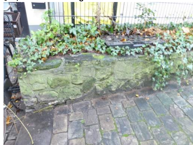
Afb. 01.35.01, losgescheurd voegwerk
