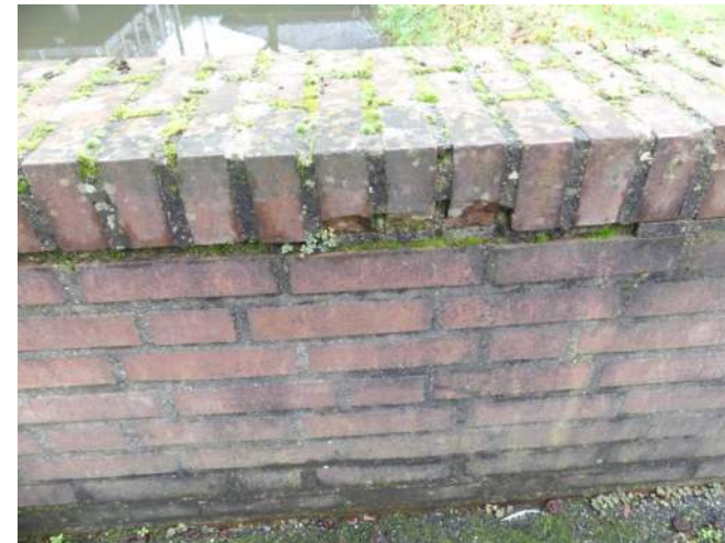
Afb. 04.22.09, afgebroken stenen, alg- en mosgroei
