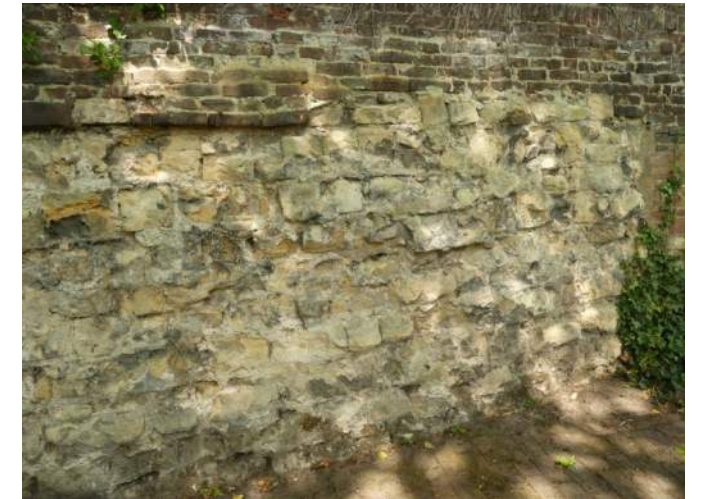
Afb. 11.35.06, zeer ver versleten blokken direct onder baksteen verhoging
