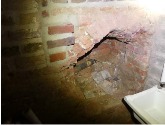
Afb. 05.22.10, afschilferende en kapotte stenen
