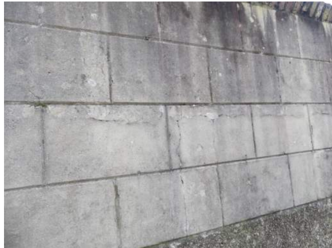
Afb. 06.40.04, gescheurd pleisterwerk
