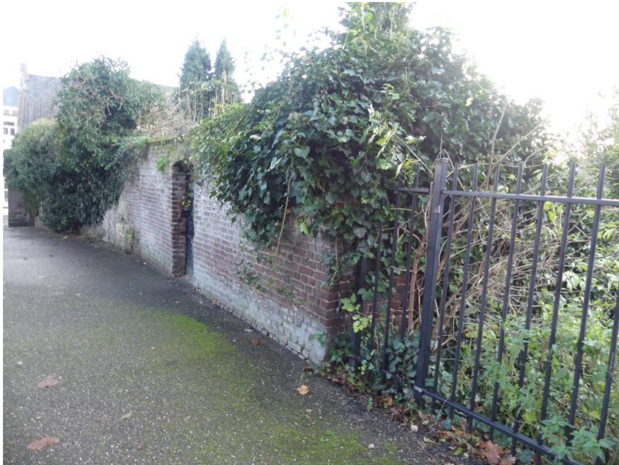
Afb. 05.00.08, overzicht walmuur langs privé-perceel, richting Paardestraat
