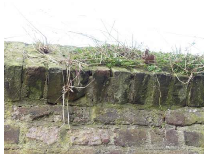
Afb. 04.22.54, onkruid op met alg- en mosgroei vervuilde ezelsrug
