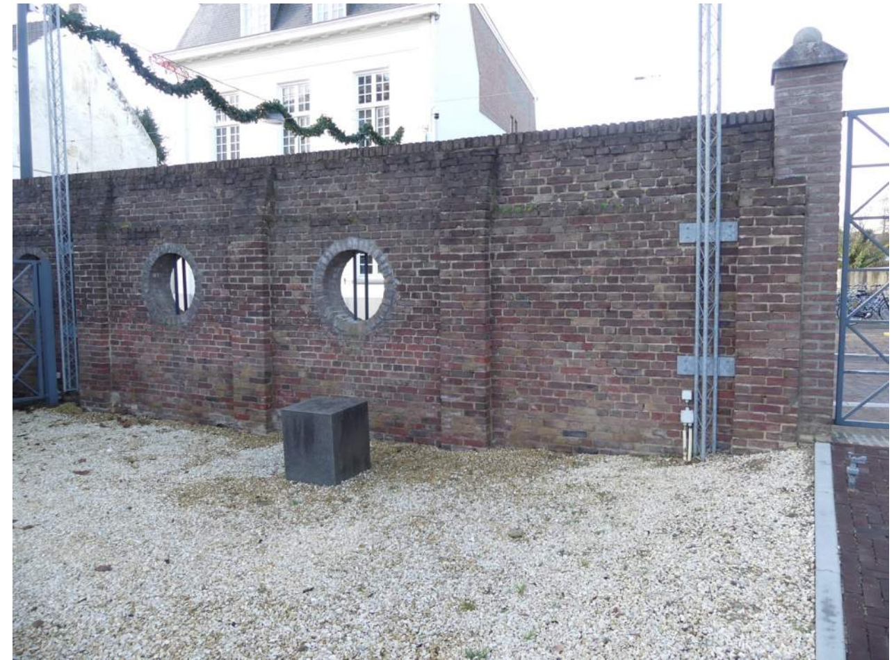
Afb. 06.00.08, overzicht binnenzijde voorste muur met rechts een moderne poortpenant
