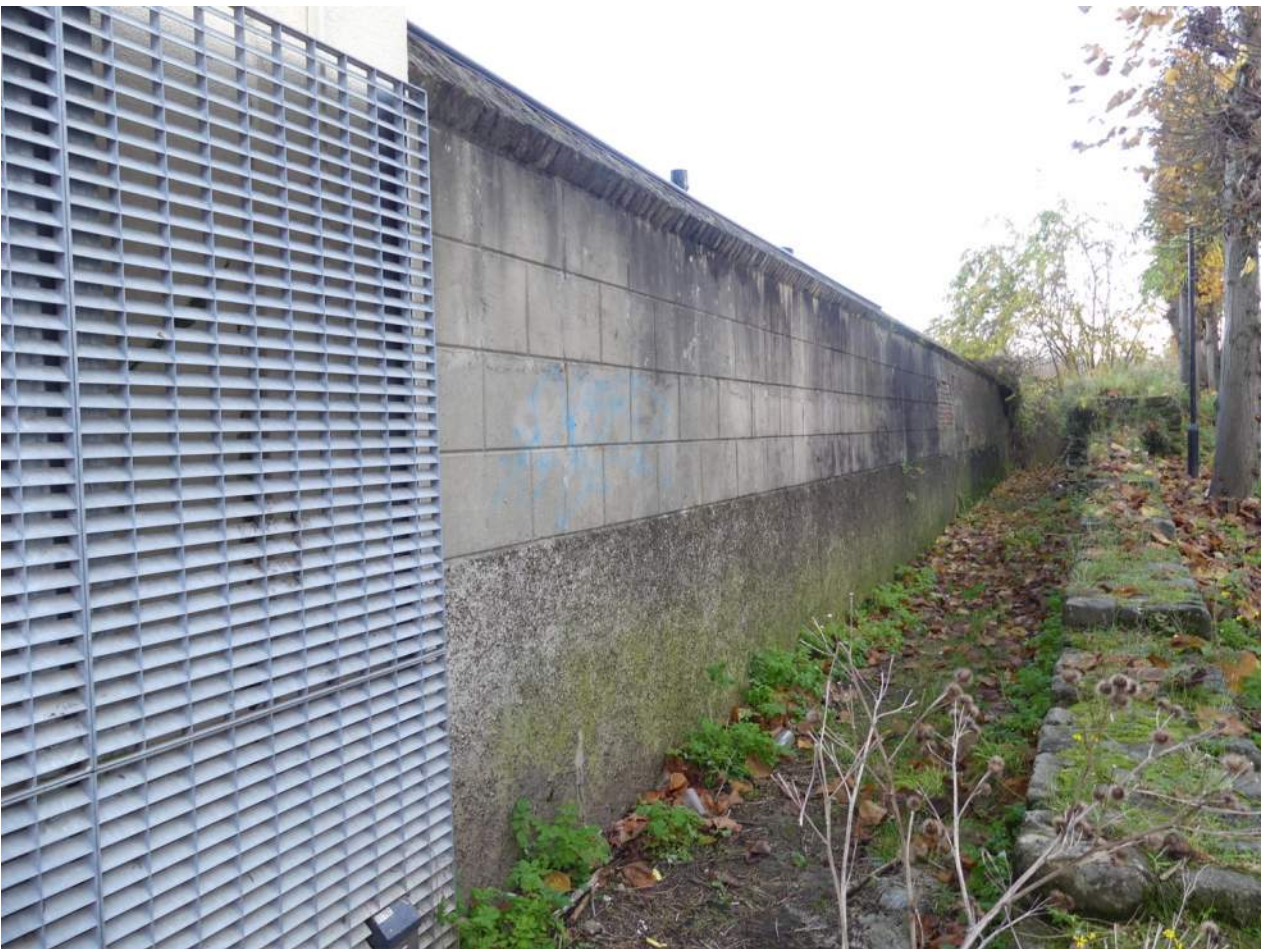
Afb. 06.00.11, overzicht buitenzijde van de muur met ezelsrug langs de tuin
