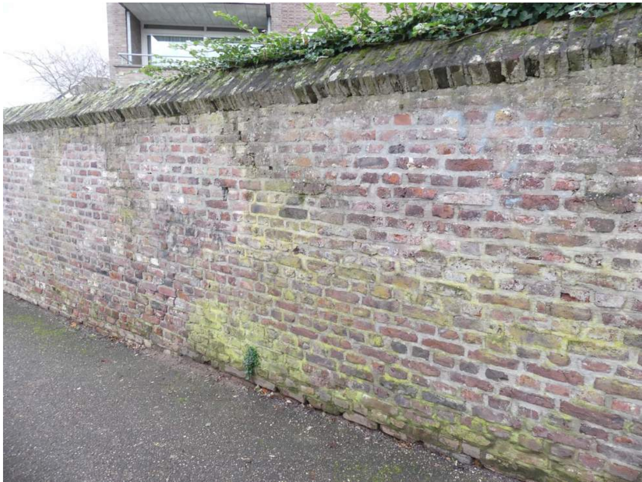
Afb. 10.00.04, overzicht walmuur ter hoogte van de nieuwbouw
