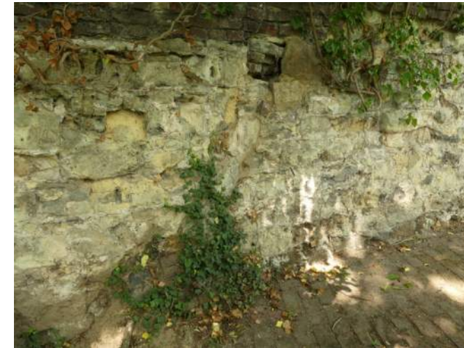
Afb. 11.35.05, onsamenvhangend geheel met diverse verder afgeboerde blokken
