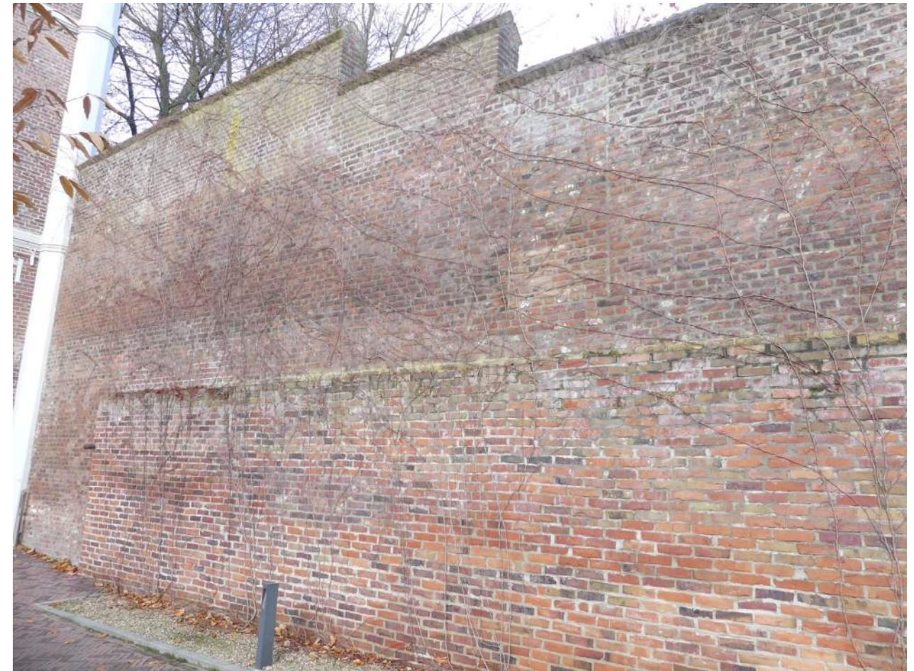
Afb. 05.00.10, overzicht binnenzijde muur langs voorterrein Jezuïeten Internaat tegen Dominicanenwal
