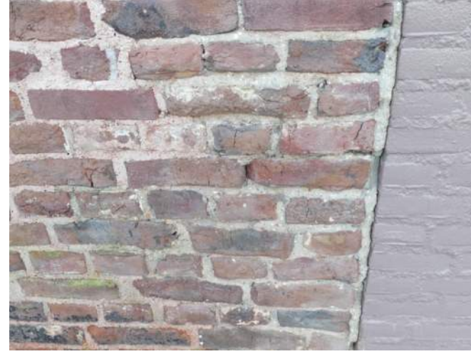
Afb. 03.22.11, losgescheurde loodvoeg
