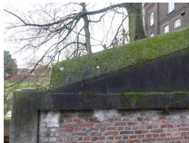
Afb. 04.21.03, vervuild oppervlak, alg- en mosgroei
