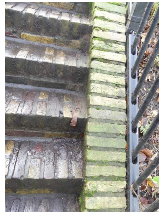
Afb. 05.22.51, met mos begroeid en uitgevallen voegwerk uit de rollaag
