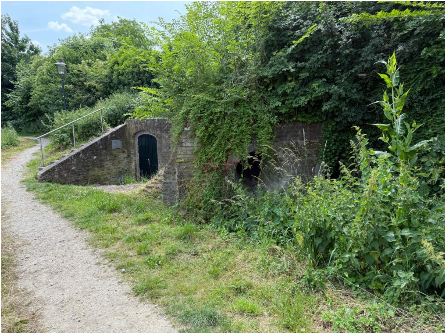
Afb. 12.00.02, aanzicht van de noordelijke kazemat met toegangsdeur via de oostelijke kruitkamer en geschutsluiken (rechts, achter de begroeiing)
