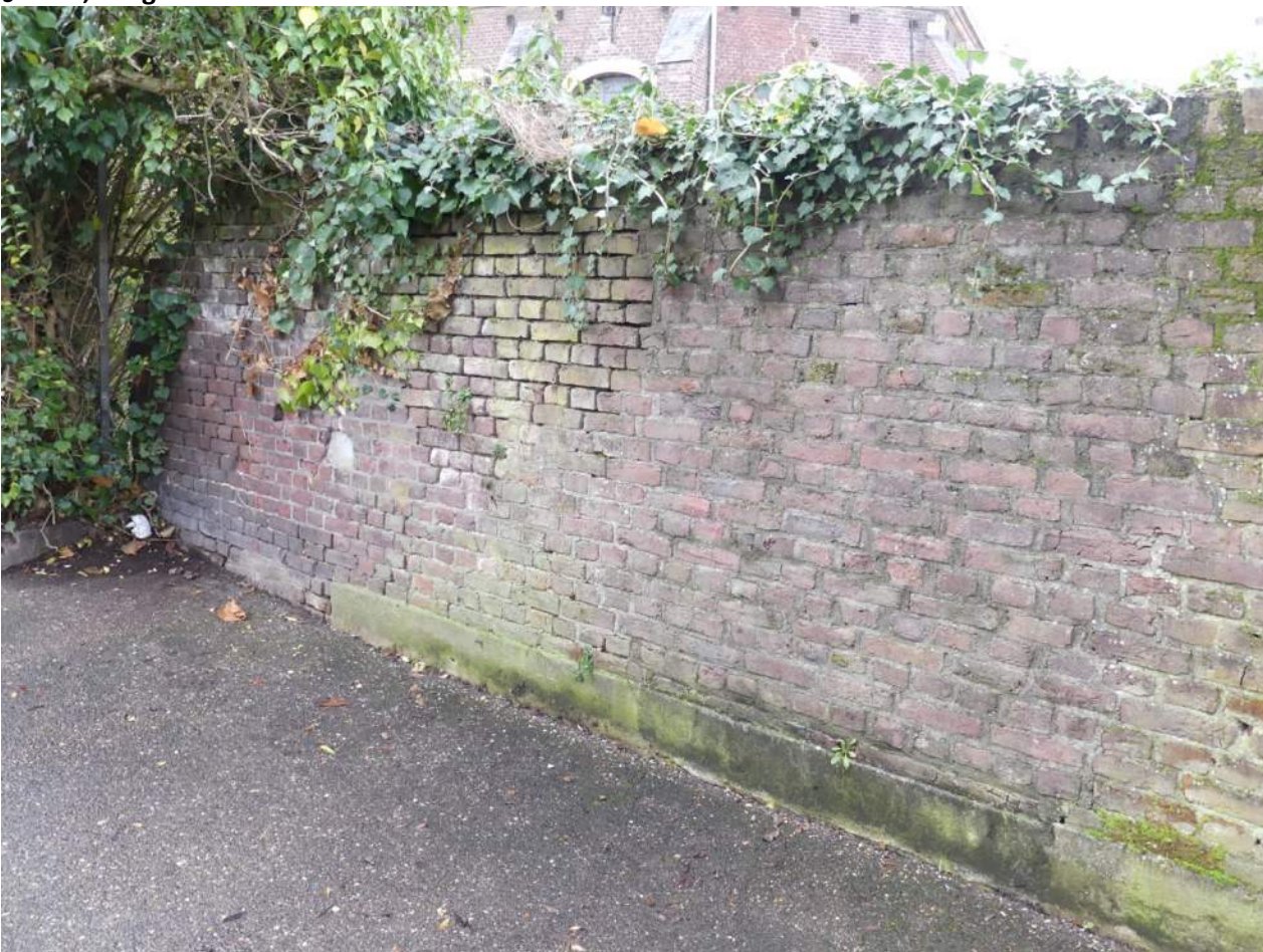
Afb. 09.22.01, uitgevallen voegwerk, alg- en mosgroei en forse begroeiing
