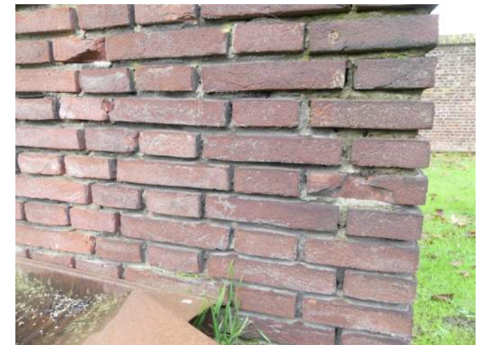
Afb. 04.22.12, afgebroken stenen
