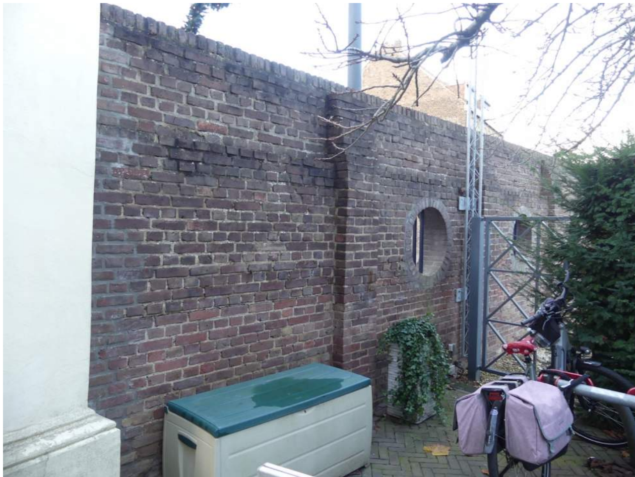
Afb. 06.00.07, binnenzijde van de voorste muur, links de binnenzijde van de linkerpoortpenant
