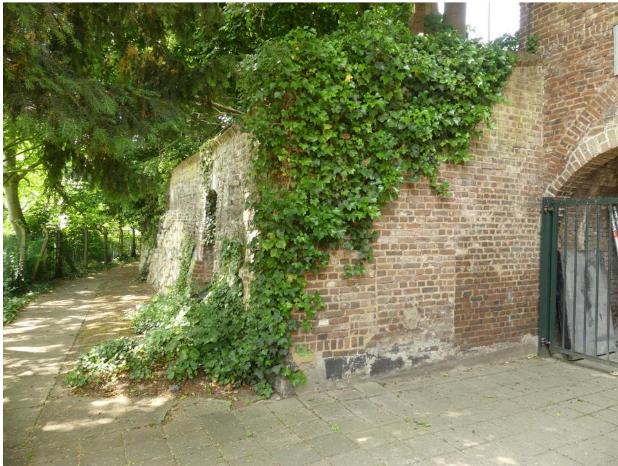
Afb. 11.00.04, overzicht grondkerende schuin aflopende walmuur naast poort
