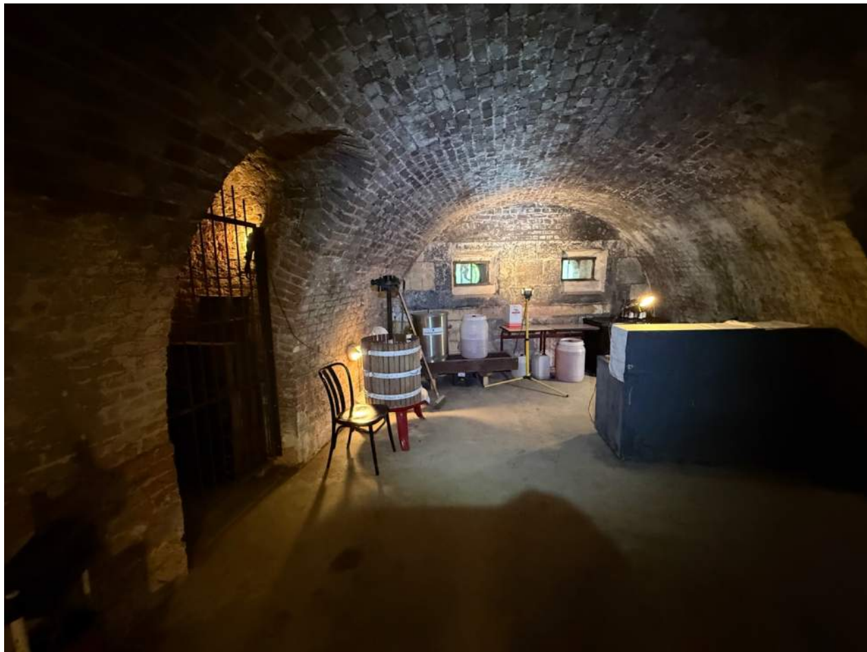
Afb. 12.00.08, overzicht geschutskamer richting geschutsluiken
