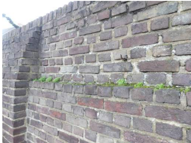
Afb. 06.22.25, lichte alg- en mosgroei op verspringing in de muur
