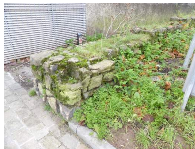
Afb. 07.35.05, ontbrekend blok natuursteen en vegetatie
