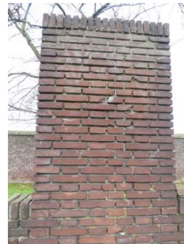
Afb. 04.22.11, afgebroken stenen
