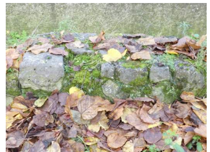
Afb. 07.35.06, ontbrekend blok natuursteen en forse mosgroei
