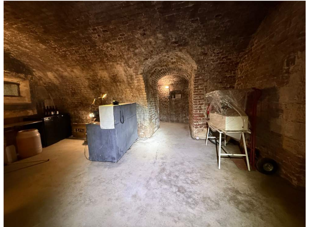
Afb. 12.00.06, overzicht geschutskamer richting tot toegang verbouwde kruitkamer
