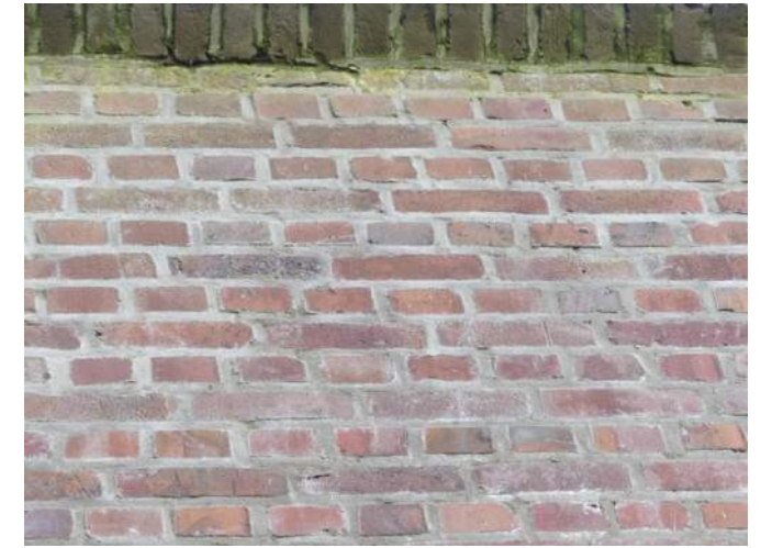
Afb. 05.22.27, vergeten (?) stukje voegwerk onder ezelsrug, daardoor alg- en mosgroei
