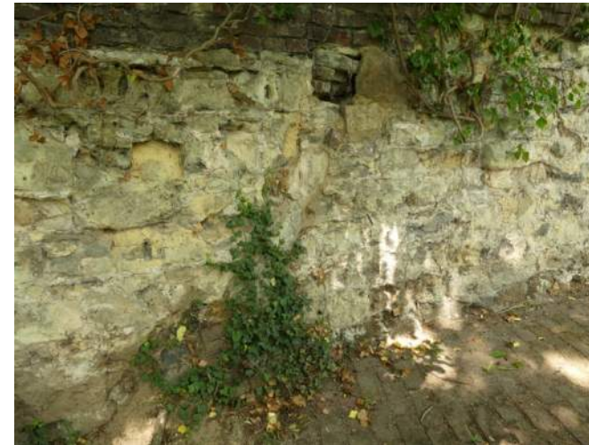
Afb. 11.35.05, onsamenvhangend geheel met diverse verder afgeboerde blokken
