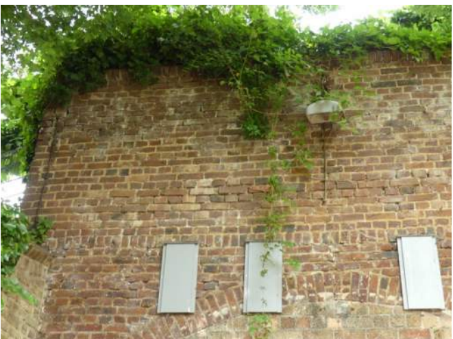
Afb. 11.22.18, versleten en uitgesleten voegwerk op meerdere lagen en forse begroeiing
