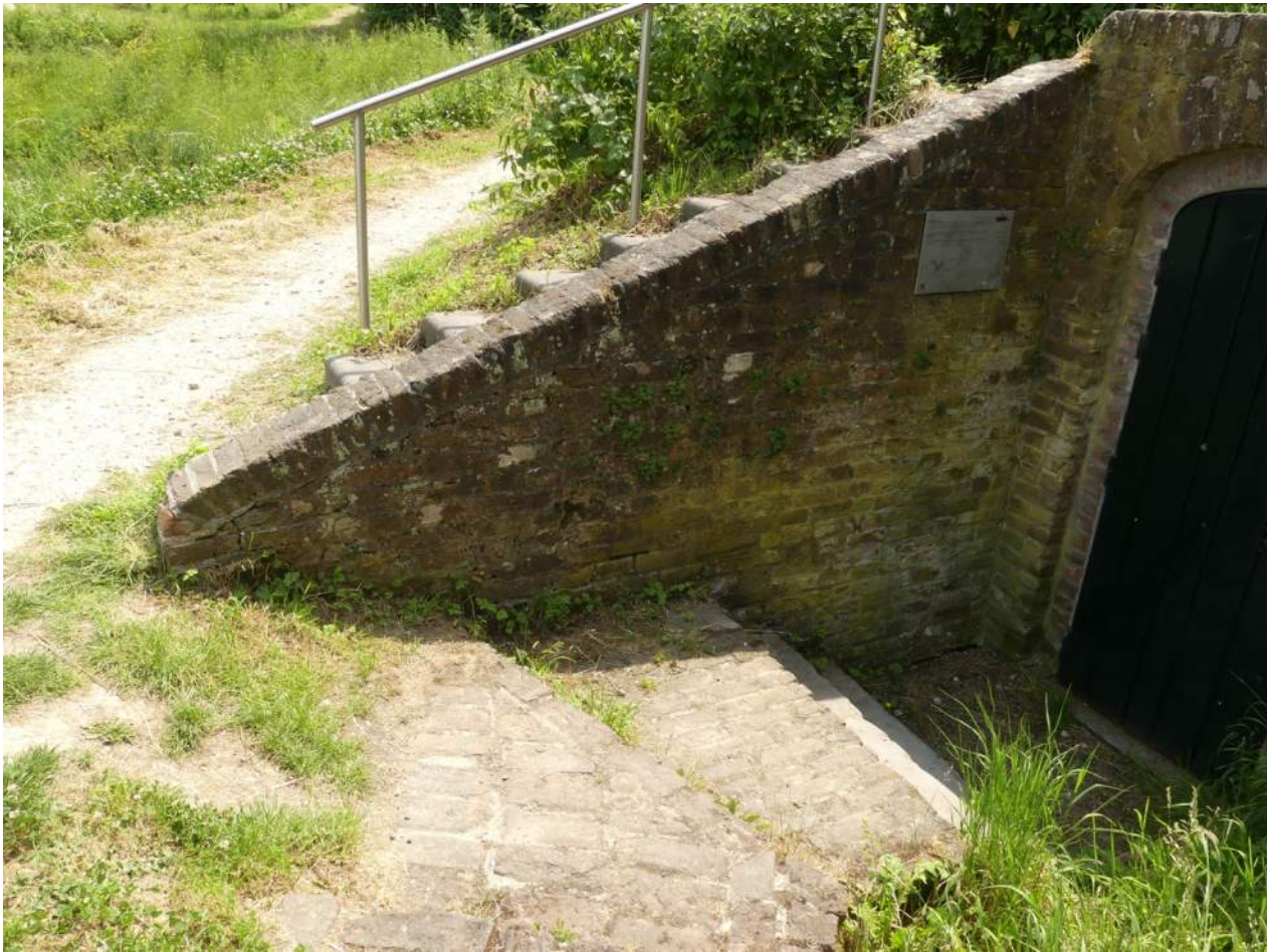
Afb. 12.00.04, grondkerende walmuur, links van de tot toegang verbouwde kruitkamer
