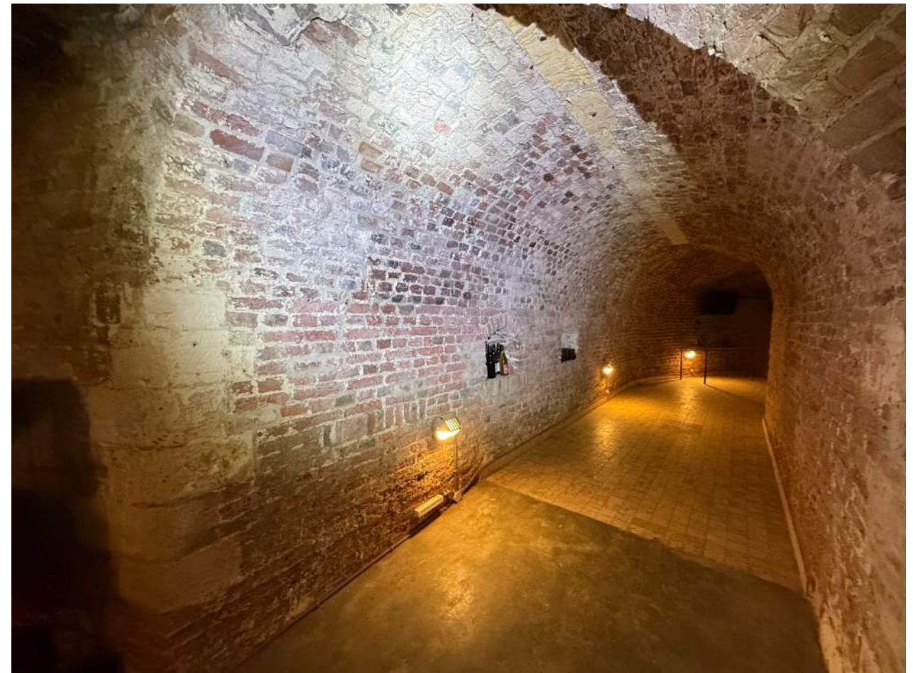
Afb. 12.00.10, overzicht gang richting poterne
