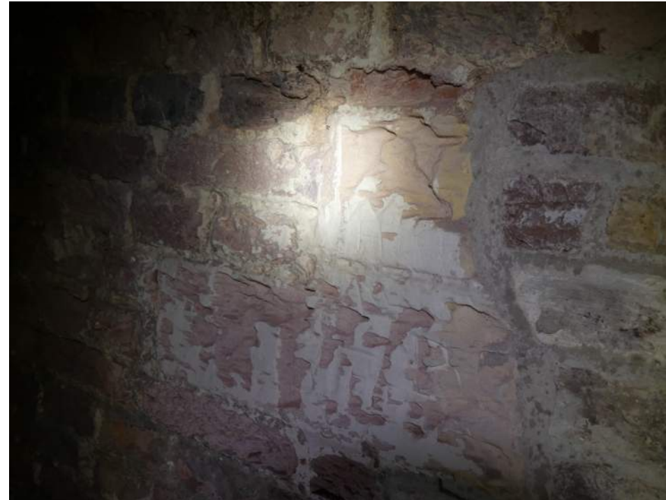
Afb. 12.35.01, afschilferend natuursteen blok
