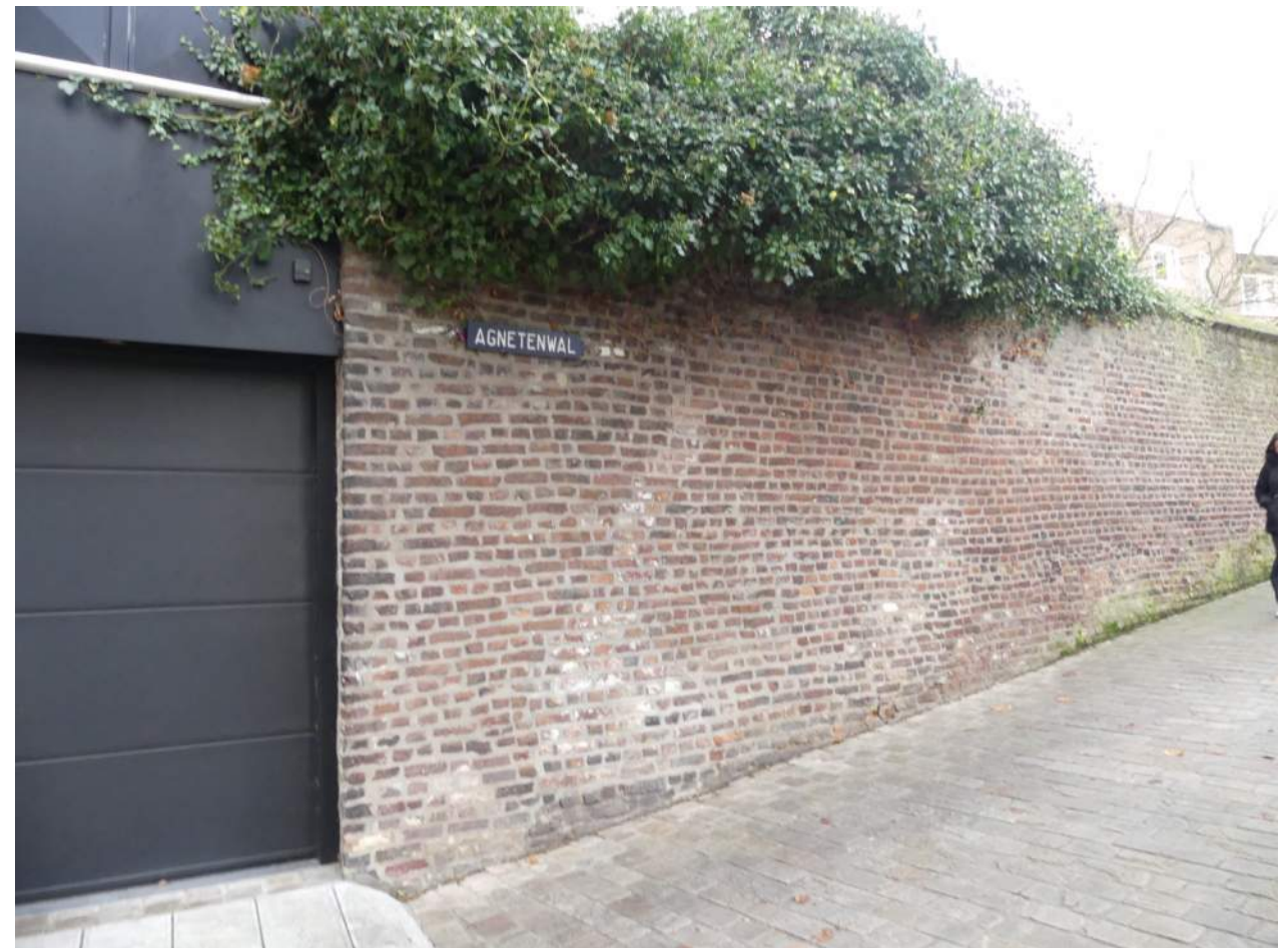
Afb. 10.00.07, overzicht laatste deel walmuur richting Agnetenwal
