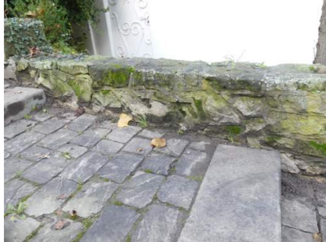
Afb. 05.35.10, losgescheurd voegwerk
