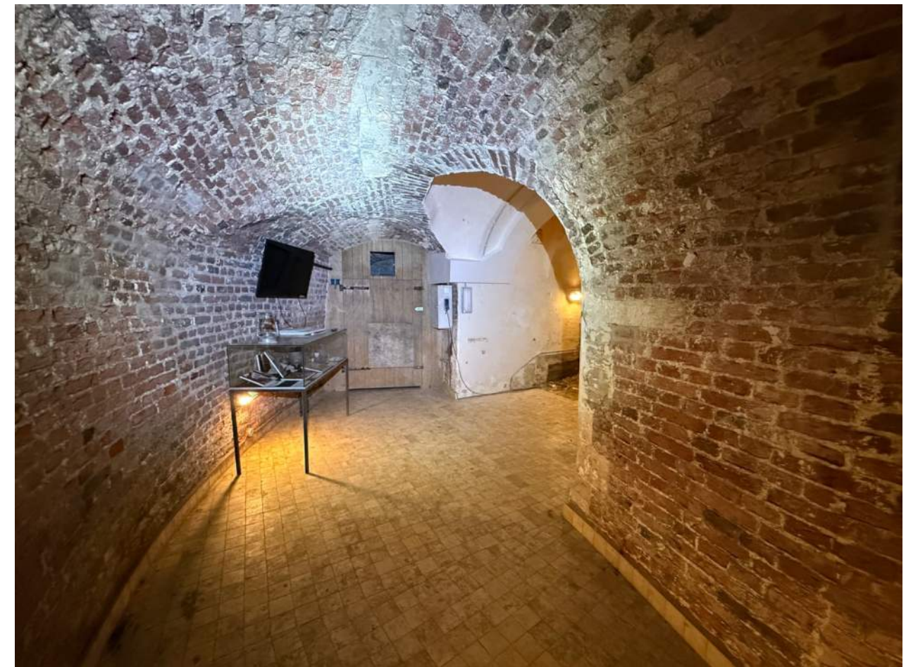
Afb. 12.00.11, overzicht hoek gang en poterne, achter het houten wandje is installatie geplaatst
