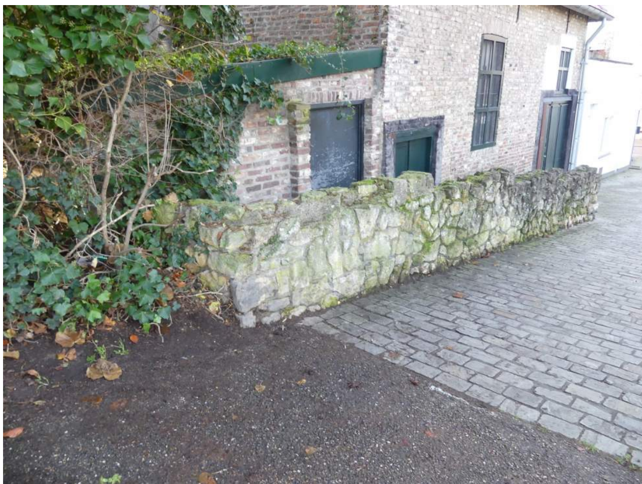
Afb. 07.00.05, overzicht rechterwalmuur Wal 07, richting Paardestraat
