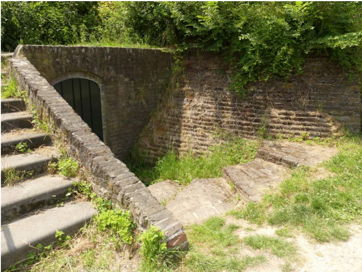
Afb. 12.00.05, grondkerende walmuur met toegang en rechts de 'buitenmuur' van de geschutskamer
