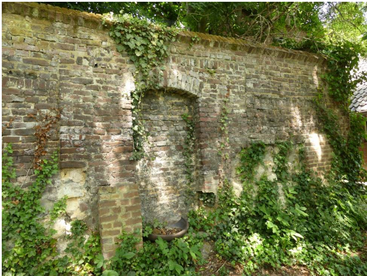
Afb. 11.00.05, overzicht grondkerende walmuur parallel aan Agnetenwal; links onderin een eerste stuk natuursteen paramentwerk
