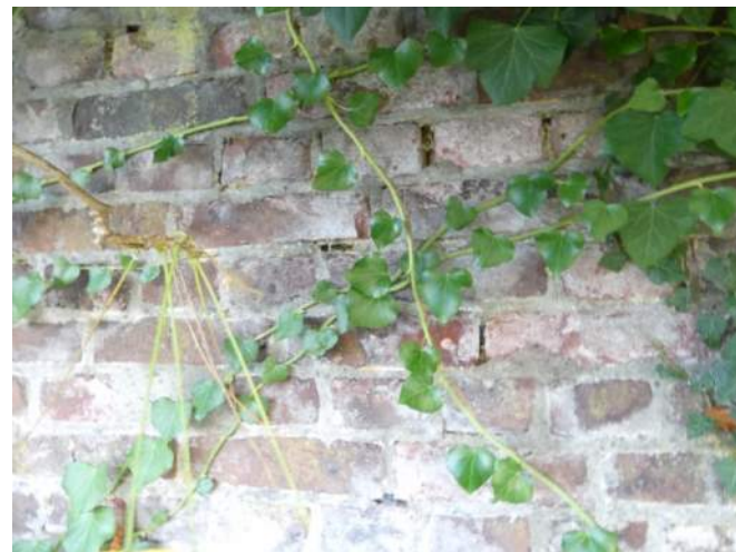
Afb. 06.22.12, foutief hersteld, weer loszittend en uitgevallen, voegwerk
