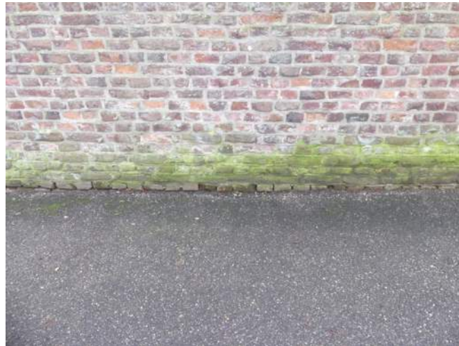
Afb. 10.22.04, kapotte steen en detonerend (foutief hersteld) voegwerk
