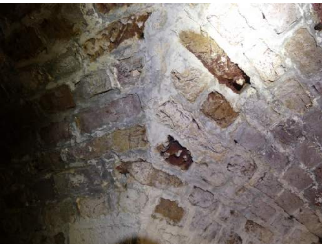
Afb. 05.22.06, losgescheurde stenen
