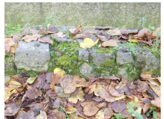
Afb. 07.35.06, ontbrekend blok natuursteen en forse mosgroei
