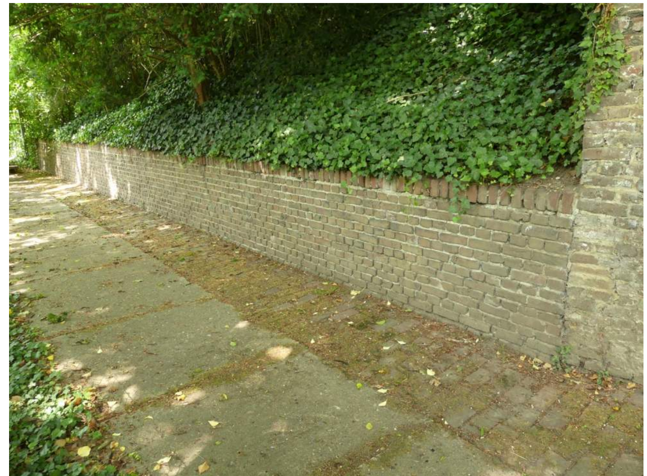
Afb. 11.00.07, overzicht grondkerende lage muur
