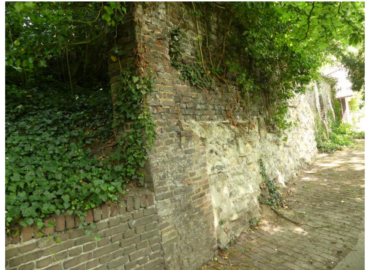
Afb. 11.00.06, overzicht grondkerende walmuur parallel aan Agnetenwal; onderin het natuursteen paramentwerk
