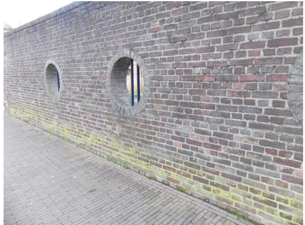
Afb. 06.00.02, gedeelte van de muur in het vooraanzicht met anderhalf steens rollaag rondom de ronde sparingen
