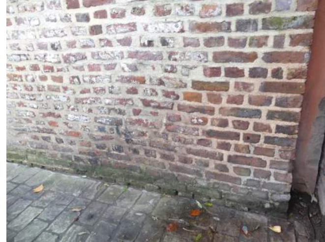
Afb. 05.40.01, oude slemp- of pleisterwerksporen
