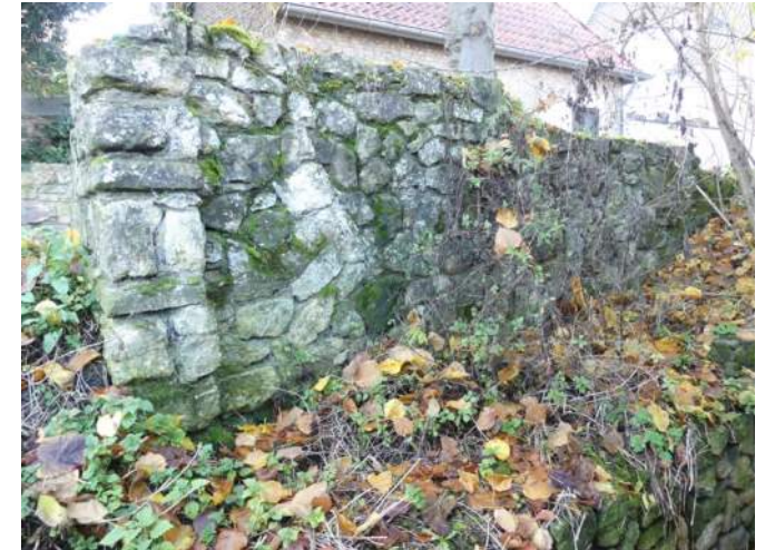
Afb. 07.35.02, ontbrekende blokken natuursteen en forse begroeiing
