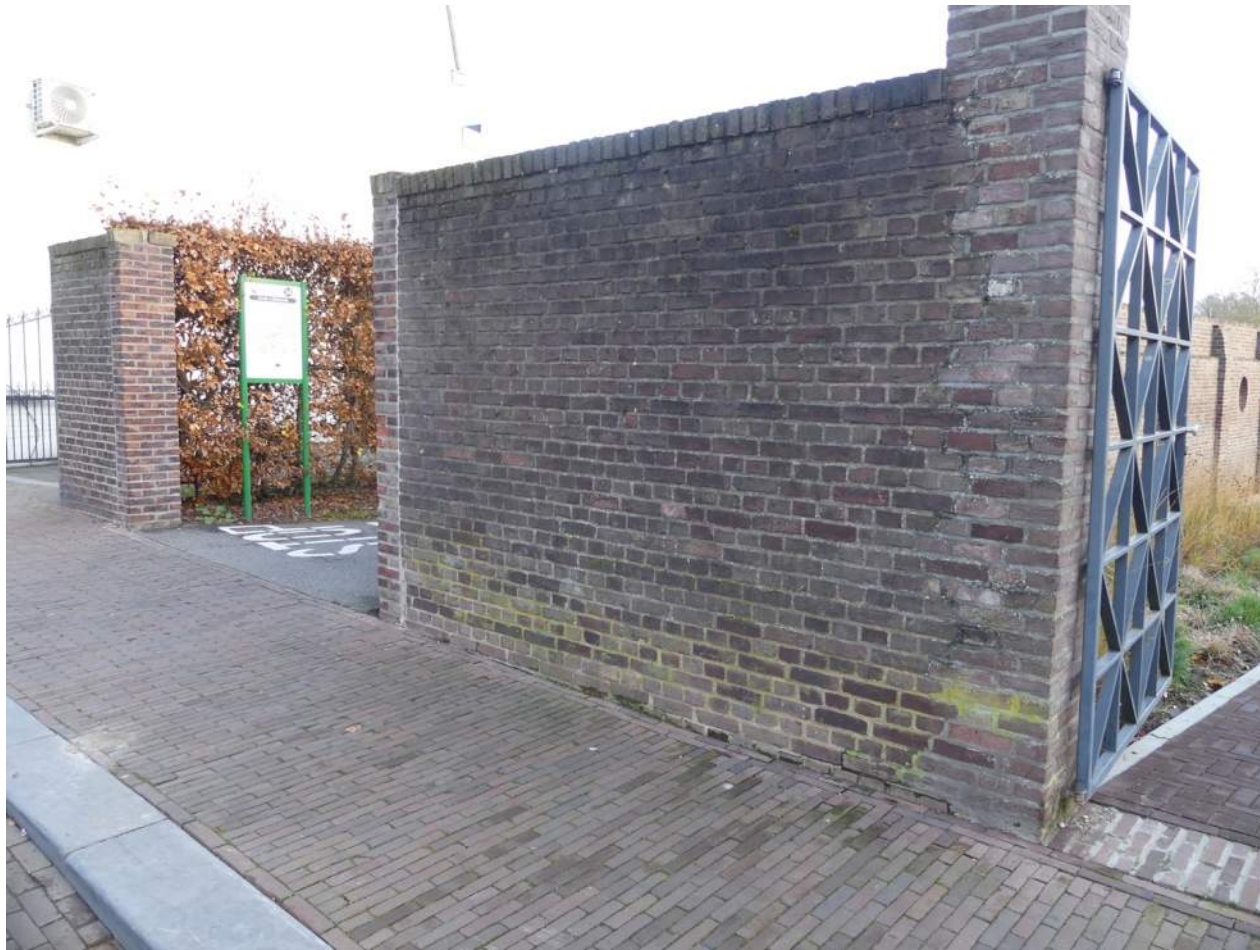
Afb. 06.00.06, overzicht van het linkerdeel van de 'straatmuur' met de moderne poortpenanten en aan de linkerkzijde een moderner geplaatste muur
