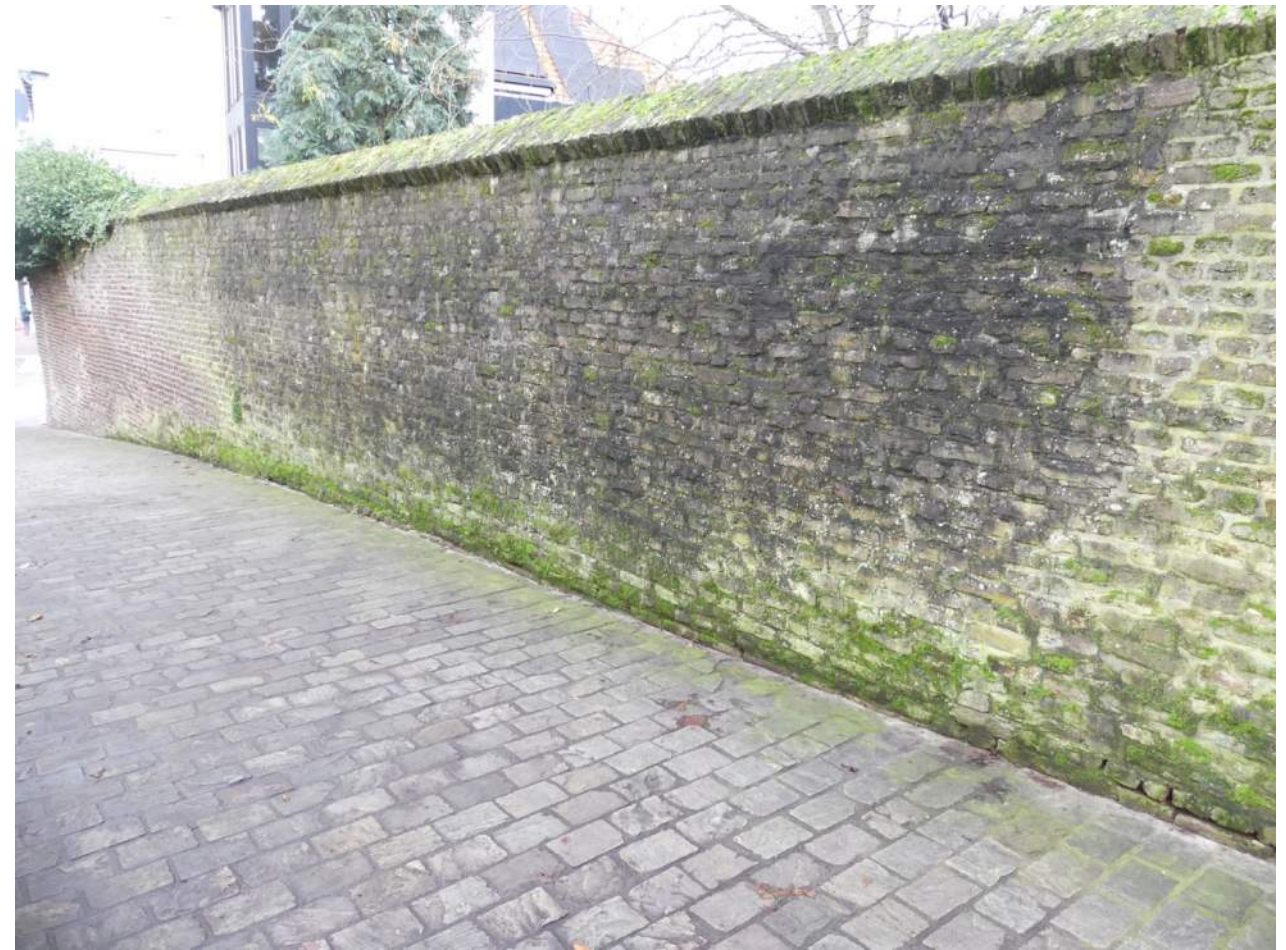
Afb. 10.00.06, overzicht walmuur richting eind Agnetenwal
