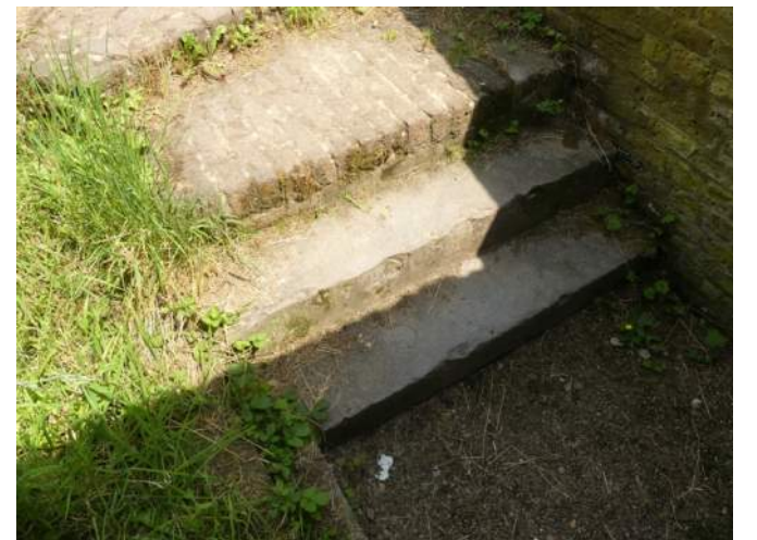
Afb. 12.22.28, begroeiing tussen hardsteen traptreden en algaanslag op traptreden
