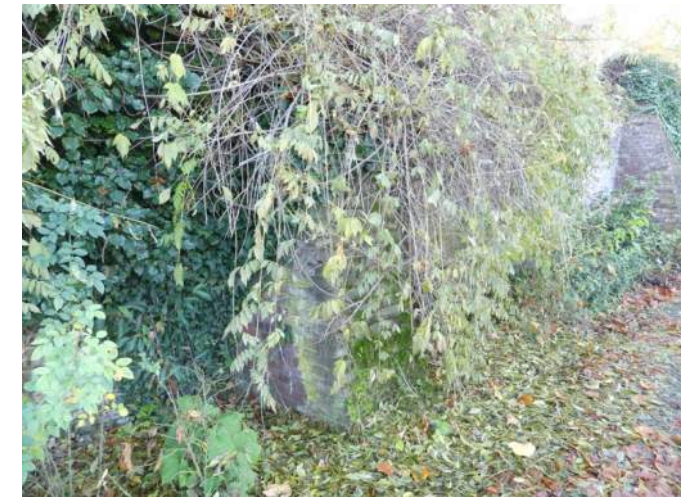
Afb. 06.22.33, volledig met begroeiing vervuilde muur
