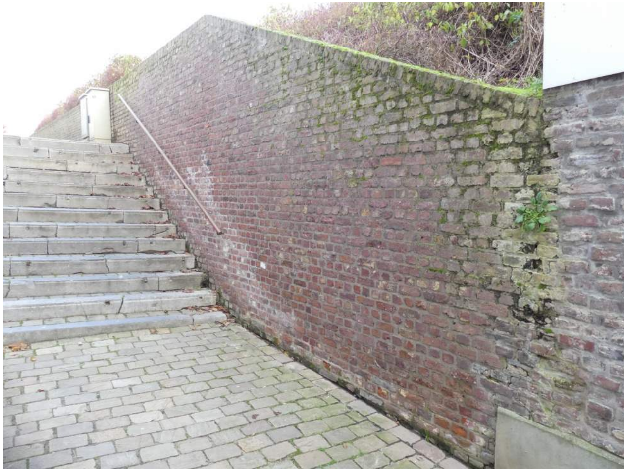
Afb. 08.00.10, overzicht grondkerende walmuur ter hoogte van de trap bij de Putstraat
