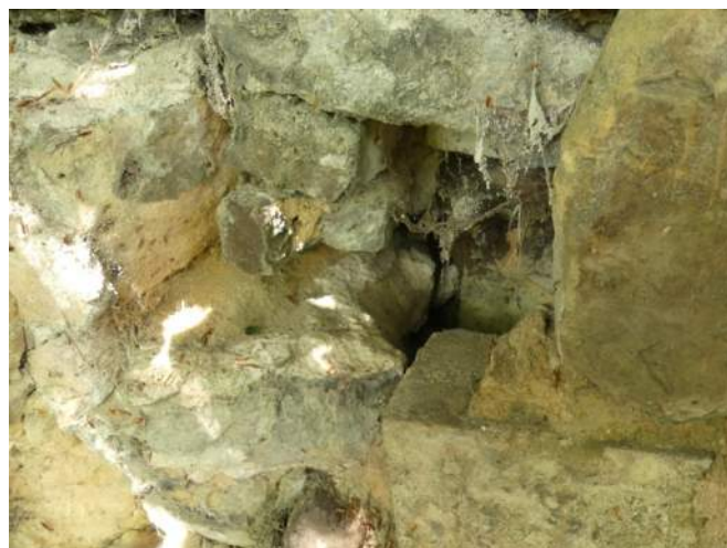
Afb. 11.35.04, onsamenvhangende aansluiting
