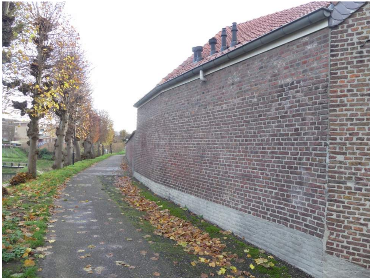
Afb. 08.00.02, overzicht van het eerste stuk walmuur, opgehoogd tbv tegen de walmuur gepositioneerd bouwwerk, ter hoogte van de Pullestraat
