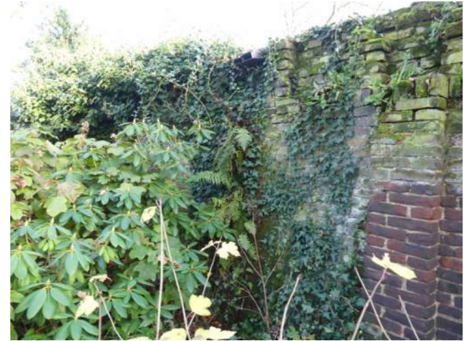
Afb. 05.22.62, volledig overgroeide muur
