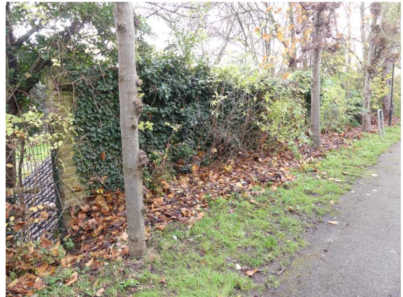
Afb. 11.00.03, aanzicht van -fors begroeidse- walmuur boven bouwwerk vanaf de bovenzijde van de Agnetenwal
