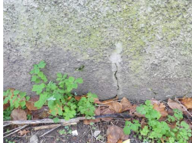
Afb. 06.40.02, gescheurd pleisterwerk
