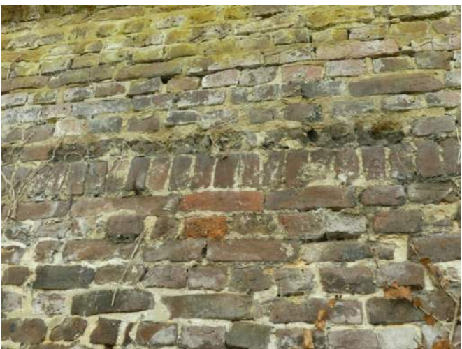
Afb. 11.22.16, versleten en uitgesleten, loszittend voegwerk, algroei en oude begroeiing
