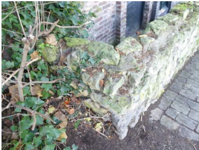
Afb. 07.35.09, ontbrekend blok natuursteen
