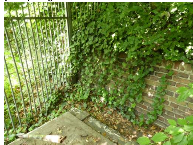
Afb. 11.22.21, begroeiing over lage walmuur
