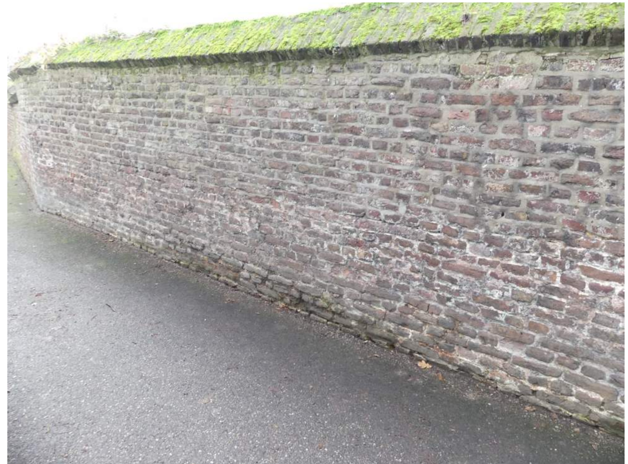
Afb. 10.00.02, overzicht van een volgend deel van de walmuur
