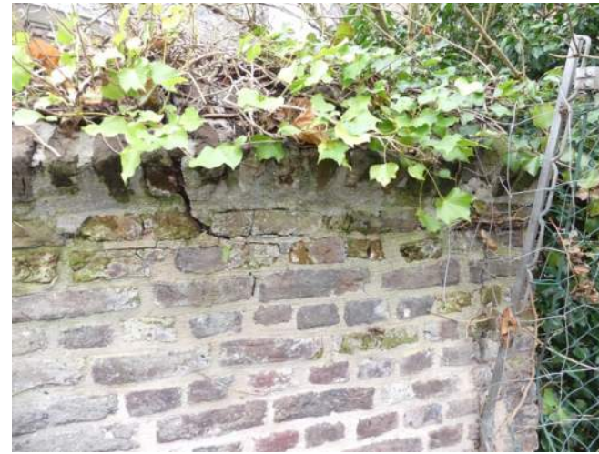
Afb. 10.22.09, losgescheurd voegwerk
