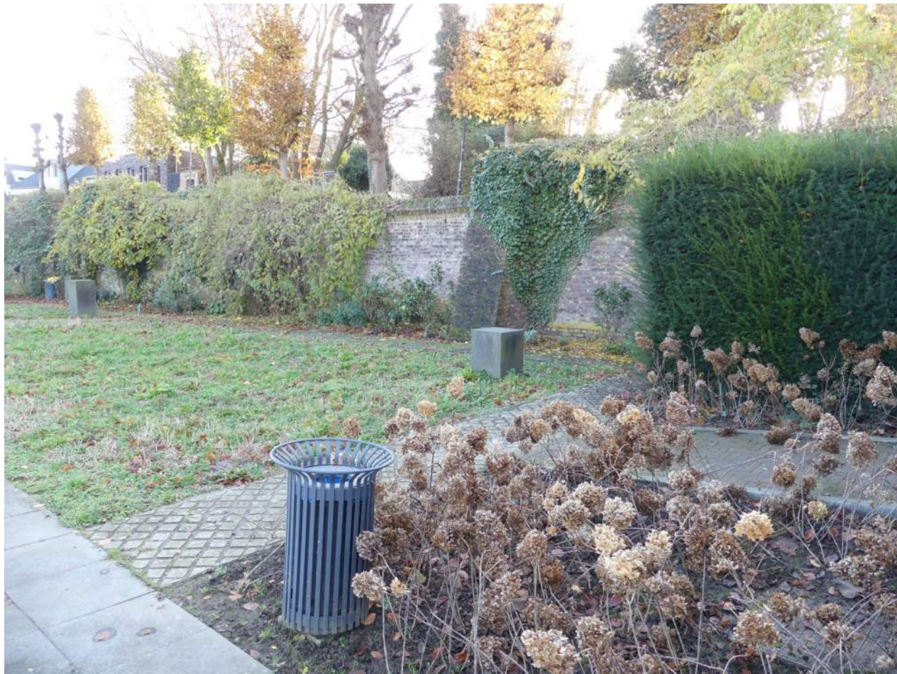
Afb. 06.00.10, overzicht binnenzijde walmuur met steunberen en ezelsrug langs de rechterzijde van de tuin
