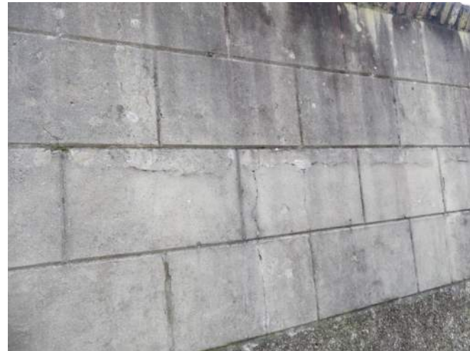
Afb. 06.40.04, gescheurd pleisterwerk
