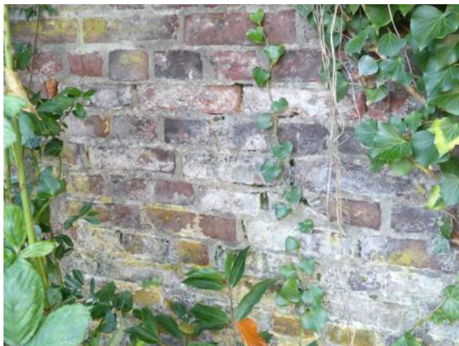
Afb. 06.22.11, foutief hersteld, weer loszittend en uitgevallen voegwerk
