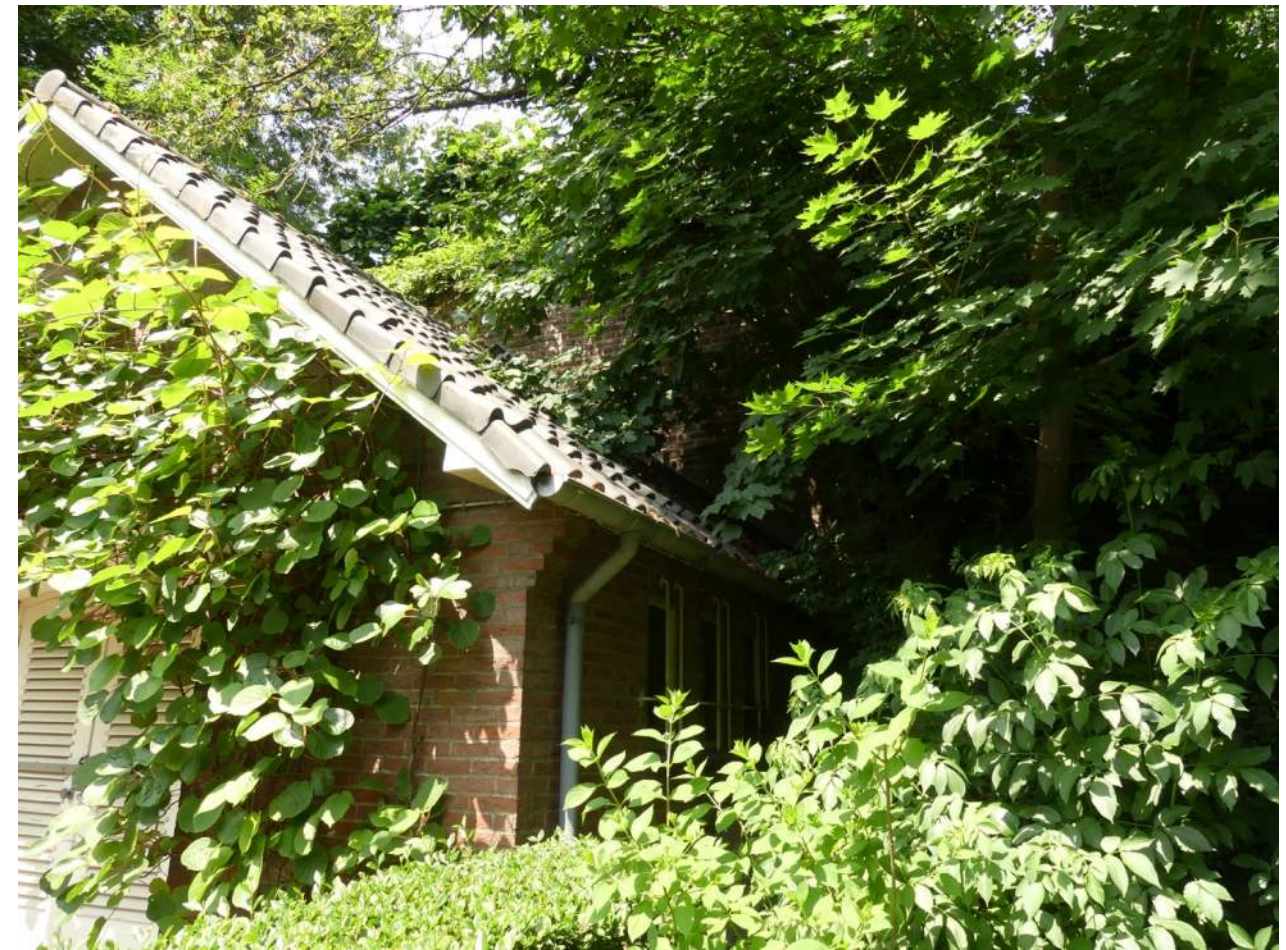
Afb. 11.00.02, overzicht van -fors begroeidse- walmuur boven bouwwerk
