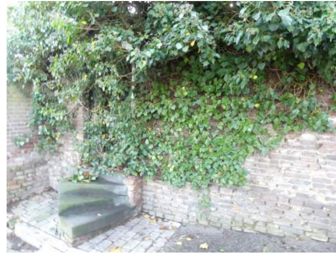
Afb. 05.22.61, volledig overgroeide muur
