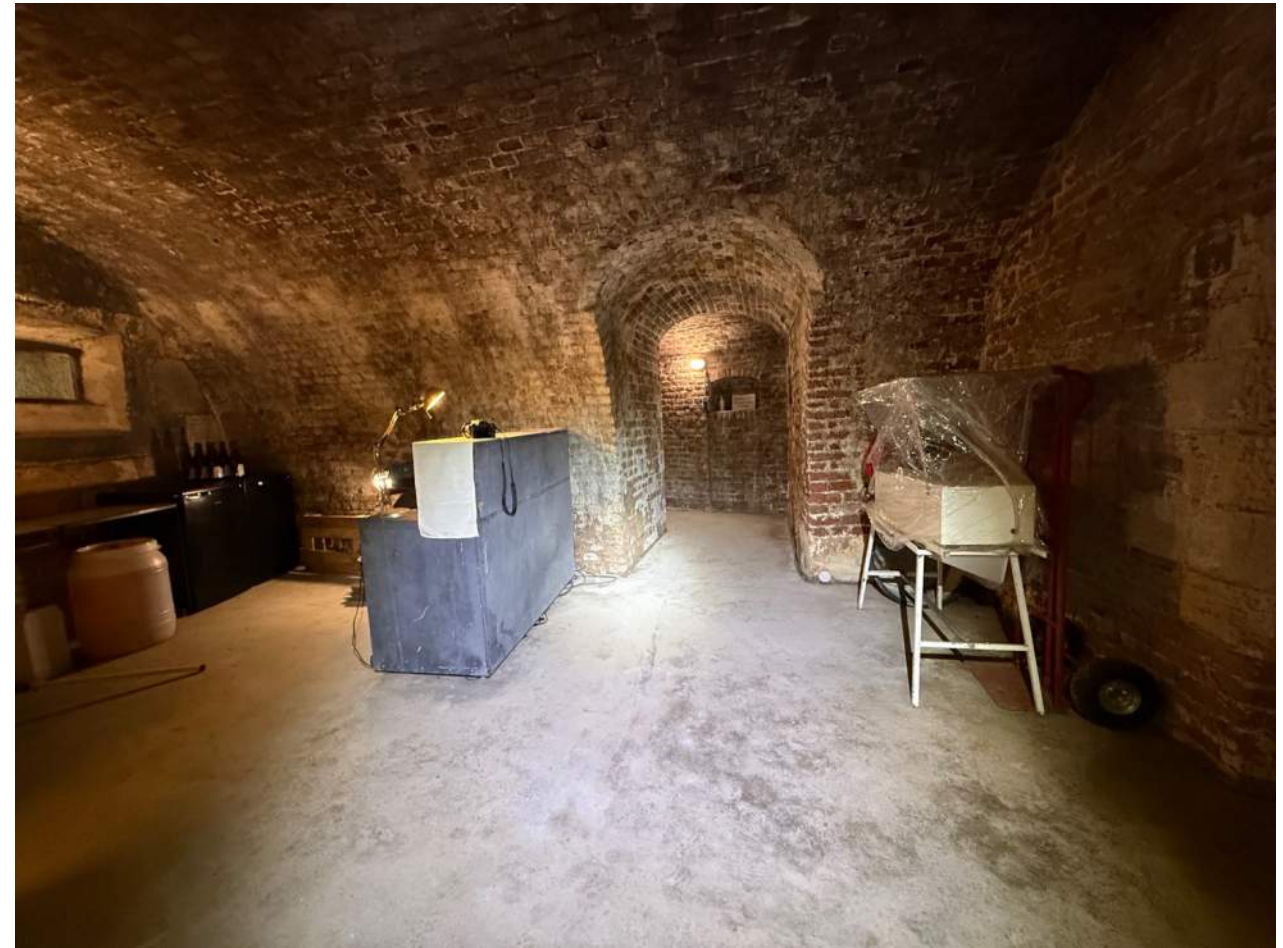
Afb. 12.00.06, overzicht geschutskamer richting tot toegang verbouwde kruitkamer
