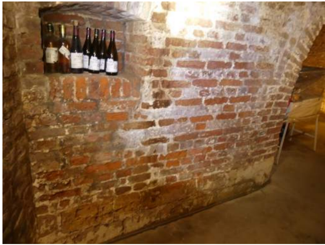
Afb. 05.22.08, kapotte en afschilferende stenen
