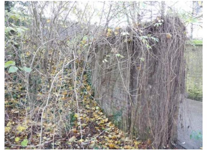
Afb. 05.22.60, volledig overgroeide muur
