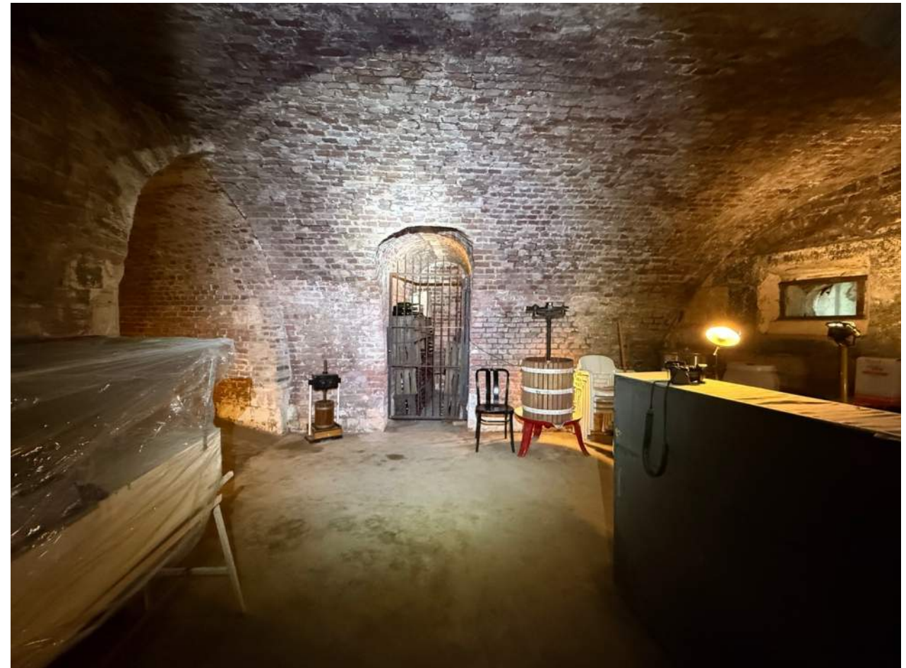
Afb. 12.00.07, overzicht geschutskamer richting tot als wijnkamer in gebruik zijnde kruitkamer
