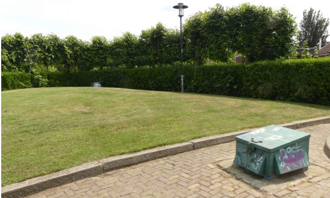
Afb. 12.00.03, overzicht aardedekking van het fort met twee afgedekte ventilatieschachten
