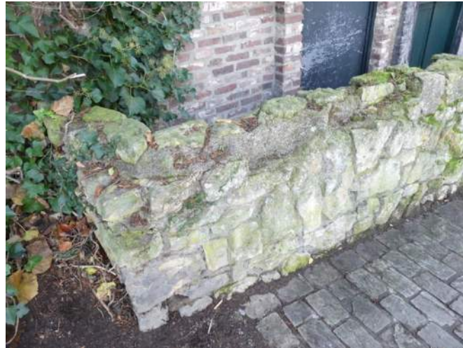
Afb. 07.35.10, ontbrekend blok natuursteen en begroeiing
