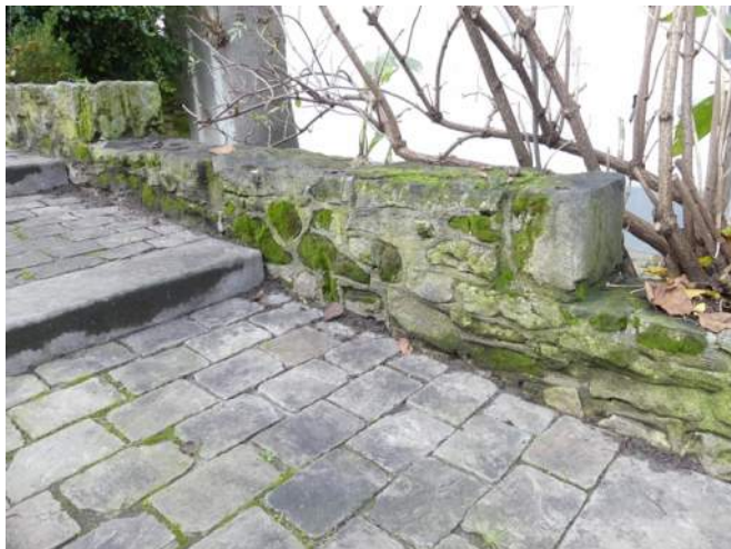
Afb. 05.35.11, losgekrompen voegwerk
