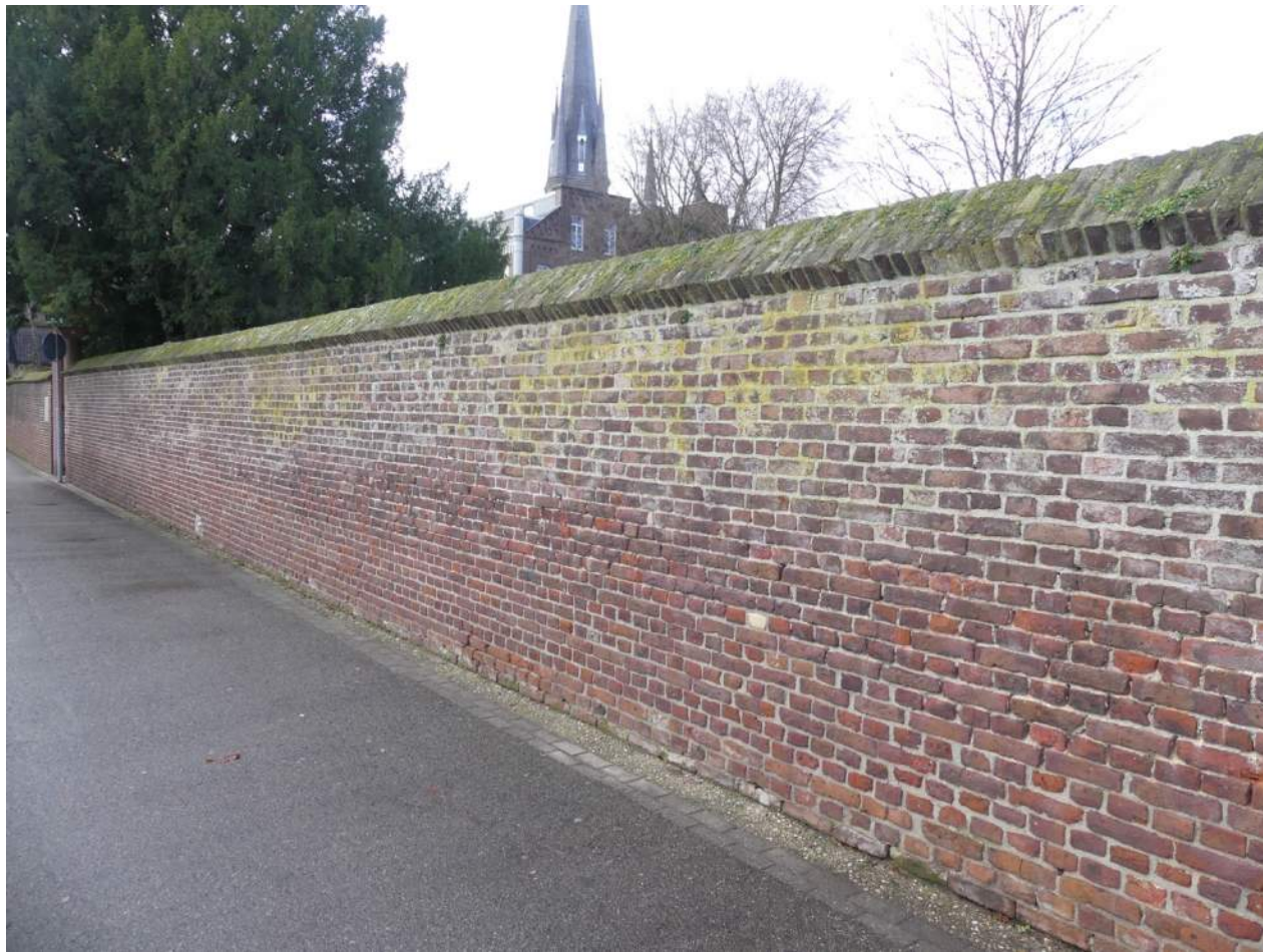
Afb. 04.00.17, overzicht (deel) buitenzijde van de oostelijke muur Ursulinentuin
