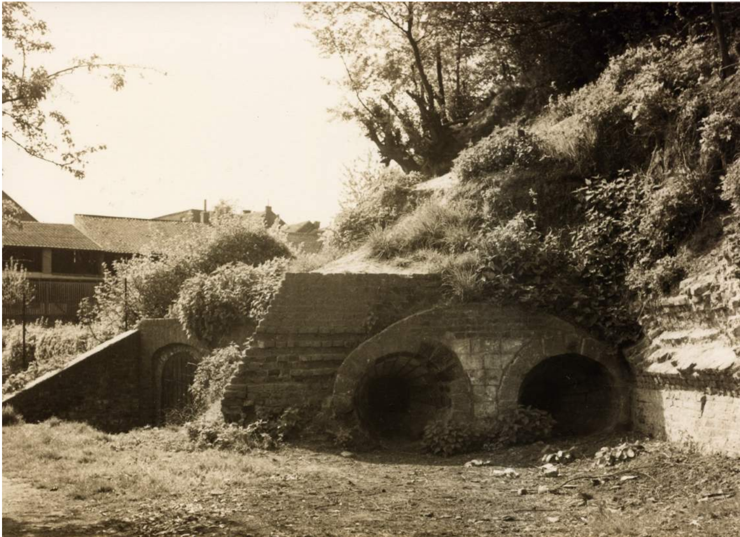
Afb.05, Fort Sanderbout, het enige zichtbare bolwerk uit de oude vestingwerken van Sittard (ra Sittard-Geleen)
