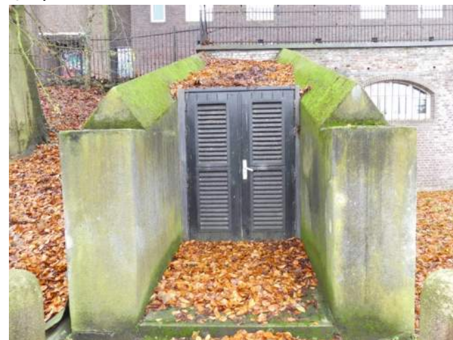
Afb. 04.21.01, aanzicht betonafgedekte muren
