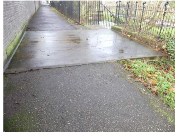
Afb. 05.21.01, overzicht bovenzijde betondek onderdoorgang
