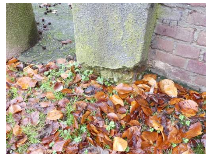
Afb. 04.21.04, afgebroken voetstuk
