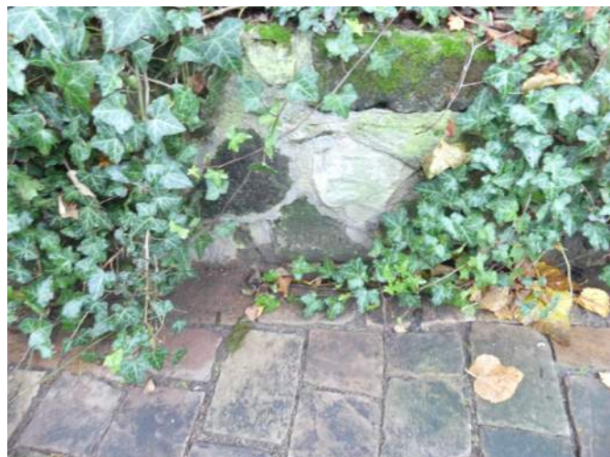
Afb. 01.35.03, losgescheurd voegwerk
