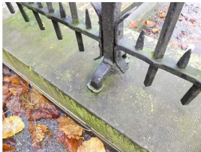
Afb. 04.43.05, originele voeten in gietlood bevestigd in afdekken
