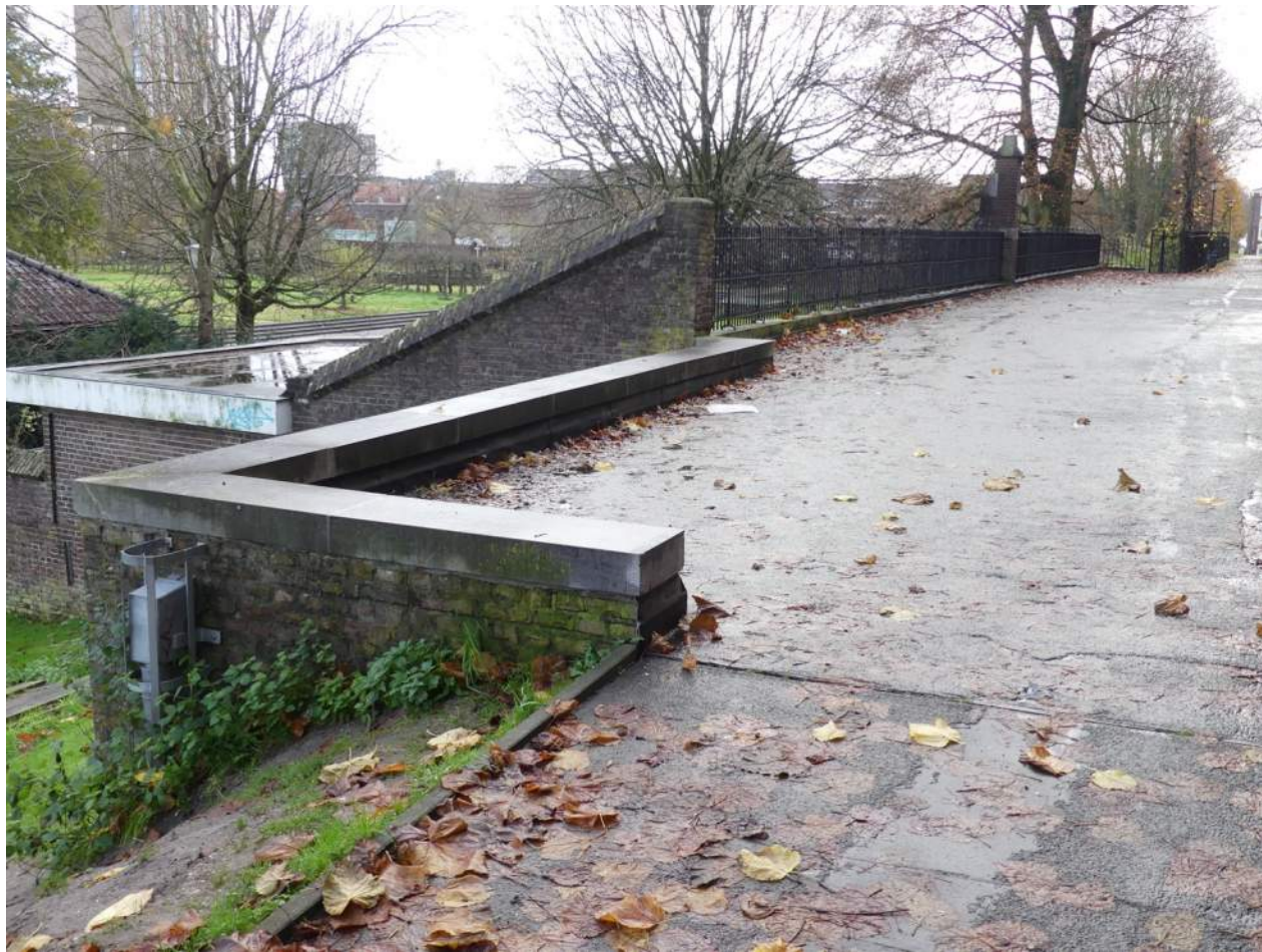
Afb. 04.00.02, overzicht van de bovenzijde van het eerste deel van de walmuur op de Dominicanenwal
