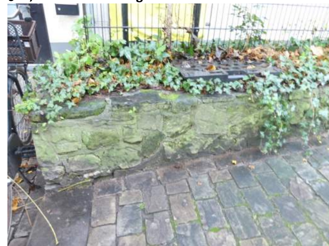
Afb. 01.35.01, losgescheurd voegwerk
