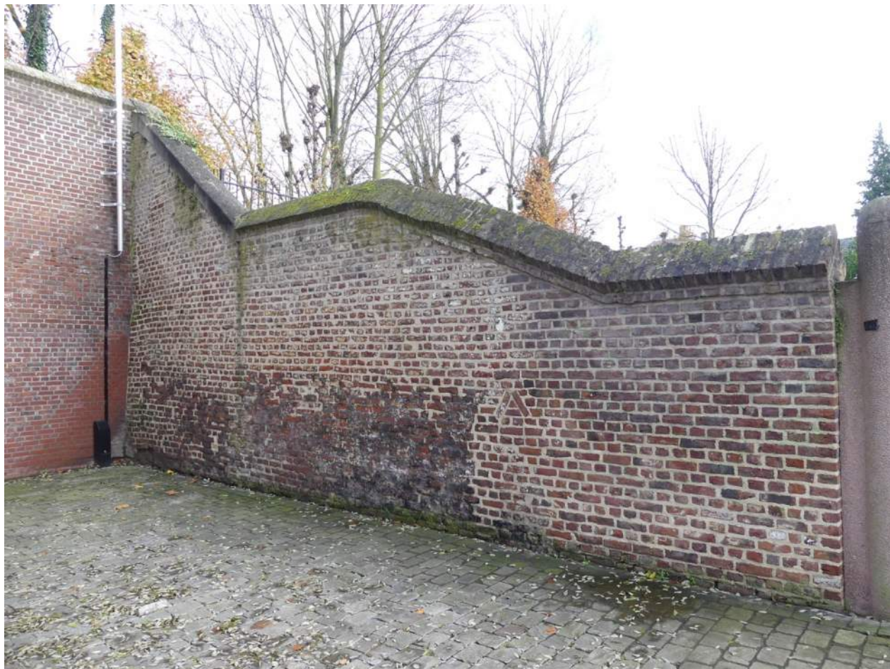
Afb. 05.00.12, overzicht buitenzijde muur langs Jardin d'Isabelle, tegen Dominicanenwal
