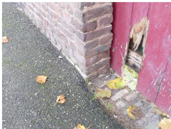
Afb. 03.30.02, beschadigd houtwerk
