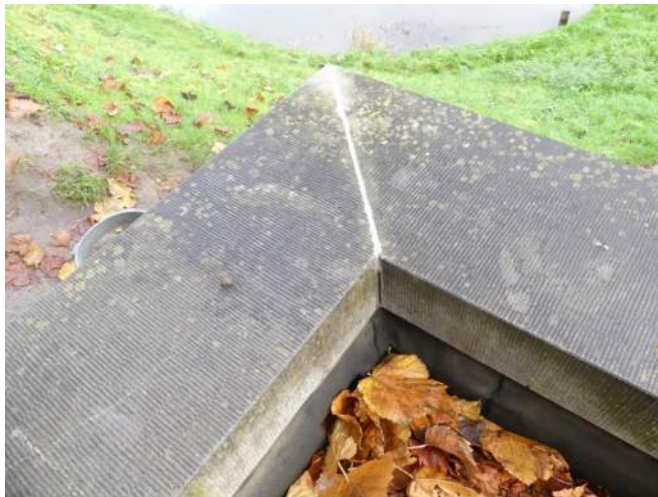
Afb. 04.35.19, foutief uitgevoerd hoekdetail (normaal met zgn. 'omlopende' kop ipv diagonaal gezaagd) en slecht kitwerk
