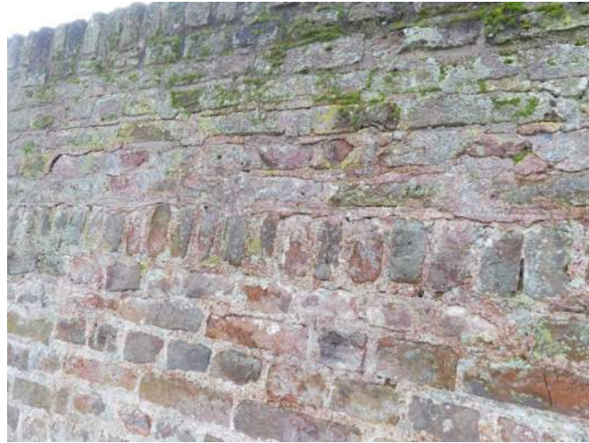
Afb. 03.22.02, losgescheurd metselwerk
