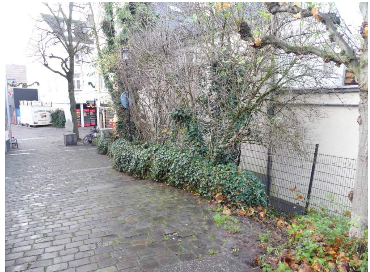
Afb. 01.00.03, overzicht (restanten van de) stadsmuur aan de Begijnenhofwal
