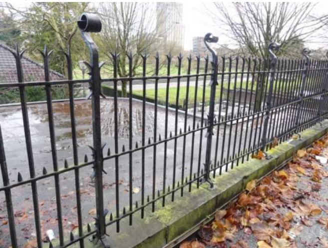
Afb. 04.43.01, overzicht smeedijzeren hekwerk
