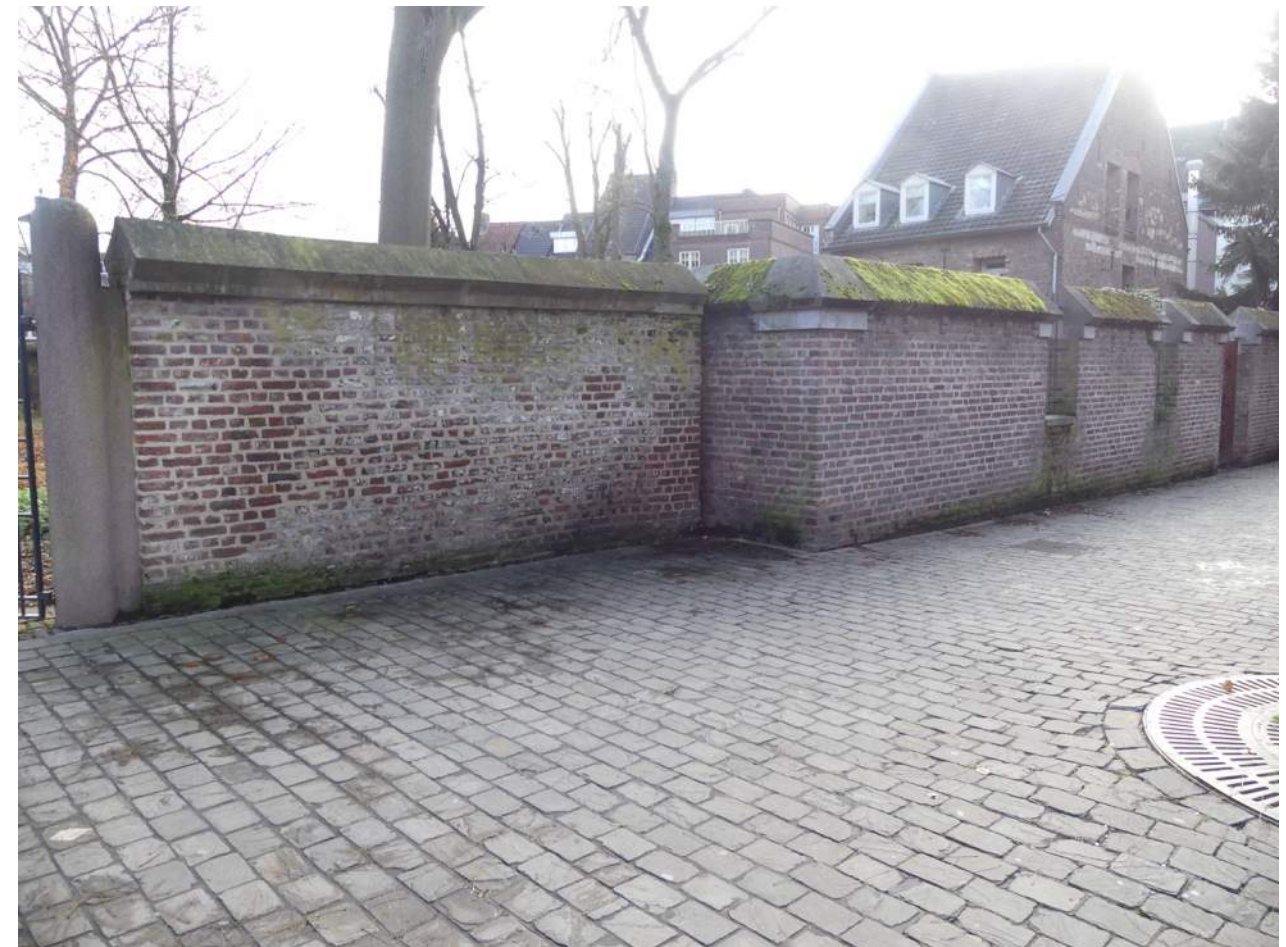
Afb. 05.00.14, overzicht rechter muurdeel langs Jardin d'Isabelle, richting bebouwingsblok aan de Markt
