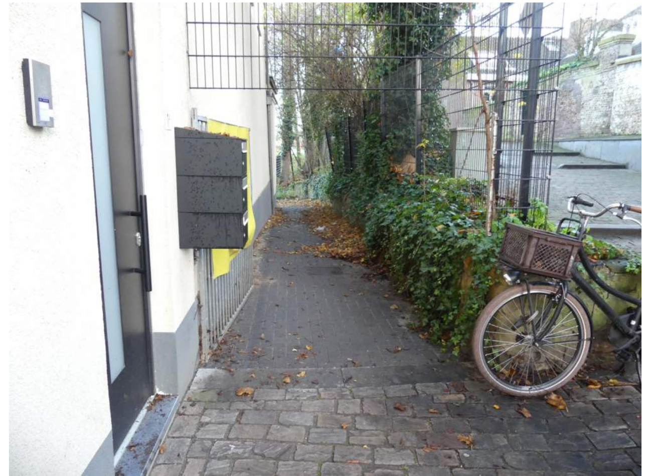
Afb. 01.00.02, overzicht (restanten van de) stadsmuur aan de Begijnenhofwal
