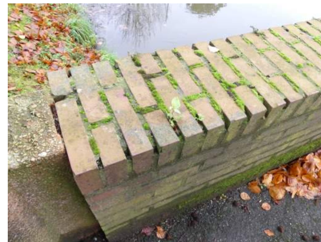
Afb. 04.22.35, alg- en mosgroei en uitgespoeld voegwerk op de rollaag
