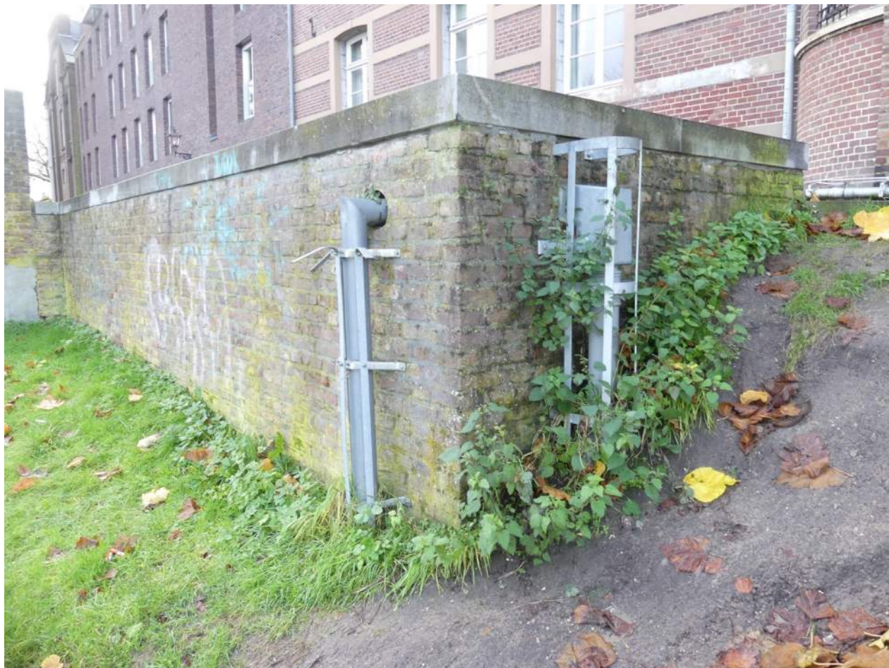
Afb. 04.00.03, overzicht noordwestelijk deel van de walzijde van de walmuur
