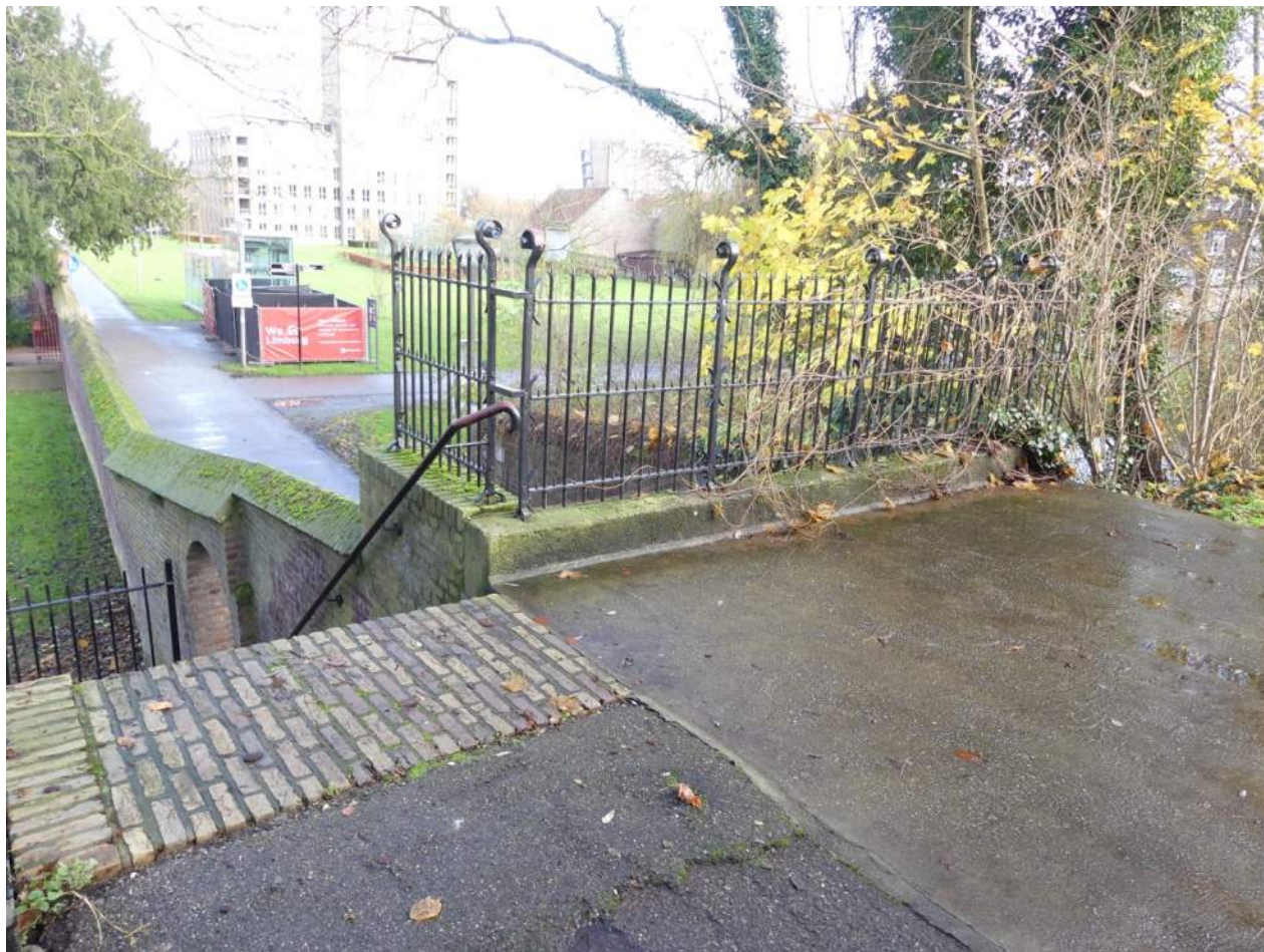
Afb. 05.00.05, overzicht buitenzijde onderdoorgang met trap (binnen Ursulinentuin, maar met hek afgesloten van)
