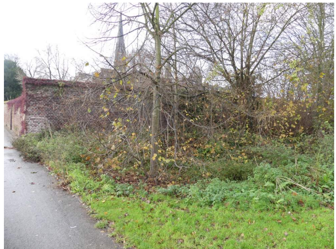
Afb. 04.00.16, overzicht oostelijke hoek noordelijke en oostelijke muur Ursulinentuin
