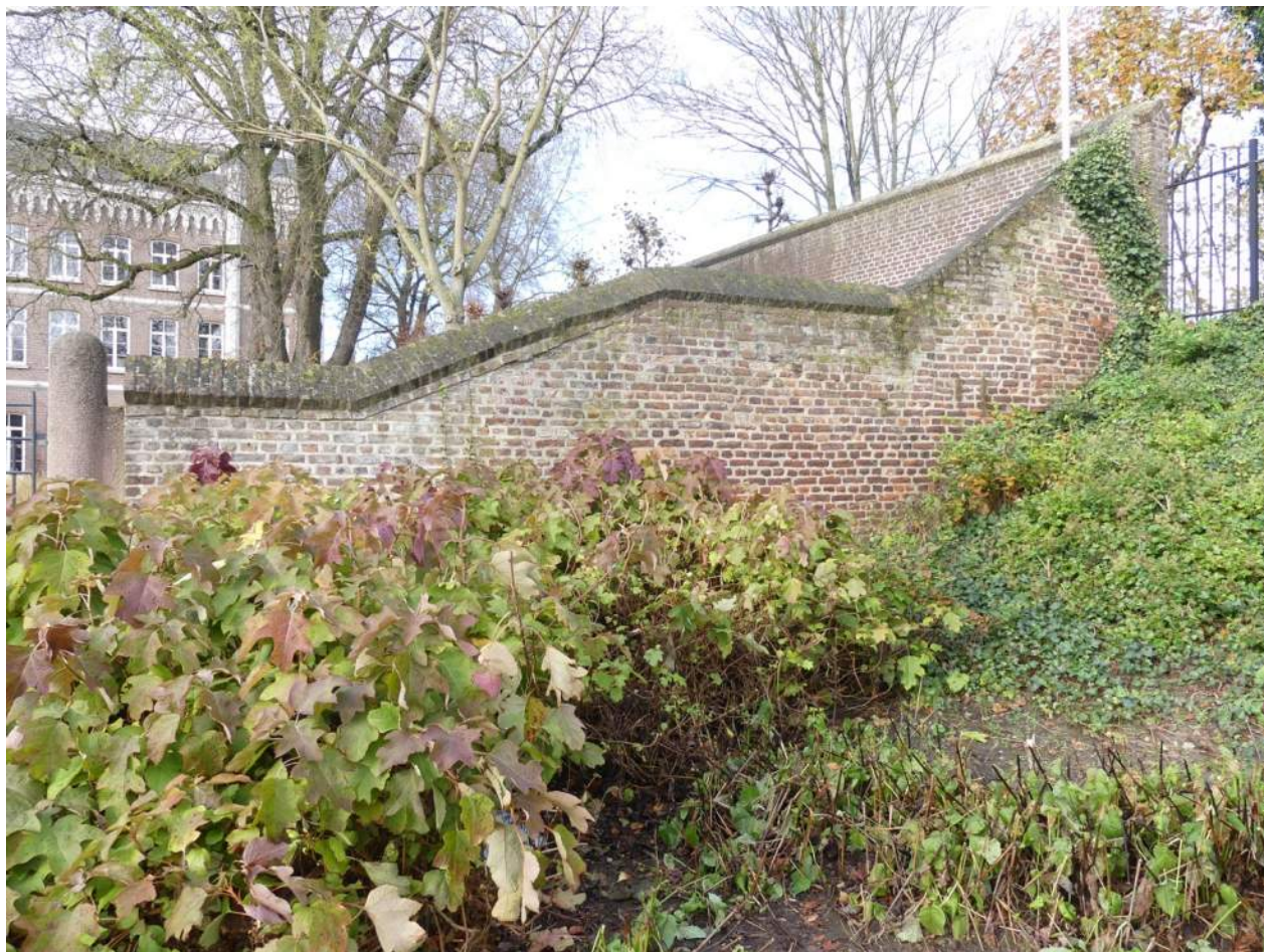
Afb. 05.00.16, overzicht binnenzijde muur langs Jardin d'Isabelle, tegen Dominicanenwal
