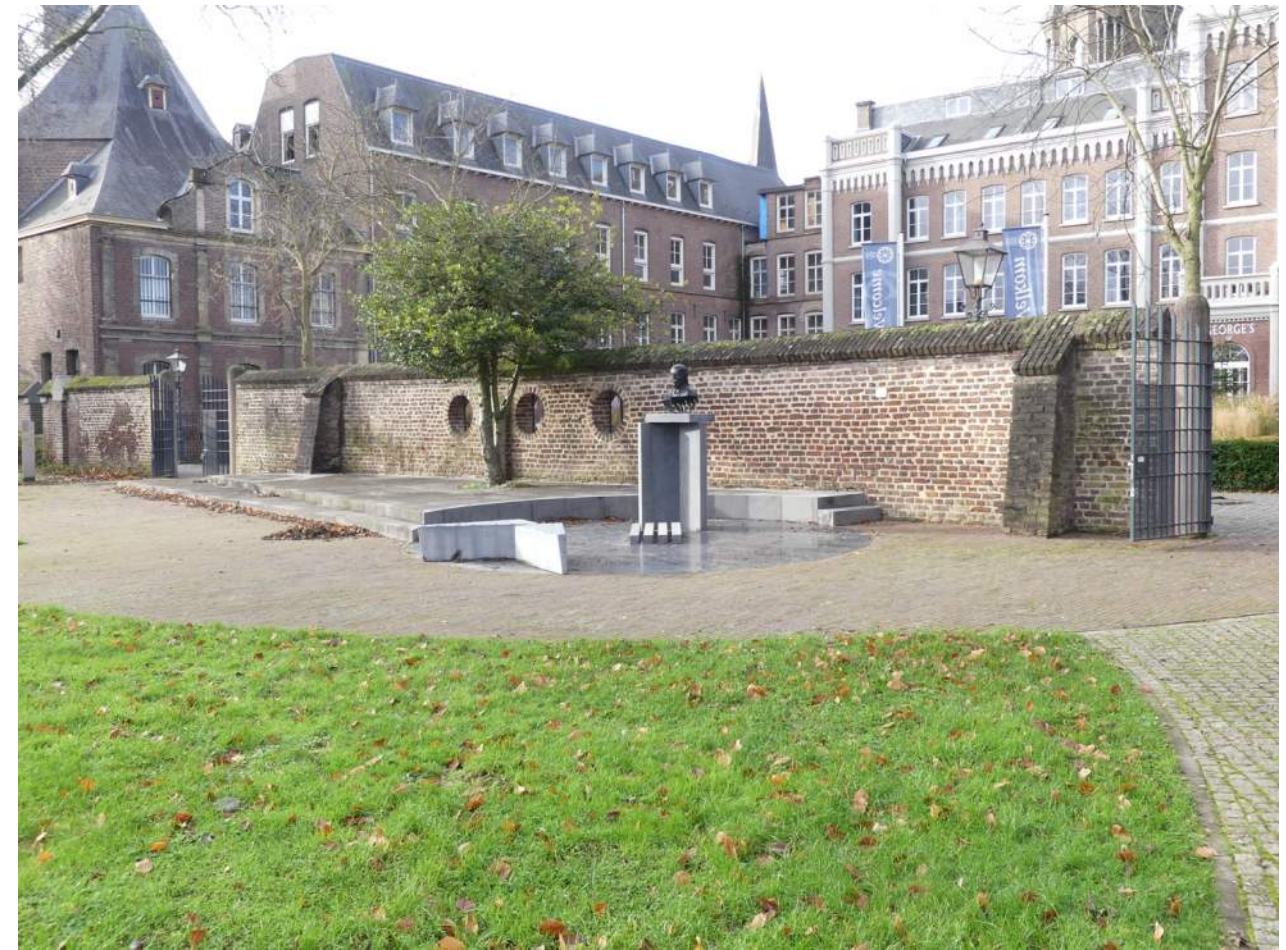
Afb. 05.00.17, overzicht binnenzijde middelste muurdeel langs Jardin d'Isabelle
