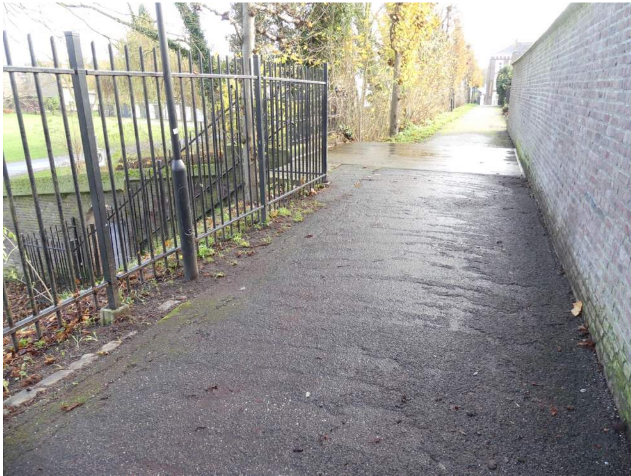
Afb. 05.00.04, overzicht Dominicanenwal richting Paardestraat met onderdoorgang naar Kerkepad
