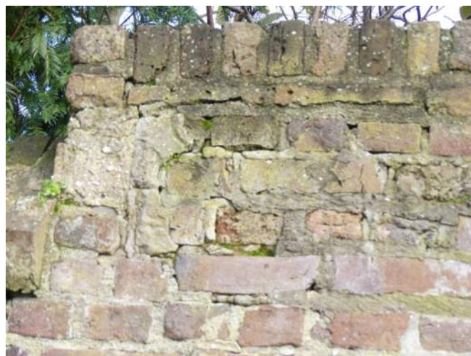
Afb. 04.22.39, cracquelé voegwerk en bijzondere herstellingen
