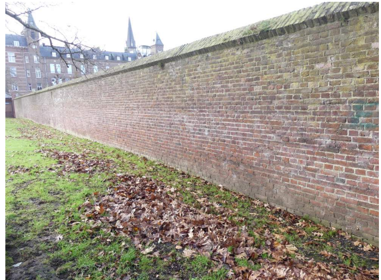
Afb. 04.00.11, overzicht binnenzijde westelijke muur Ursulinentuin
