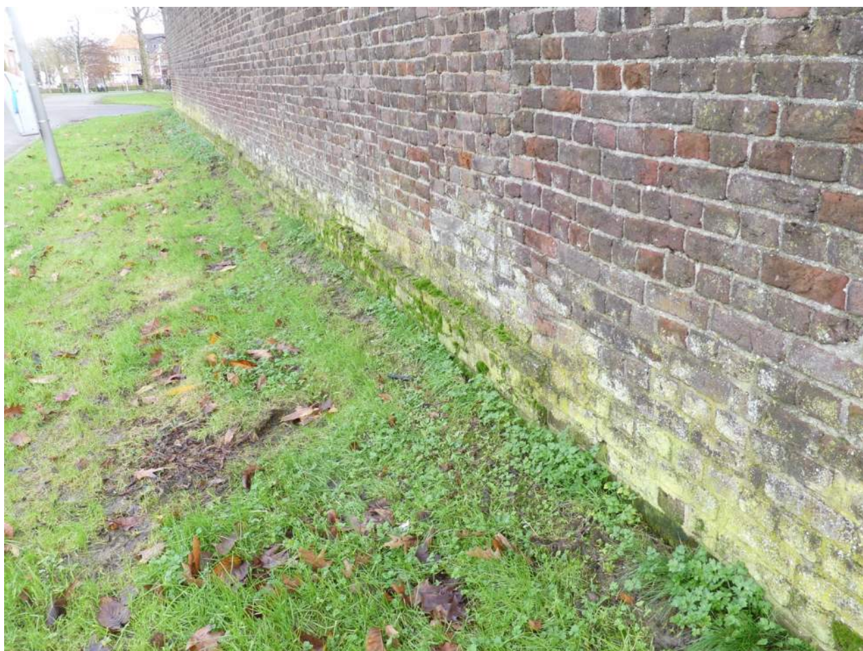
Afb. 04.00.14, overzicht (deel) van de buitenzijde van de westelijke muur Ursulinentuin
