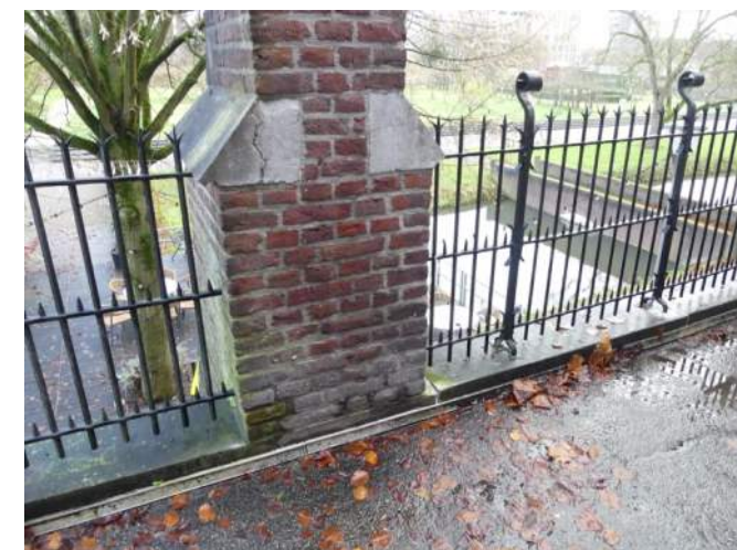
Afb. 04.35.16, gescheurd afzaatblok in penant
