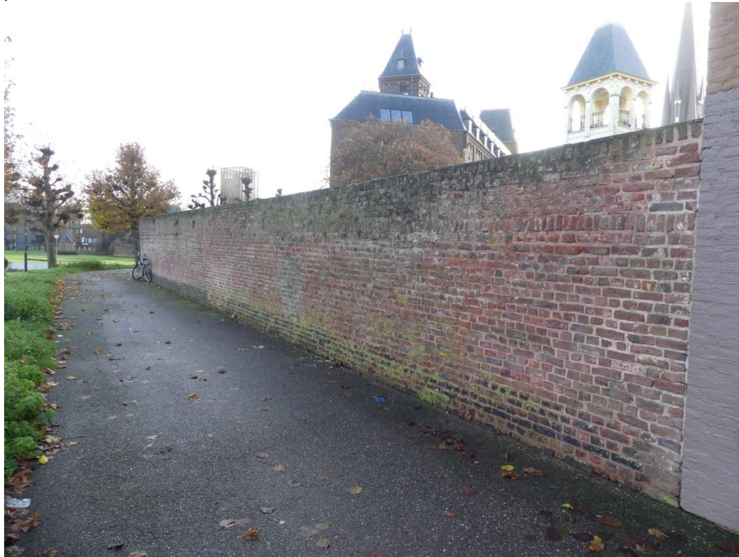
Afb. 03.00.01, overzicht westelijke blinde muur
