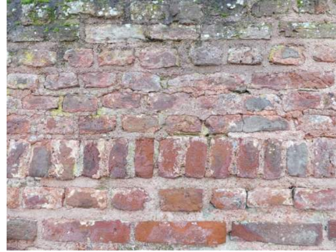
Afb. 03.22.13, cracquelé voegwerk
