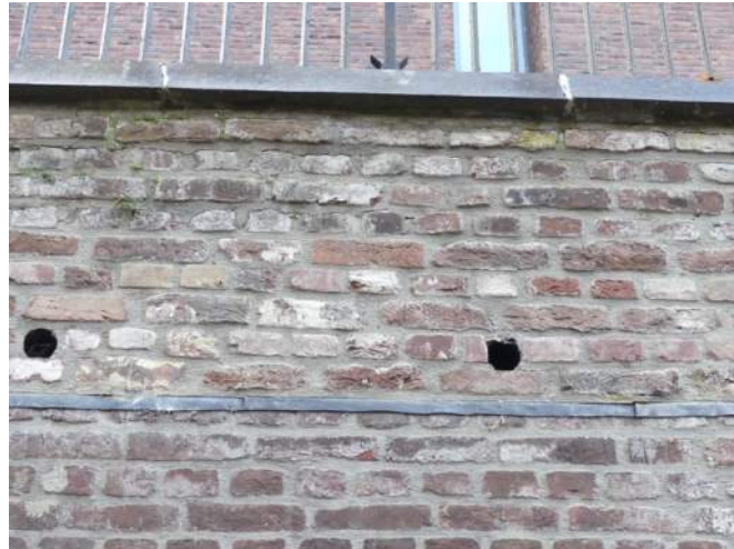
Afb. 04.22.02, gescheurd metselwerk onder afdek
