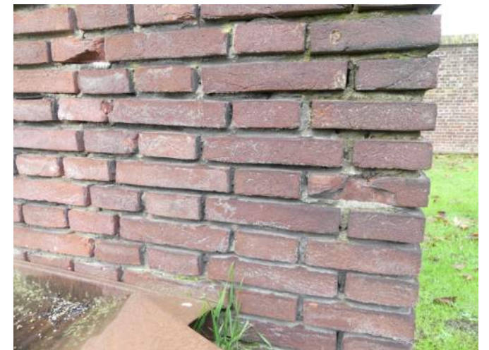
Afb. 04.22.12, afgebroken stenen
