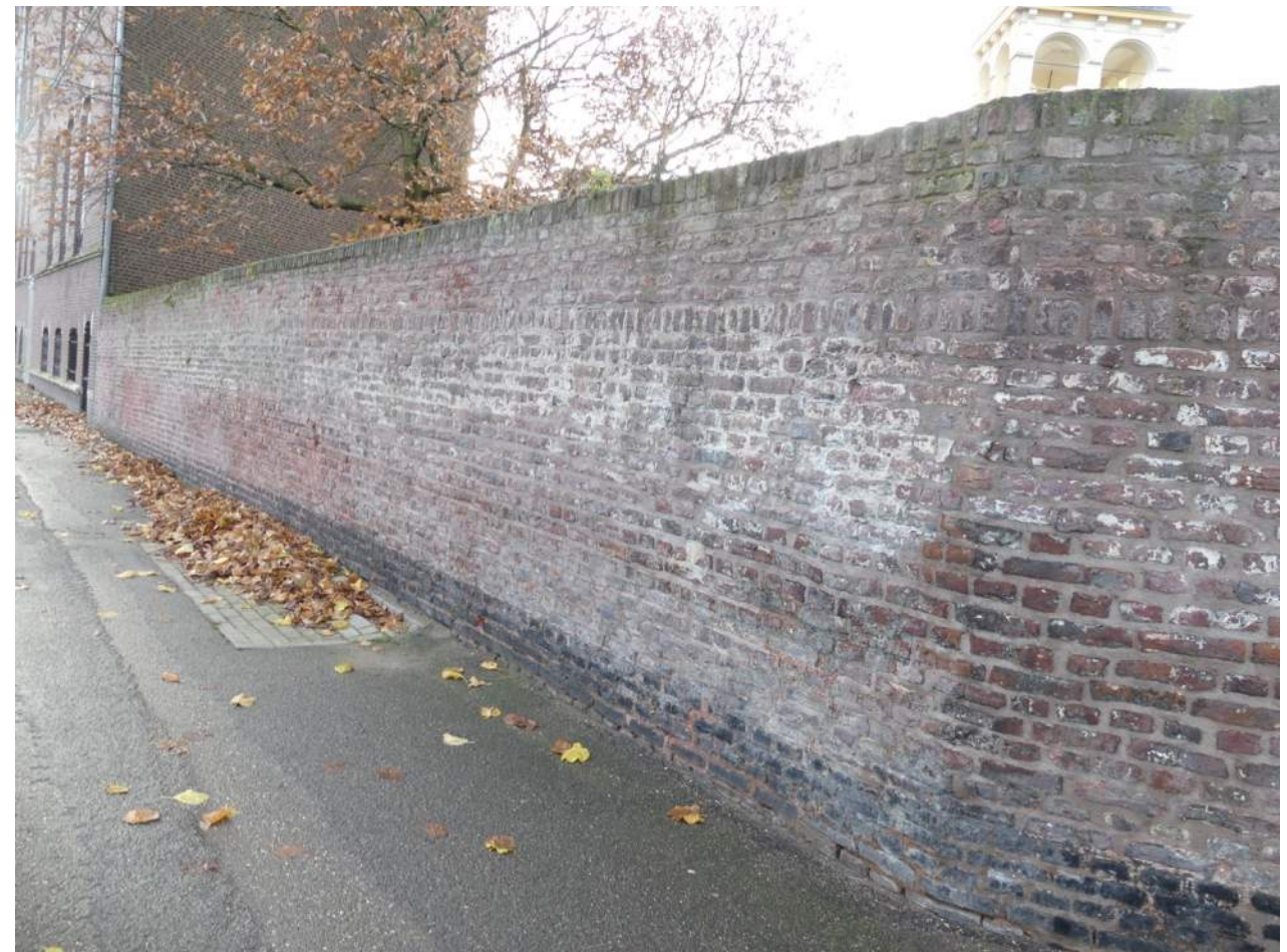
Afb. 03.00.03, overzicht oostelijke blinde muur
