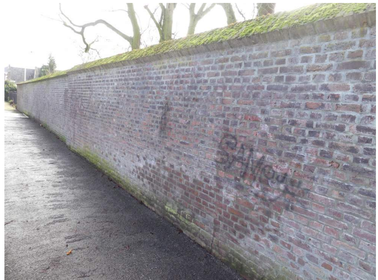
Afb. 05.00.03, overzicht van de muur naast het voorplein van het Jezuïeten Internaat (op de Dominicanenwal) richting Paardestraat
