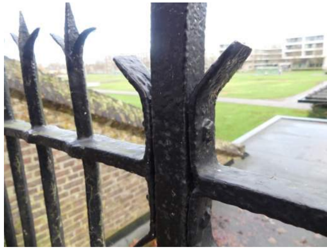
Afb. 04.43.03, hekwerkbeugels met zeskantbouten en...
