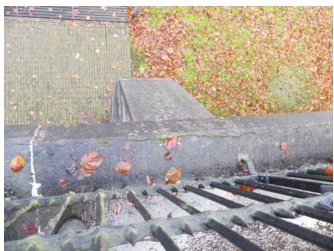
Afb. 04.35.08, losgebarsten neus aan de afdek (staand leger??)
