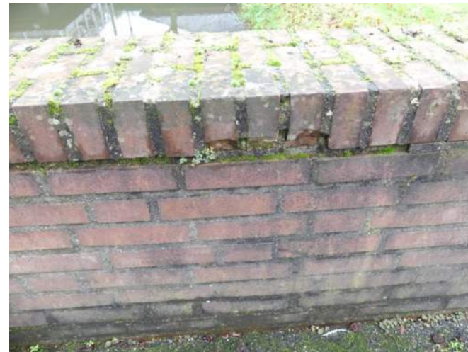
Afb. 04.22.09, afgebroken stenen, alg- en mosgroei
