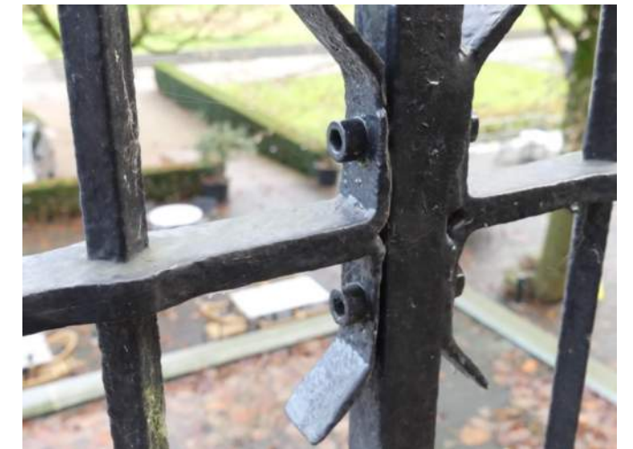
Afb. 04.43.10, hekwerkbeugels met inbusbouten aan baluster bevestigd.....
