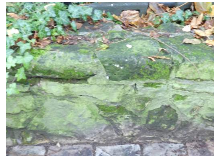
Afb. 01.35.02, losgescheurd voegwerk
