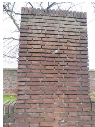
Afb. 04.22.11, afgebroken stenen
