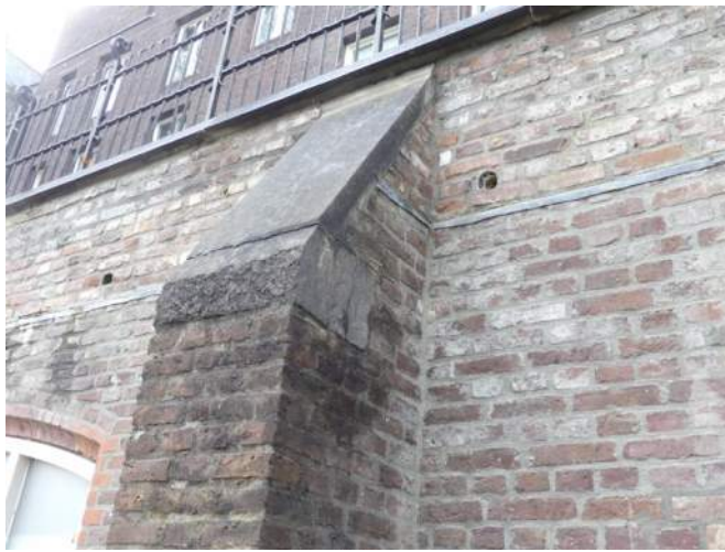
Afb. 04.35.17, afgehaakte neus afzaatblok penant
