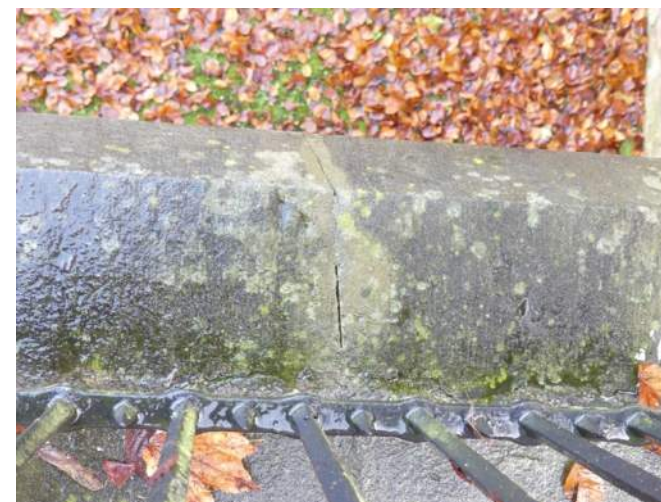
Afb. 04.35.25, losgebarsten mortelvoeg
