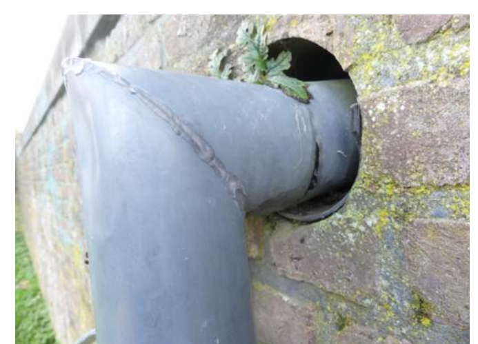
Afb. 05.30.02, losgetrokken bocht; met te weinig overlap uitgevoerd
