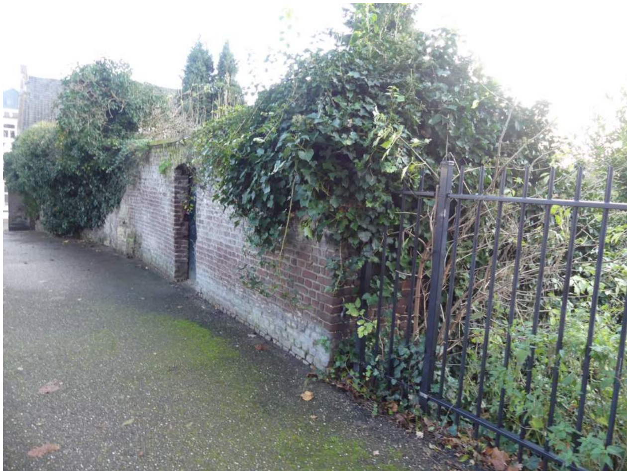
Afb. 05.00.08, overzicht walmuur langs privé-perceel, richting Paardestraat
