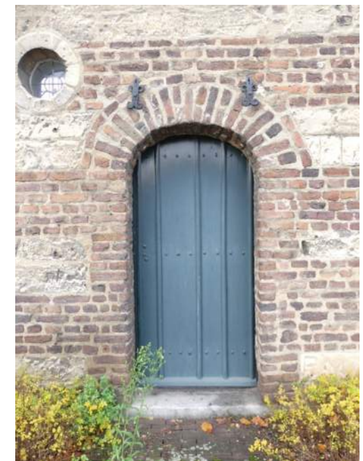
Afb. $46.14, door inwerking UV-straling vaal geworden schilderwerk op poort aan oostgevel (NB: onder rollaag nog glans op schilderwerk)
