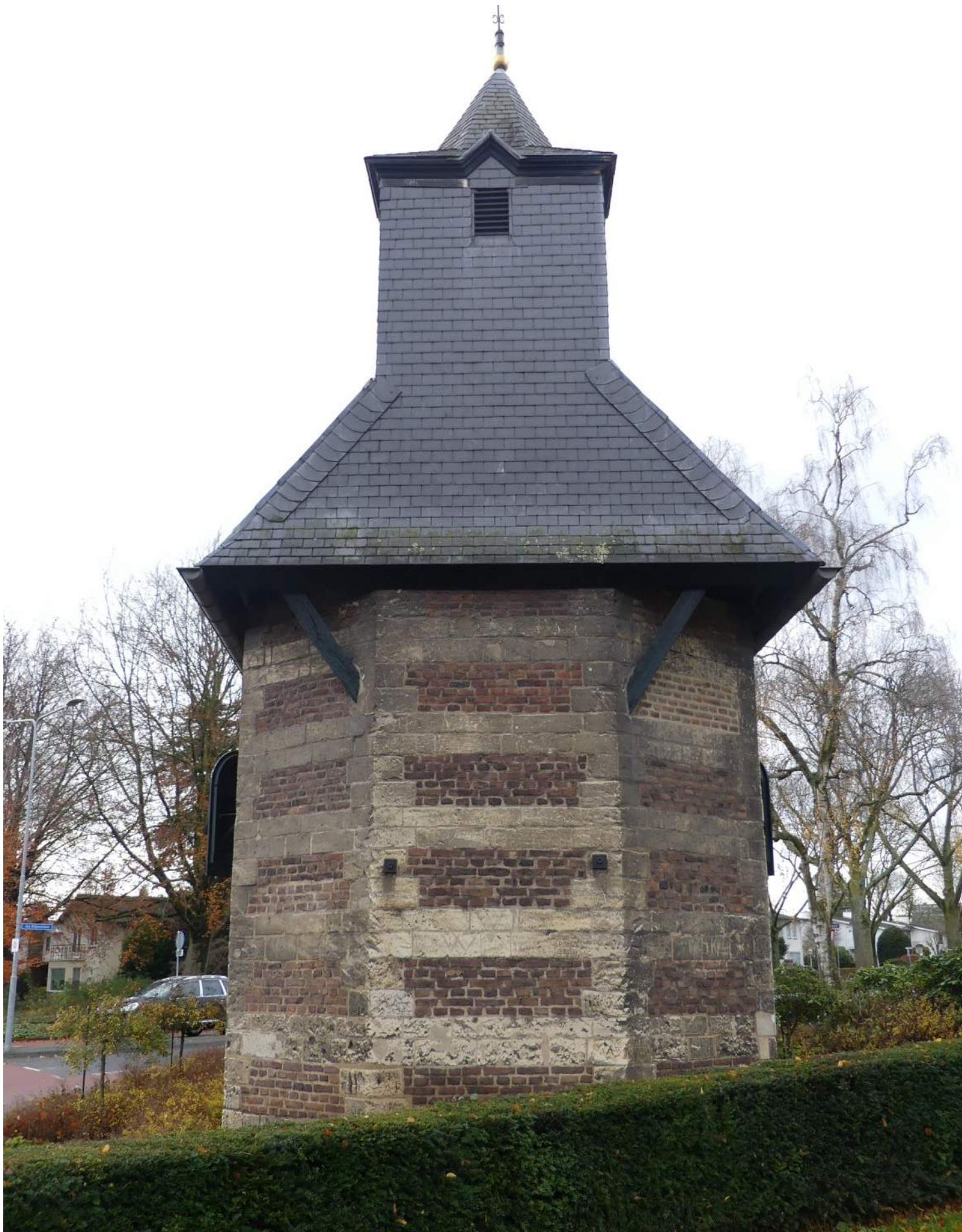
Afb. 08: noordgevel van de Sint Janskluis
