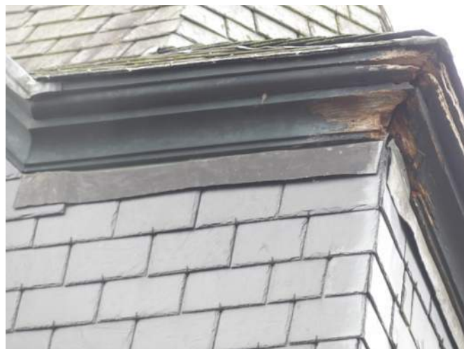
Afb. §24.05, detail beschadigde hoek met weggevalen stukken
