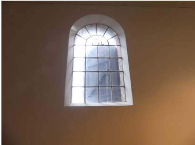
Afb. §34.01, overzicht blank glas in gietijzeren raamwerk
