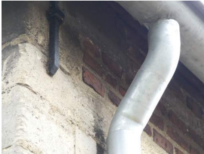
Afb. §50.01, correct gepositioneerde uitloop, ongesoldeerde, -getrokken bochten
