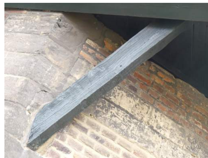
Afb. §46.19, schraal, amper dekkend schilderwerk op houten schoren dakruiter
