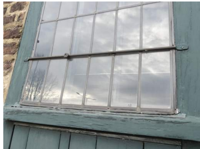
Afb. §34.04, ontbrekende loodveter aan bindroede, nageltjes in randlood
