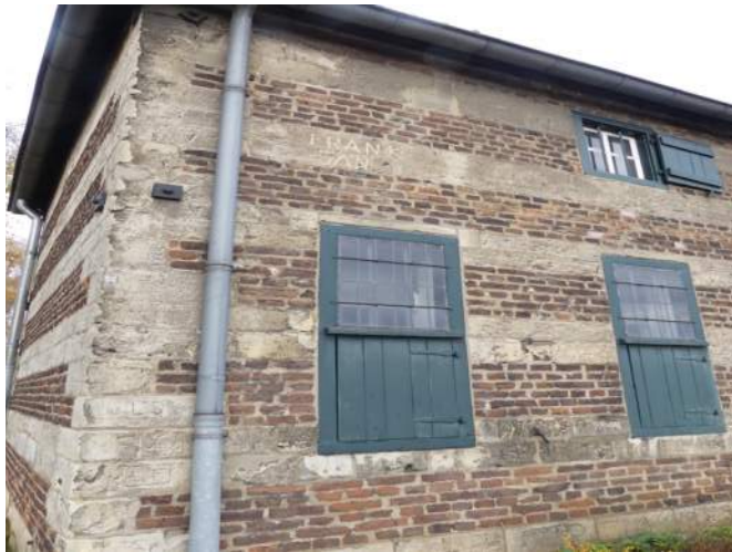
Afb. $46.05, overzicht schilderwerk gevelkozijnen oostgevel
