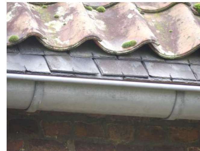
Afb. §33.18, foutieve leihaken (met klembek) op voetleien, een enkele voetlei is 'in de haak gezakt' (links op foto)
