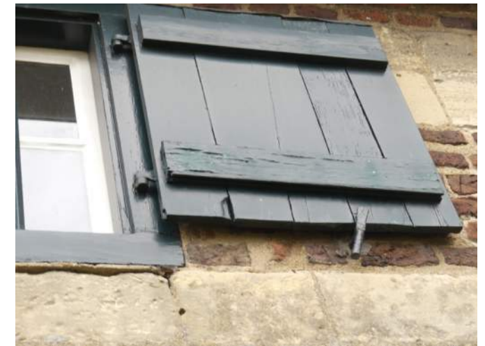
Afb. $46.12, ernstig gebarsten en loslatend schilderwerk van luikklampen
