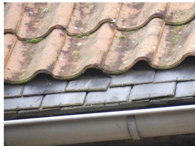
Afb. §33.09, scheefzakkende en uitgevallen voetleien, foutieve leihaken (met klembek)
