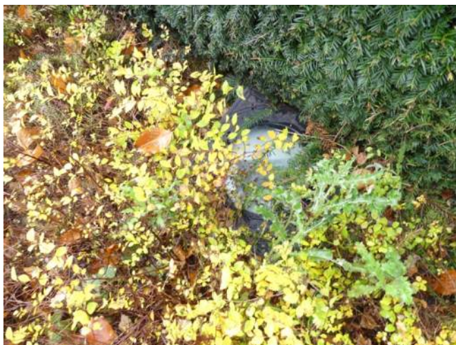
Afb. §70.01, verlichtingsspot in de grond
