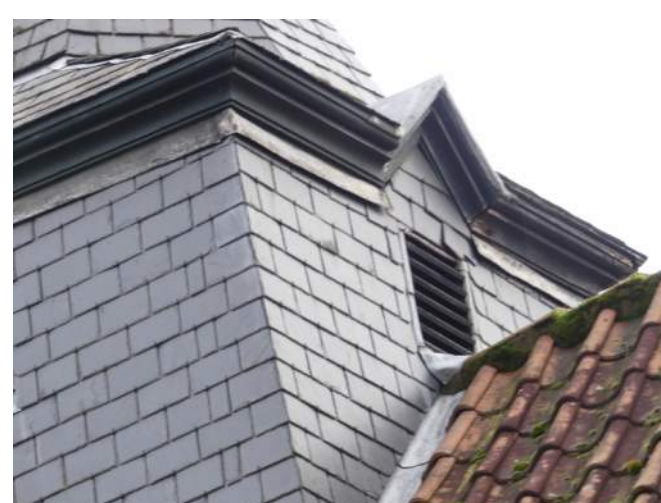
Afb. §33.21, overzicht staand leiwerk dakruiter
