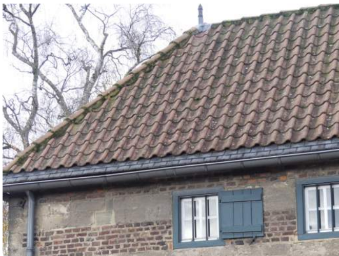
Afb. §33.01, overzicht achterste deel oostzijde dak, vh pannen met nok- en schubvorsten op nok en hoekkepers
