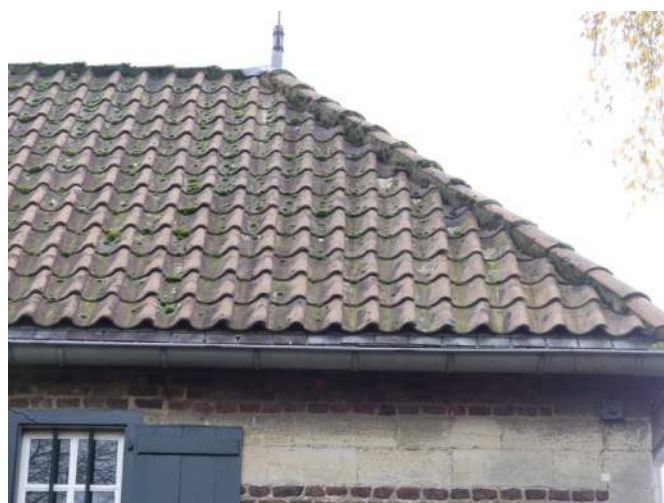
Afb. §33.15, overzicht achterste deel westzijde dak
