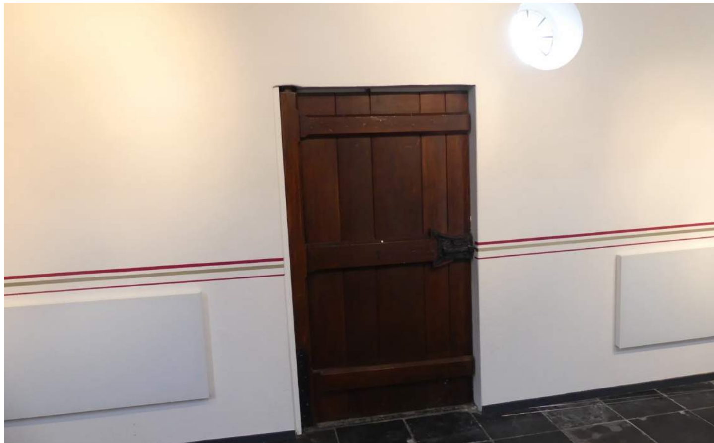
Afb. 14: westzijde interieur langsgevel met toegangspoort
