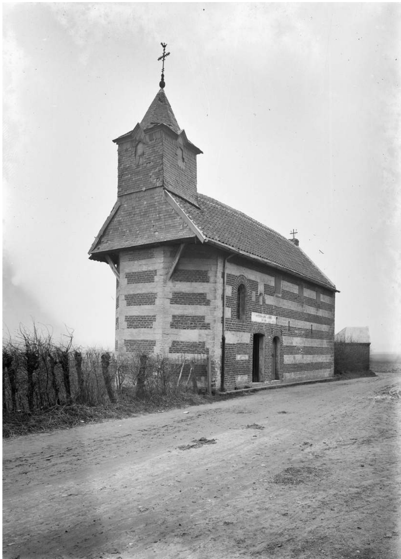
Afb. 05: noord- en westzijde van de kluis met het pad (latere Kluis) aan de westzijde. Aan de zuidzijde de opgaande topgevel, bekroond met een eenvoudig Passiekrus. Achter de kluis een klein kapelletje. Onderaan de westzijde van het met pannen gedekt zadeldak al een strook met enkele lagen voetleien boven een mastgoot met aan de noordzijde een hemelwaterafvoer, februari 1921. (RCE)
