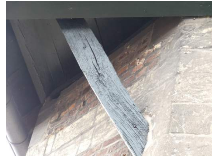
Afb. §24.10, detail overstek dakruiter, ingewaterd hout
