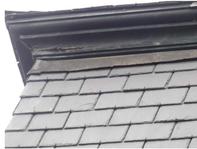
Afb. §24.07, detail hoek met ingerotte stukken
