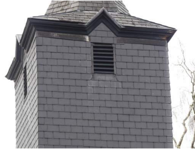
Afb. §24.02, overzicht noordzijde dakruiter
