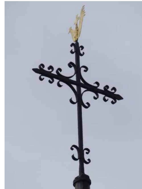
Afb. §46.23, roestvorming op smeedijzeren torenkruis en decoratie
