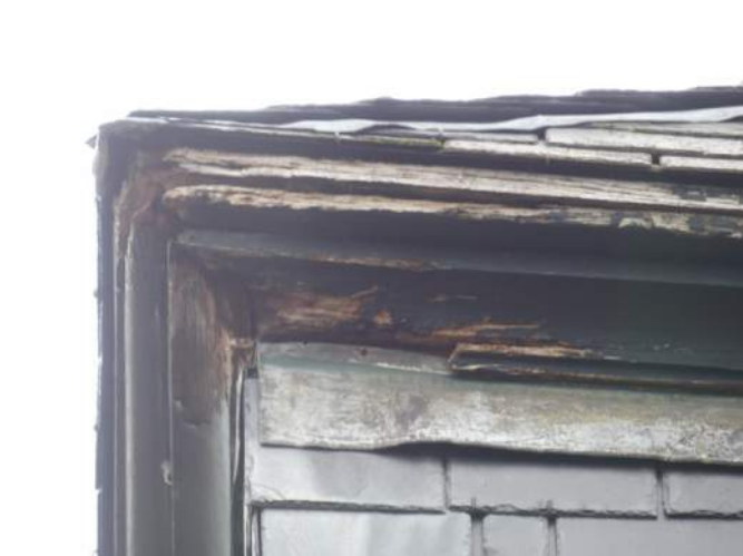
Afb. §24.06, detail beschadigde hoek met weggevalen stukken
