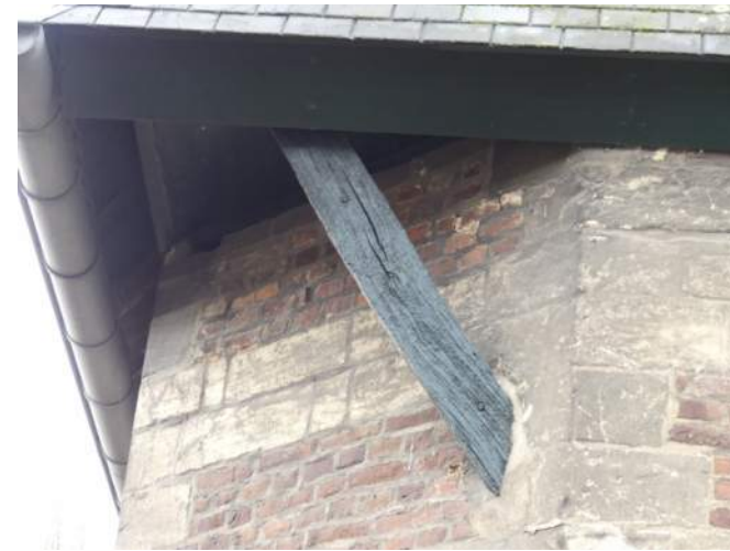
Afb. §24.09, overzicht overstek dakruiter
