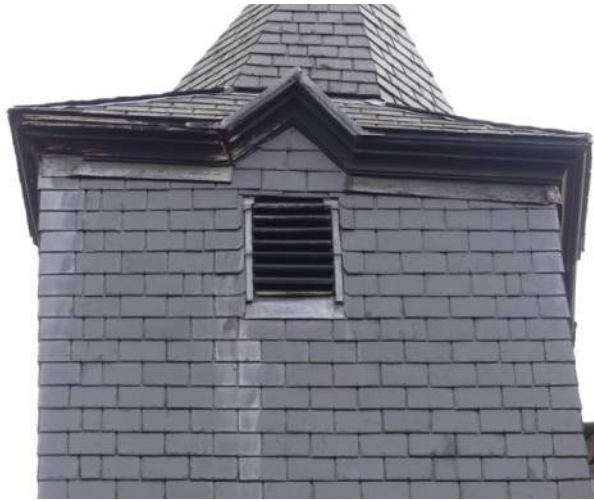
Afb. §24.01, overzicht westzijde dakruiter
