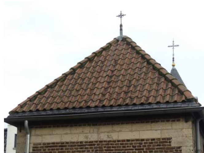
Afb. §33.07, overzicht zuidzijde dak
