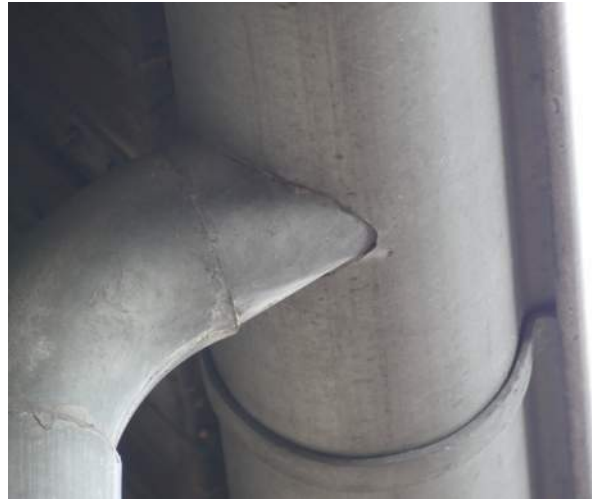
Afb. §50.02, foutief gepositioneerde uitloop met onge-, soldeerde, getrokken bochten
