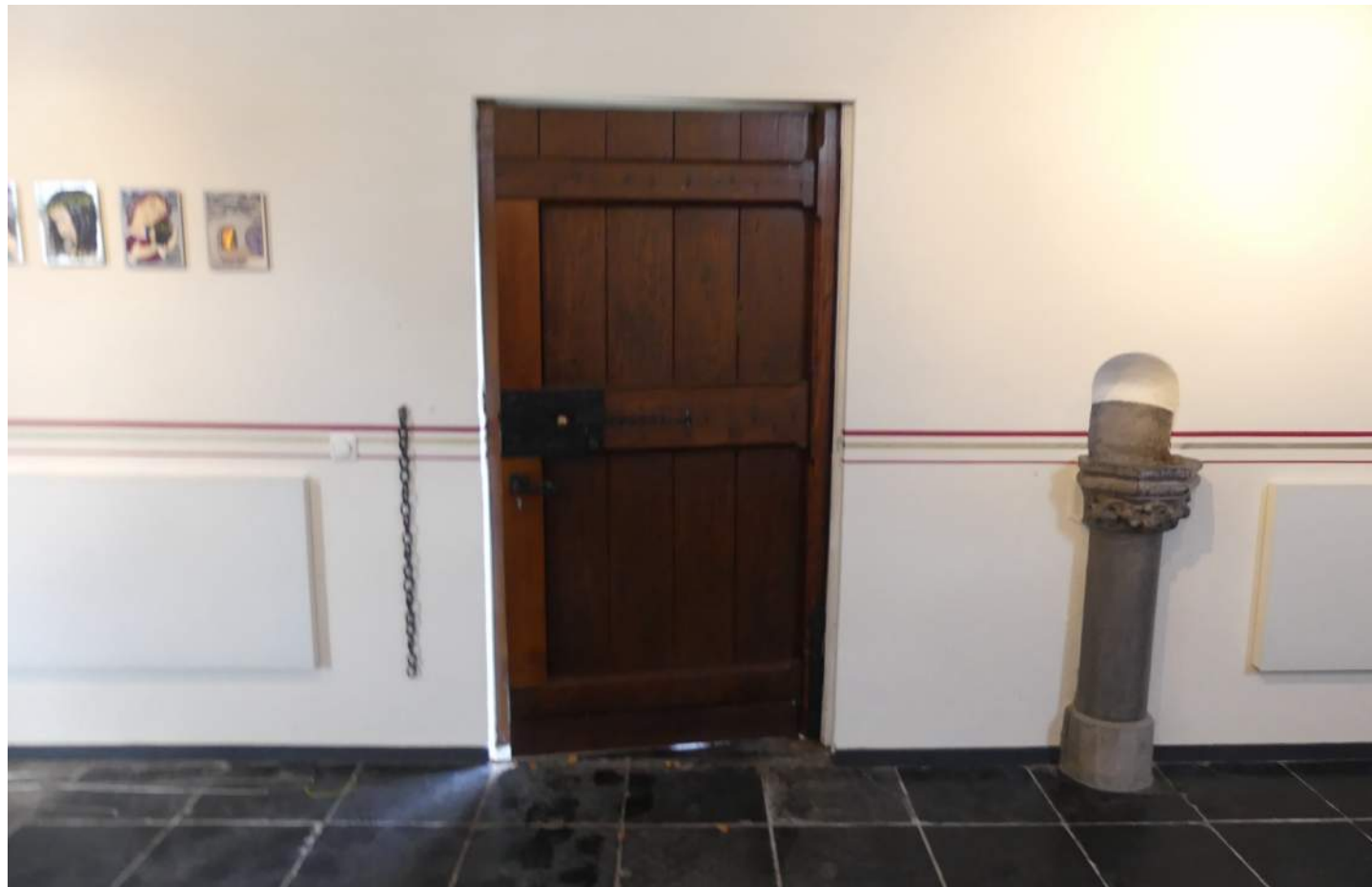
Afb. 13: oostzijde interieur langsgevel met poort
