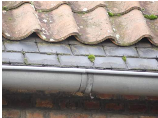
Afb. §33.04, foutieve leihaak toegepast (met klembek), mosbegroeiing tussen de voetleien
